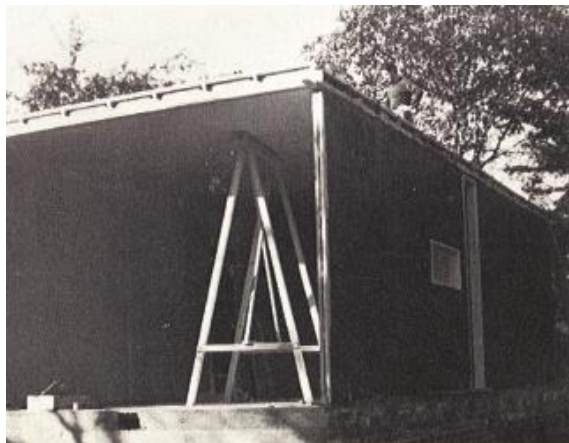
Fig. 2b Maison ELCOHA, chantier
