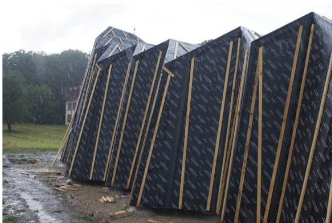
Fig. 20 Enveloppe d'étanchéité sous bardage
