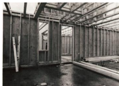
Fig.13 Chantier ossature bois
