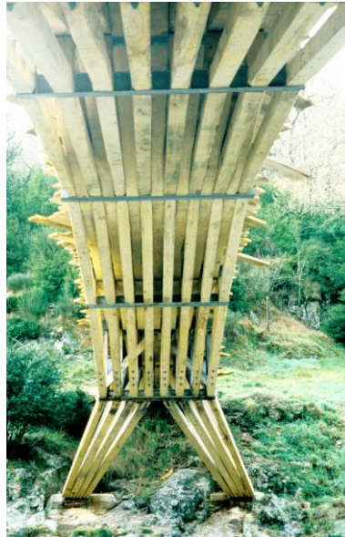
Fig. 4 Sous-face de la passerelle
