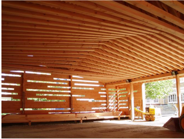
Fig. 7 Chevrons formant fermes de l'Ecole Corneille
