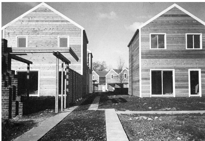
Fig. 37 Pignons en bardage de Red Cedar
