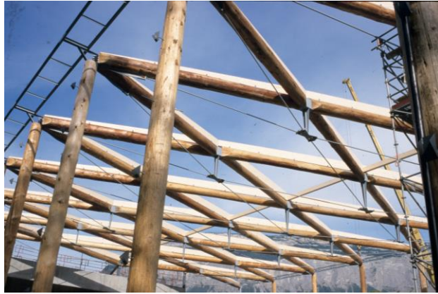
Fig. 1 Charpente du gymnase de Meylan
