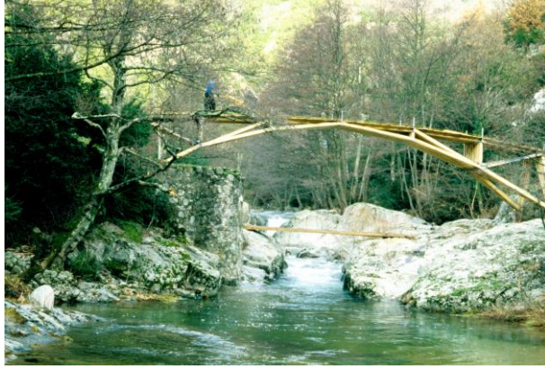
Fig.2 Passerelle vue depuis l'aval de l'Auzène
