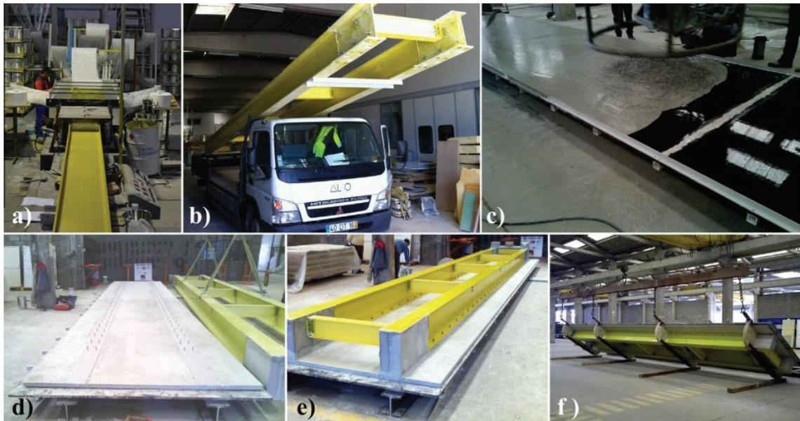
FIGURE 2.25: Construction du pont (Gonilha et al. 2014) (a) Pultrusion des profilés (b) Transport des poutres complètes (c) Coulage du béton (d) Mettre la colle en place (e) Assemblage des éléments (f) Mettre la poutre en position finale
