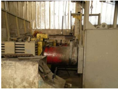
Chevêtre mobile côté Ouest
