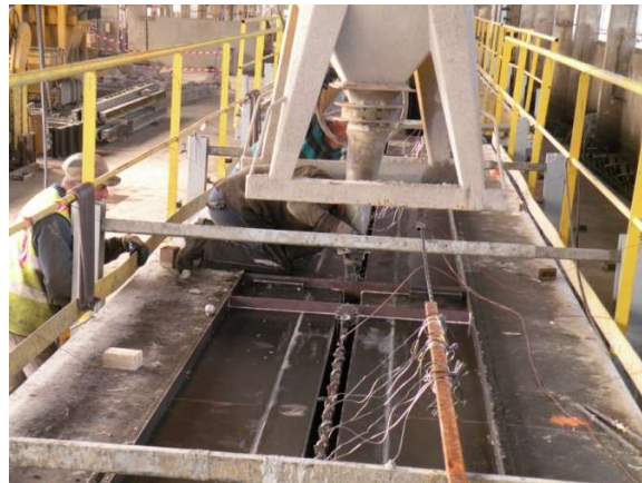
Figure 177: Fabrication des poutres en BFUP A
