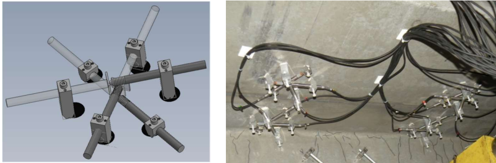
Figure 203: montage des capteurs de déplacement en rosette
