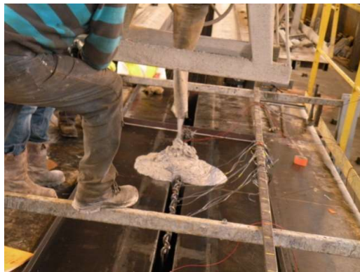
Remplissage du plot ouest
