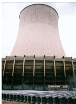
Figure 1: Vue des poutres en BFUP de la centrale nucléaire de Cattenom
