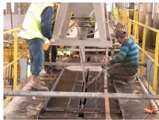
Remplissage du plot central
