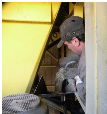
Figure 175: Mise en place des fibres dans le malaxeur
