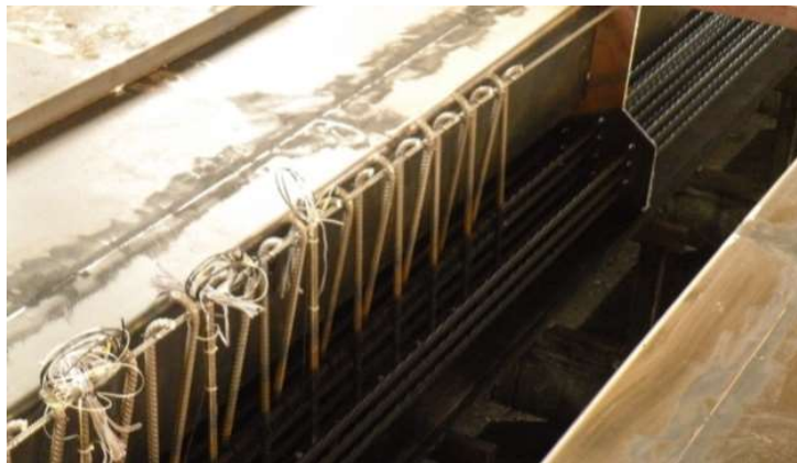
Figure 169: Maintien des armatures verticales dans le coffrage
