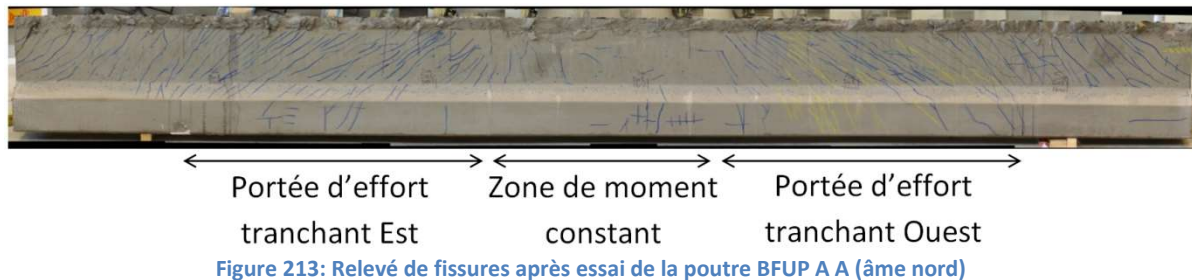
Figure 213: Relevé de fissures après essai de la poutre BFUP A A (âme nord)
