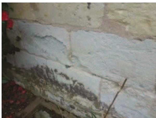
**Fig. 1.12 : Détachement en plaques – Bâtiment n°1 (Source : auteure)**
