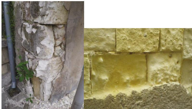
Fig. 2.2 : Altérations liées à la présence d'enduits ciments (photo : auteure)
