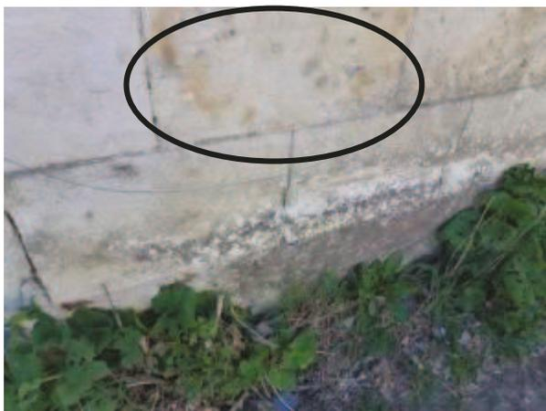
**Fig. 1.13 : Efflorescences – Bâtiment n°1**
