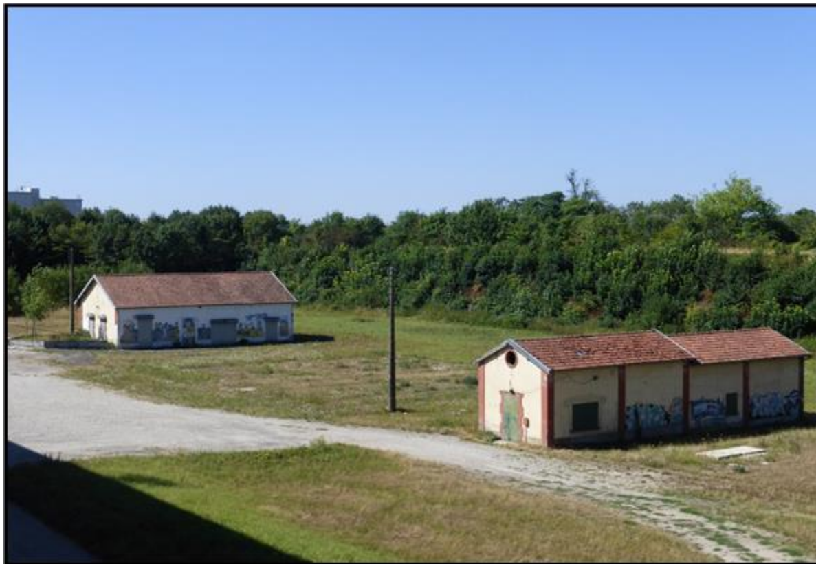
Illustration 42 : bâtiments 16 et 18, locaux de la ville prêtés ou loués à des associations.
