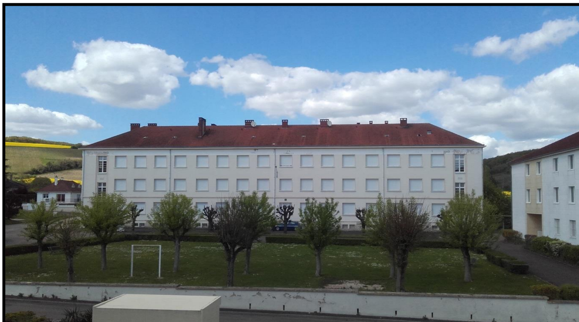
Illustration 37 : bâtiment 10 (sur la droite, le bâtiment 14, ancien bâtiment de logement de cadres transformé en hôtel)
