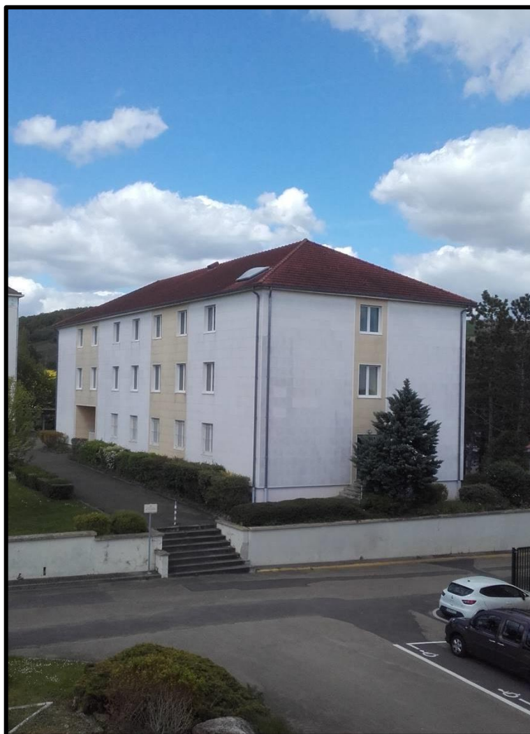
Illustration 35 : bâtiment 14 reconverti en hôtel.
