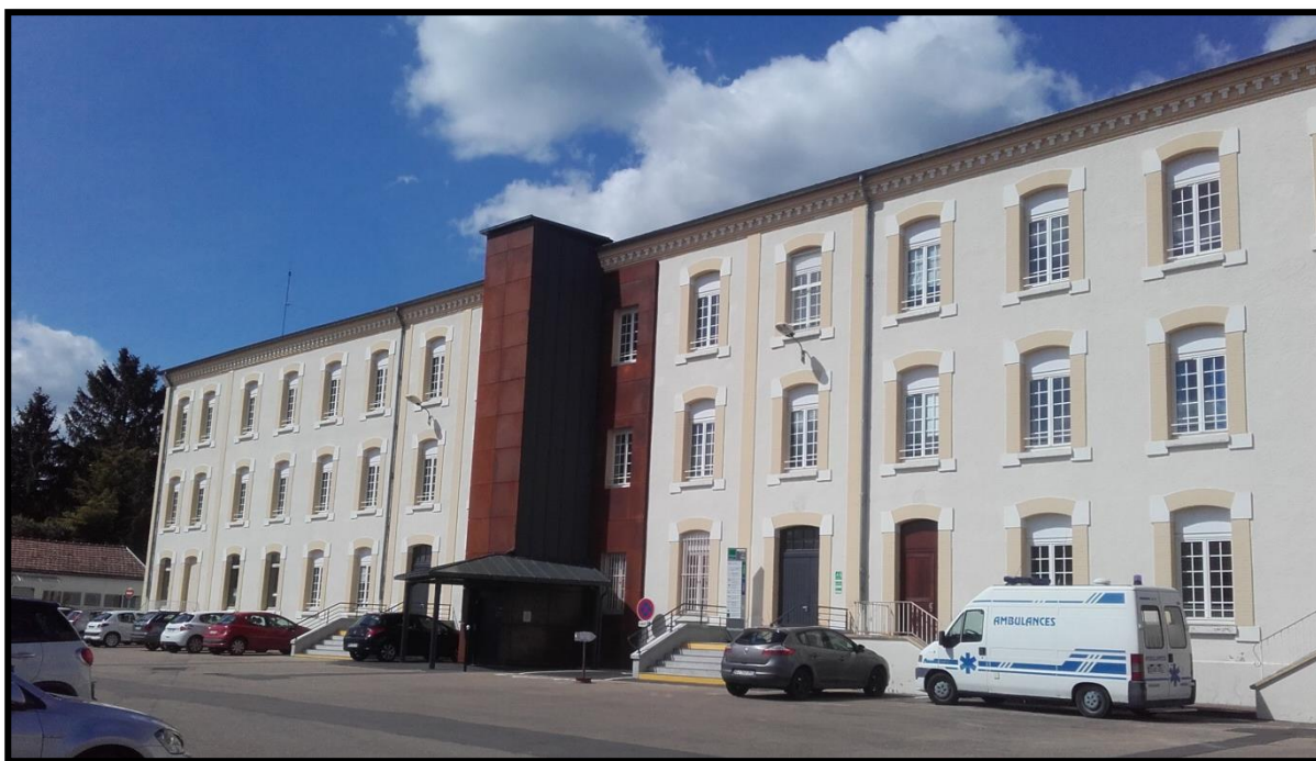
Illustration 31 : le bâtiment vu de l'extérieur coté parking
