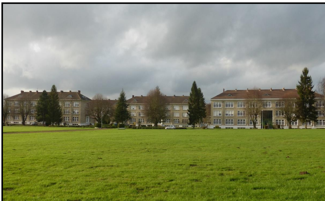
Illustration 2 : Bâtiments de logements et de bureaux, derrière le bâtiment de commandement.
