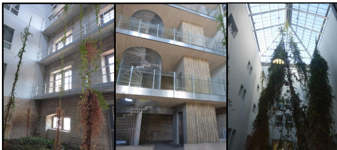
Illustration 100 (a,b et c) : une architecture renouvelée pour pallier les contraintes du bâti.
