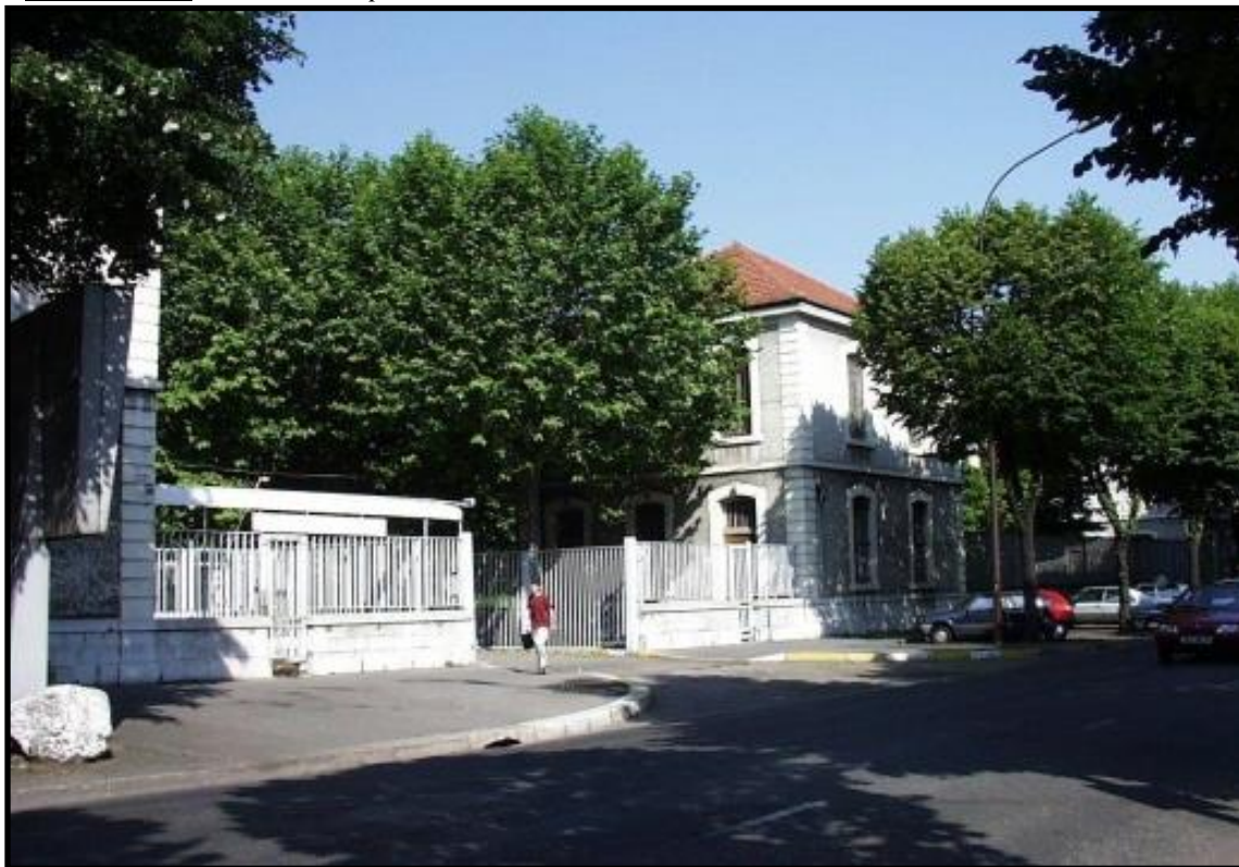
Illustration 55 : accès au site par l'avenue Gambetta.
