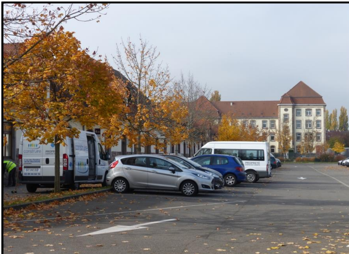
Illustration 78 : l'espace du service de propreté urbaine avec des batiments réhabilités en logements au fond.
