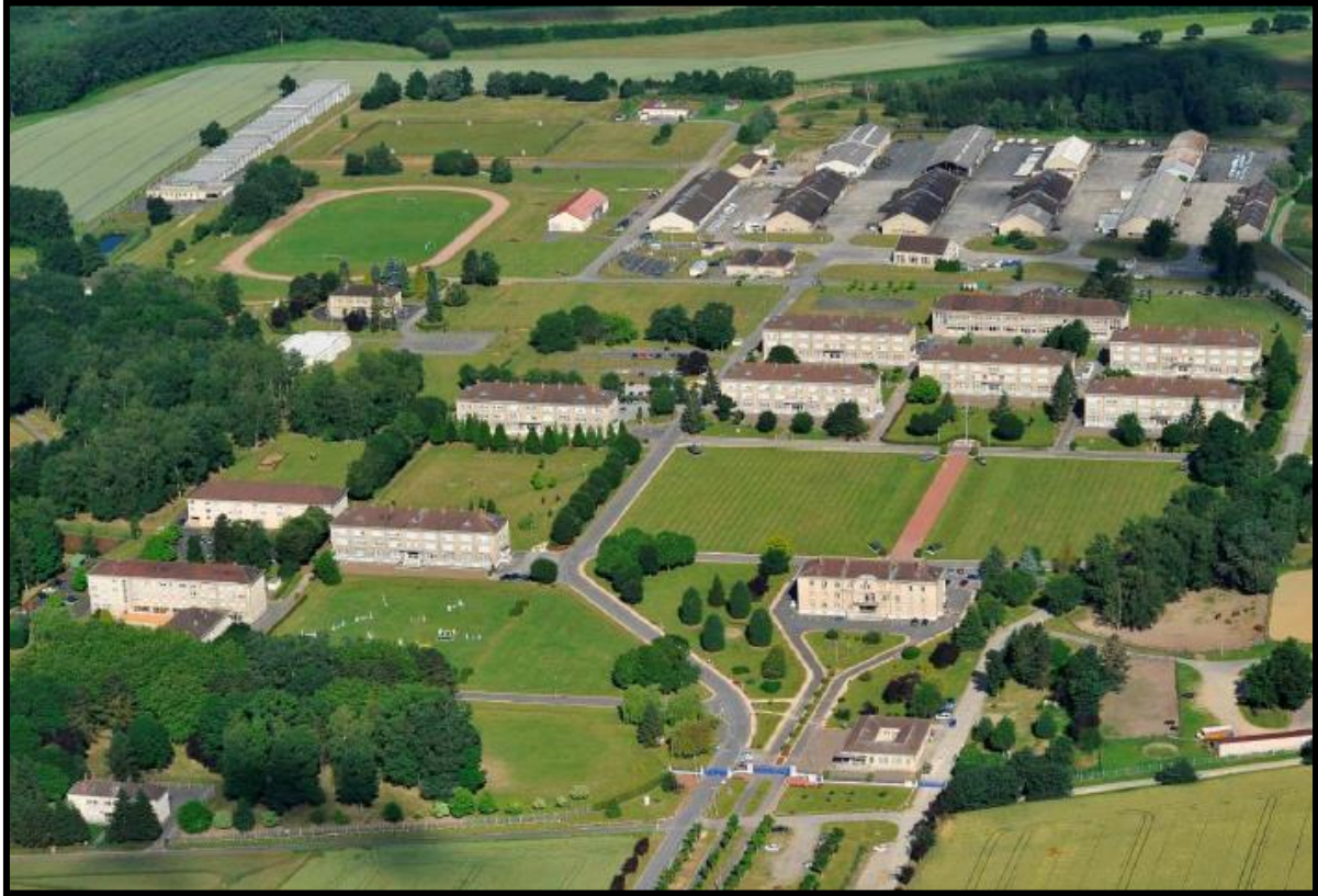
Illustration 7 : vue aérienne du site du RMT.
