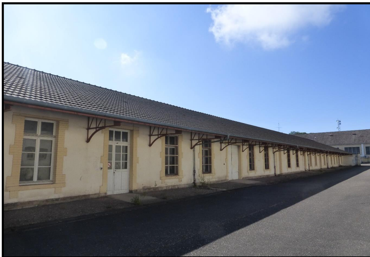
Illustration 52 : petits ateliers de réparation.
