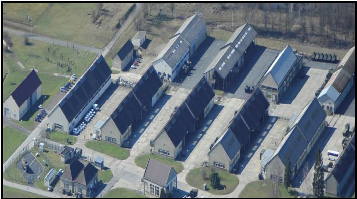
Illustration 8: les ateliers techniques en 2011, surface bâtie totale de 10 000m 2 .
