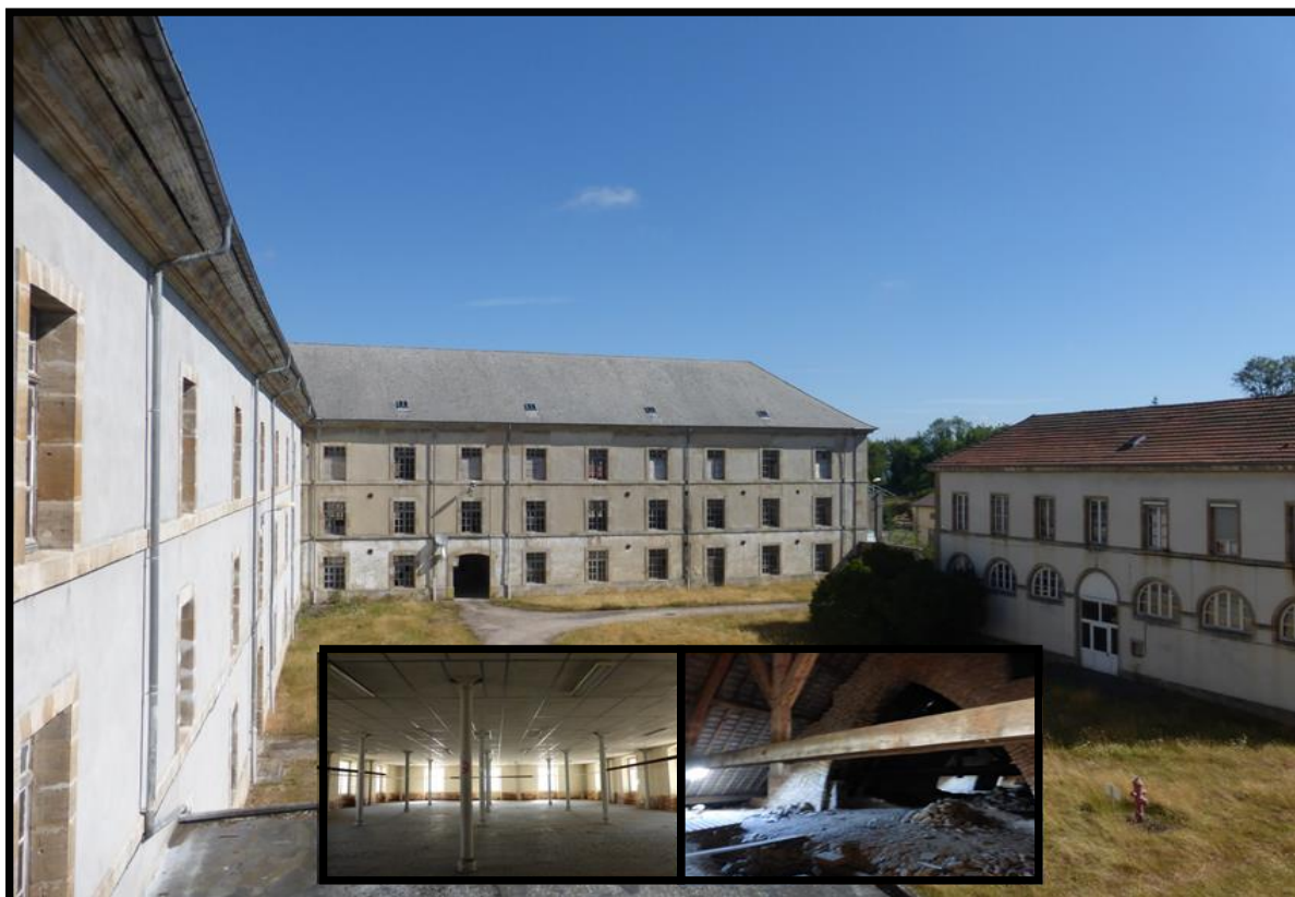
Illustration 53 (a, b, et c) : ateliers et bureaux sur trois bâtiments disposés en U.
