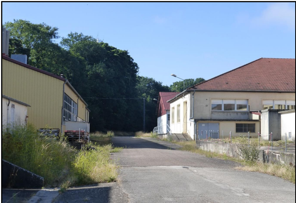
Illustration 51 : hangars divers sur la gauche et ateliers de production sur la droite.
