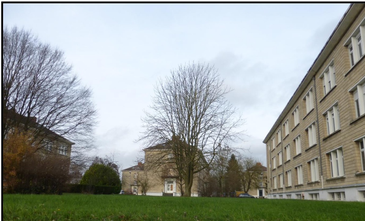
Illustration 16 : sur la gauche, internat d'excellence, au centre, bâtiment de la CCPN et à gauche, un bâtiment de chambrées qui accueille des activités tertiaires.
