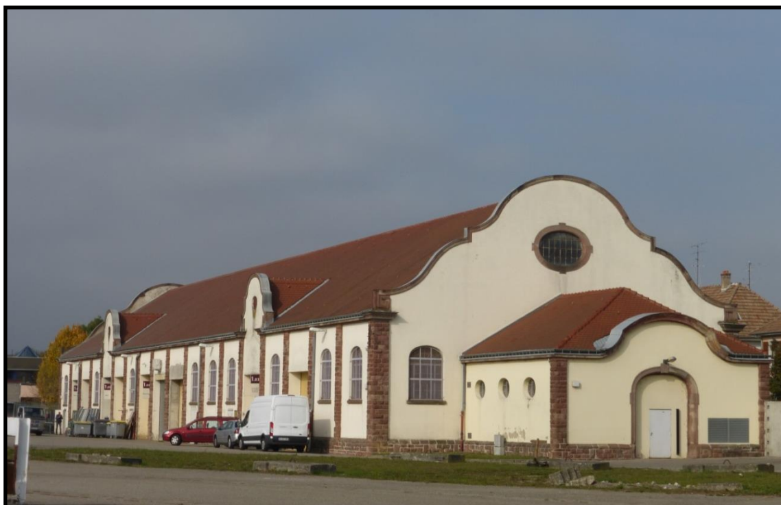
Illustration 75 : Le bâtiment qui donne sur la rue et l'entrée du site.
