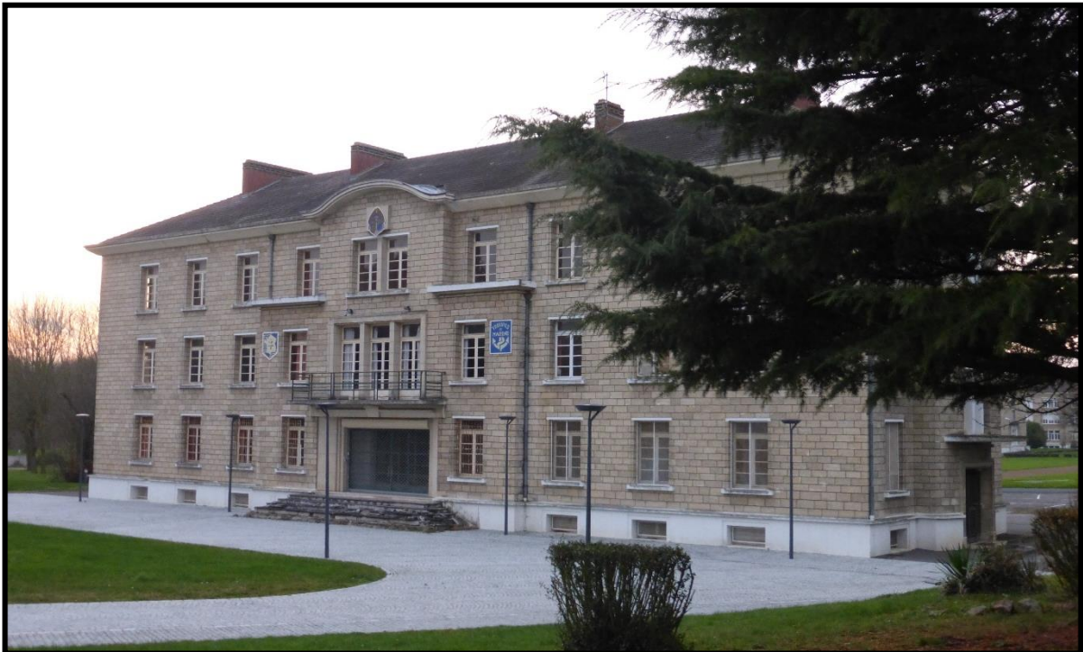
Illustration 19 : ancien bâtiment de commandement, (vue de dos par rapport à l'entrée du site).
