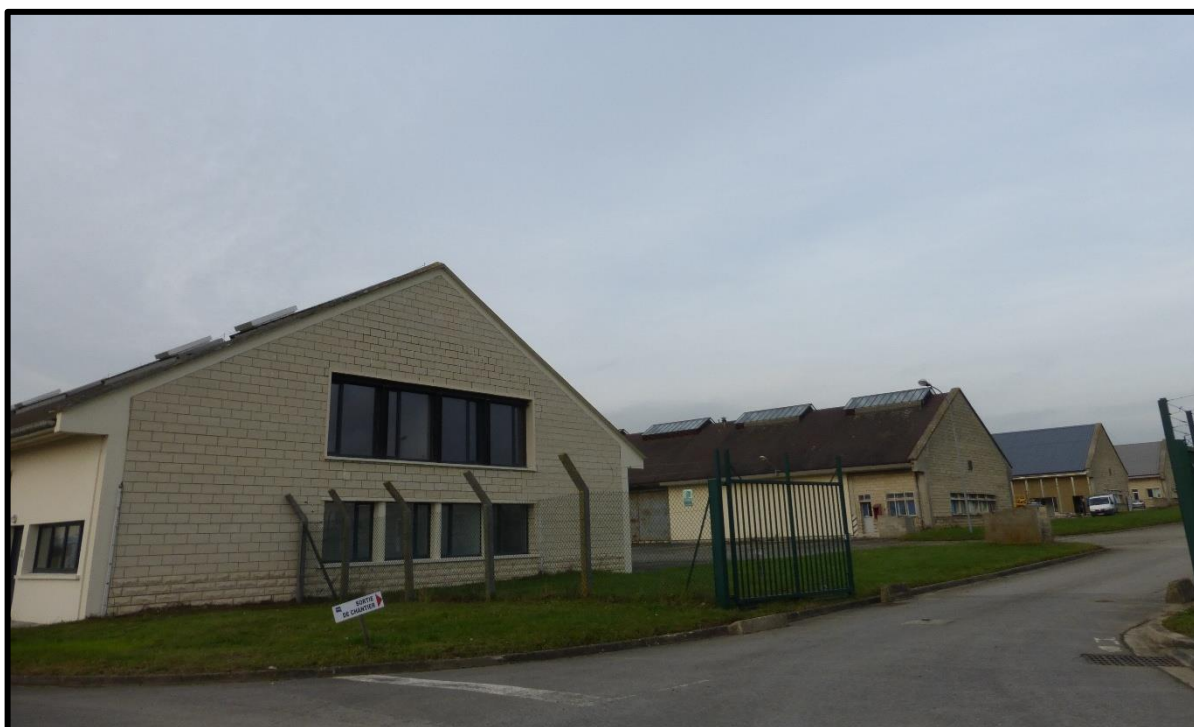
Illustration 17 : accès en zone technique ; les trois hangars sont occupés.
