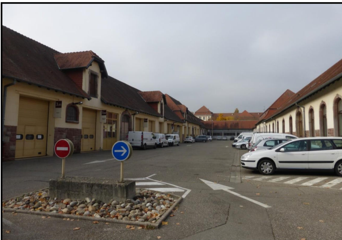
Illustration 76 : les allées du village artisanal dans les locaux réhabilités
