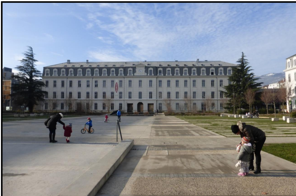
Illustration 67 : l'ancien bâtiment de commandement vu depuis l'entrée du site.
