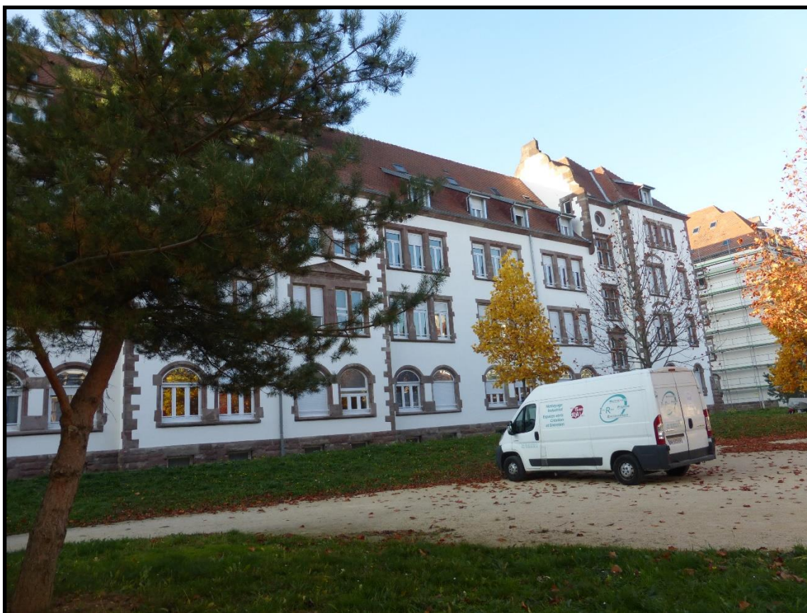
Cliché réalisé par l'auteure le 26 octobre 2015.
