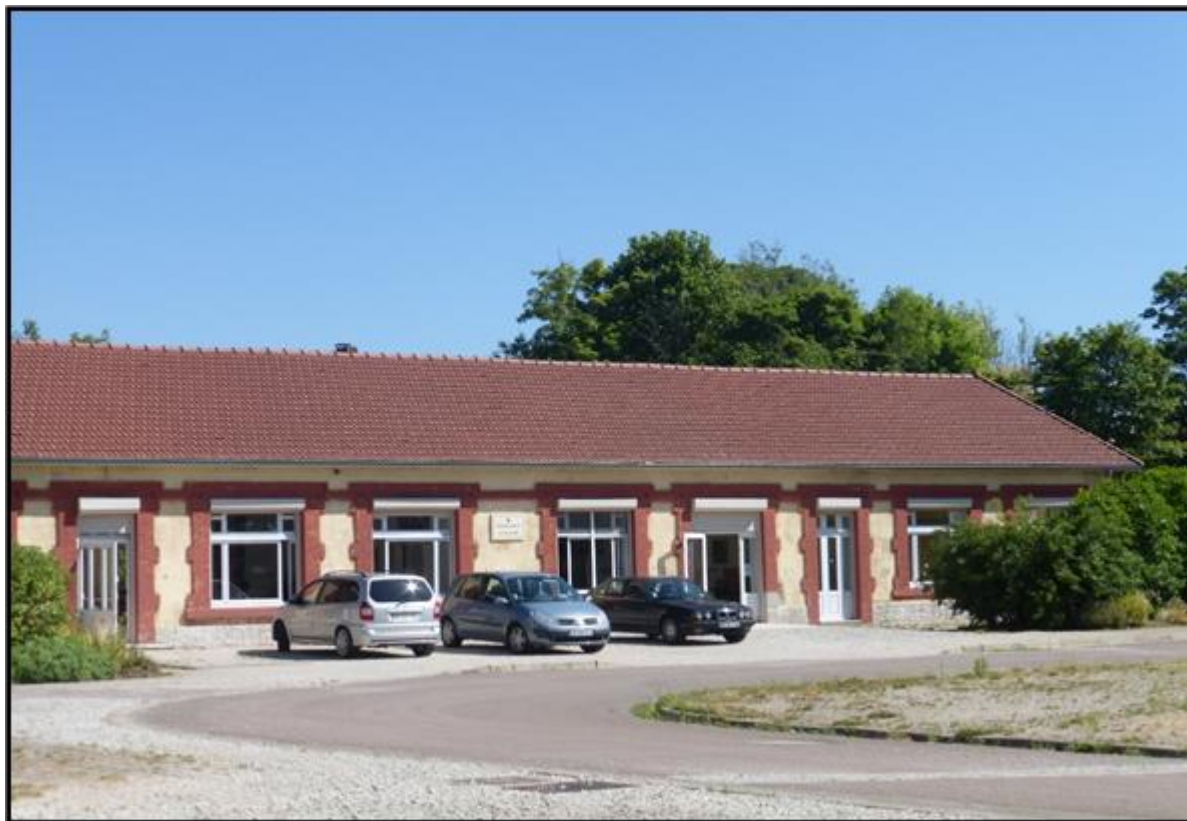
Illustration 43 : bâtiment 8 accueillant la restauration scolaire.
