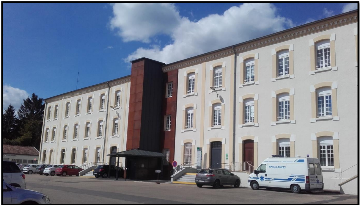
Illustration 31 : le bâtiment vu de l'extérieur coté parking
