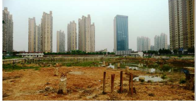
Changshu : chantier de construction et promotion immobilière (province du Jiangsu) (août 2012).
