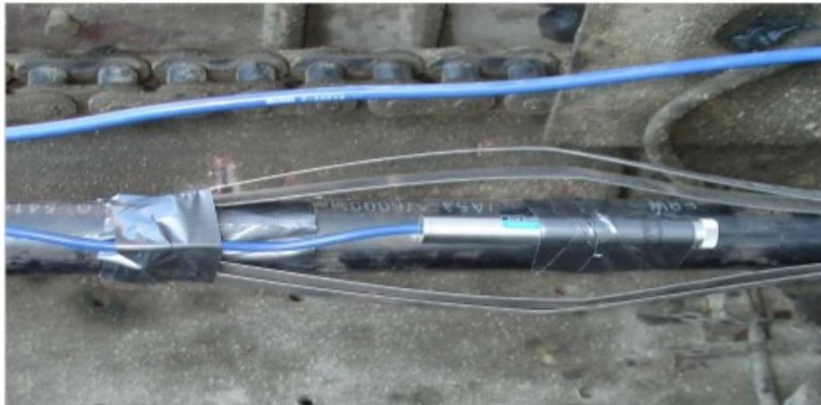
**Figure I.7** - Piézomètre à corde vibrante installé dans la structure à surveiller
