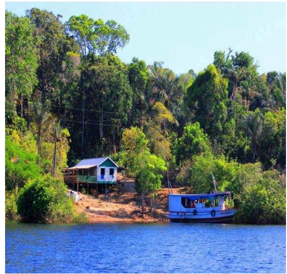
Figura 71 – Moradia do tipo palafita, construída em ambientes mais baixos para adaptar-se à subida e descida do rio Negro - comunidade Tumbira.
