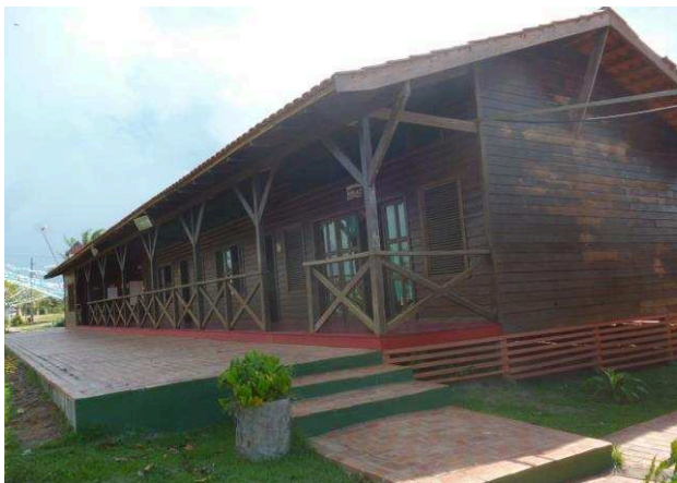
Figura 67 – Estrutura do complexo predial da FAS - comunidade Tumbira. Fonte: Pesquisa de campo, 2016.
