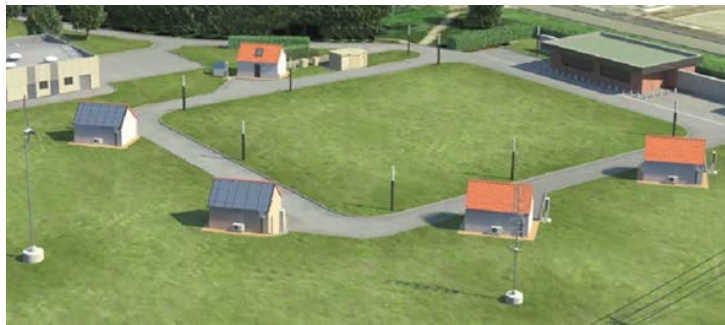
FIGURE 7.24 – Aperçu de l'expérience grandeur nature réalisée à EDF Lab Les Renardières.
