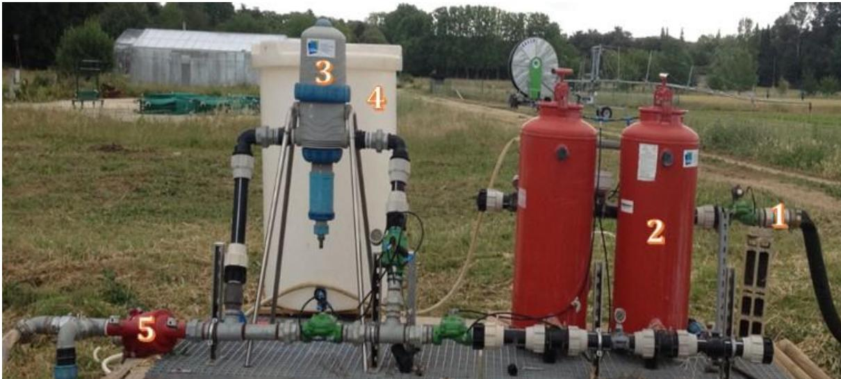
**Figure 31.** Station de tête du goutte à goutte enterré avec (1) une vanne manuelle, (2) un système de filtration qui inclut un régulateur de débit et des filtres à sable, (3) une pompe doseuse, (4) une cuve cylindrique et (5) un filtre à tamis (photo P. Rosique, 2014).
