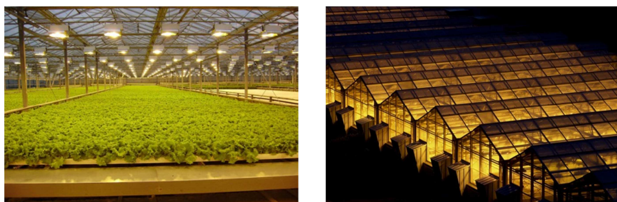
Figure 7 : Eclairage artificiel dans les serres (source : http://www.cannapro.co/lighting1.html ).
