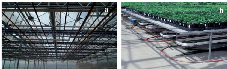
Figure 5 : Chauffage aérien au-dessus du couvert végétal (a) et au-dessous du couvert végétal (b) (source: Kittas et al., 2012).
