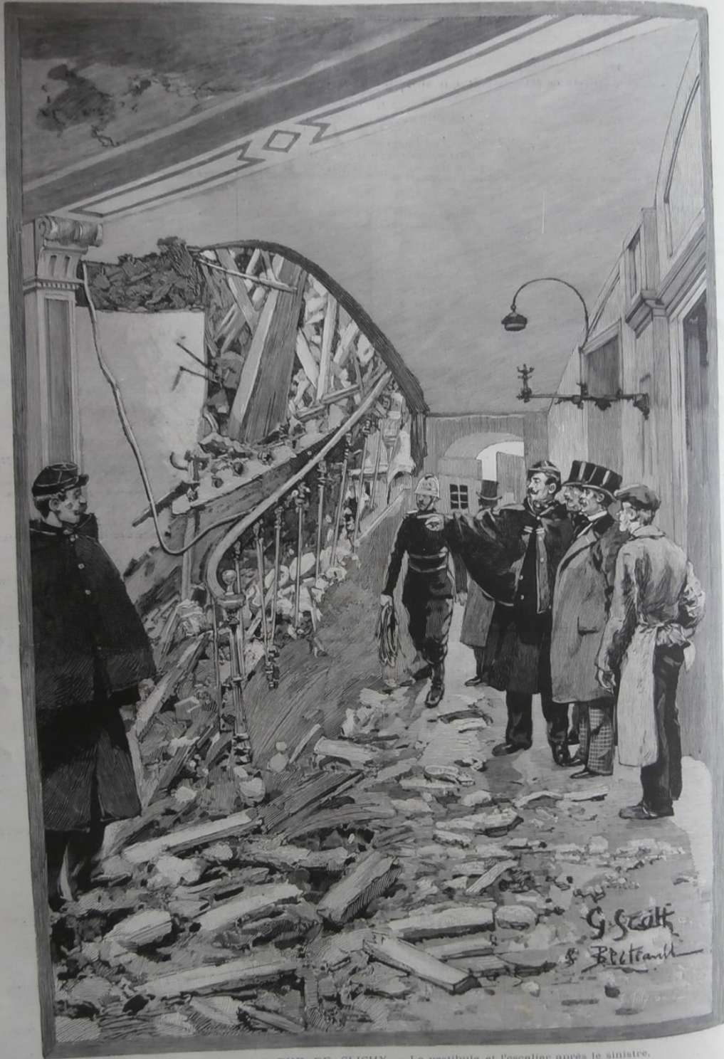
L'EXPLOSION DE LA RUE DE GLICHY. — Le vestibule et l'escalier après le sinistre. Vue prise au rez-de-chaussée.
