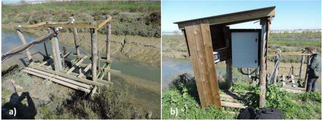
Figure 4 : photos de la plateforme d'angoulines et du boîtier électrique
