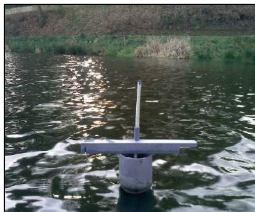
Photo 18 : Tuyau d'infiltration. Cliché : M. Aldomany, 2016
