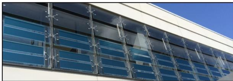
Figure n° I-4: Intégration de modules OPV au bâtiment - Crédits : Heliatek GmbH
