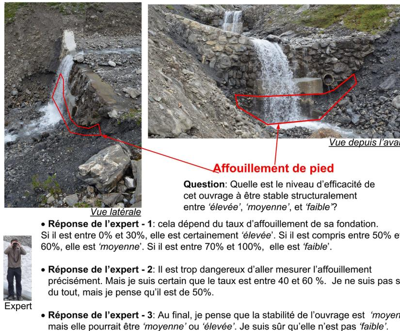
FIGURE IV.18 – Exemple d'évaluation de la stabilité (efficacité) structurale d'un ouvrage selon son taux d'affouillement par l'expert 3.
