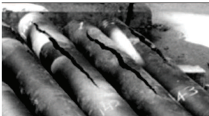
Figure 1.1 – Fissures longitudinales au niveau de la partie inférieure des tubes de vaporeformage [5].
