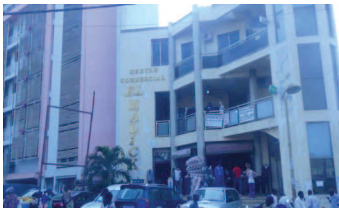
Photo 15 Centre commercial El Hadji Malick Sy
