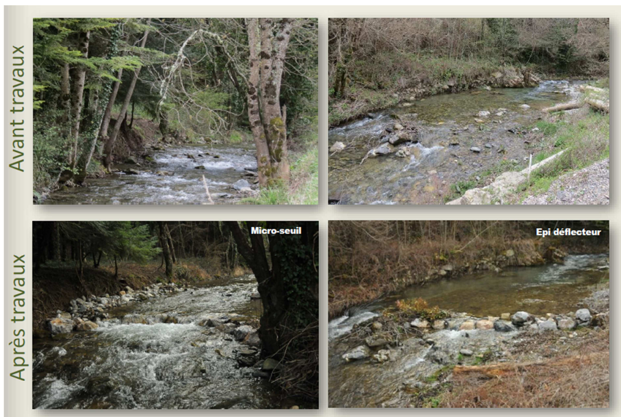
Figure 8-1: Exemple d'actions mises en place afin d'améliorer les potentialités d'accueil d'un cours d'eau ariégeois pour le desman des Pyrénées et ses proies (d'après Levenard et al., 2017). La pose d'un seuil et d'un épi déflecteur a permis de diversifier les faciès d'écoulement des tronçons de rivières aménagés.
