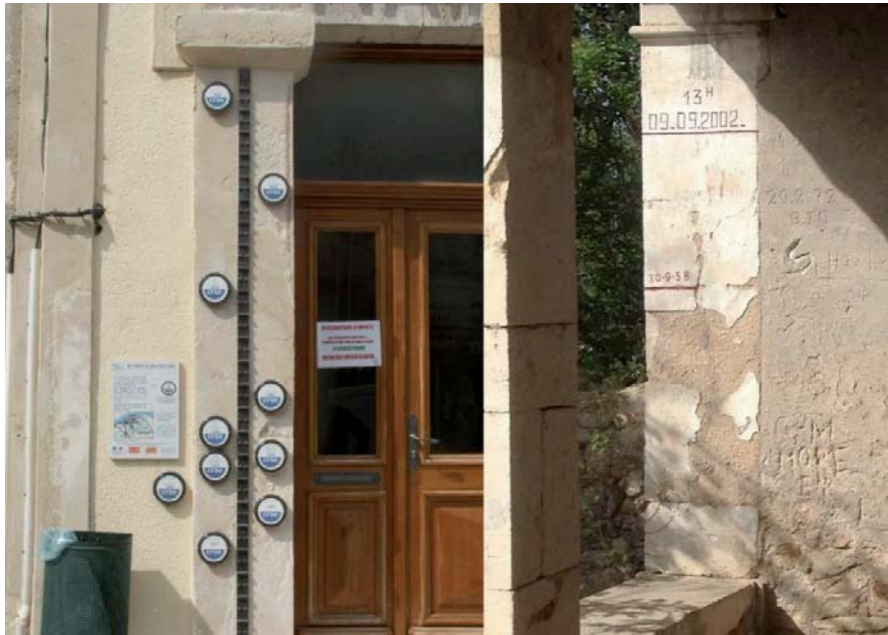
Figure 2.6 : Repères de crues à Comps et Goudargues (Gard) (Gisclard, 2017)
