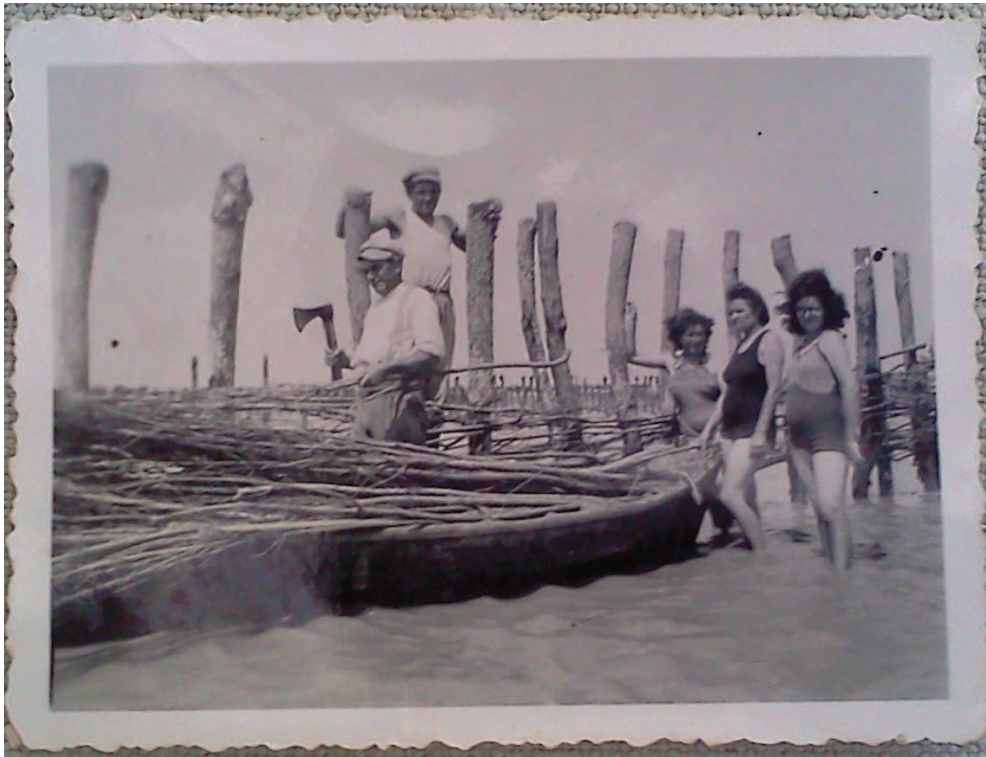
Figure 5. La préparation du clayonnage
