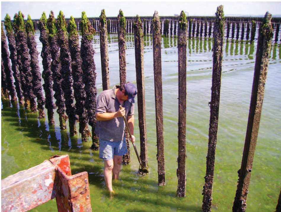
Figure 5. Le grattage des pieux
