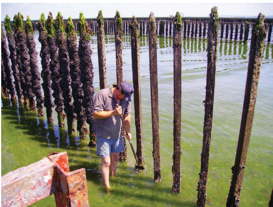
Figure 5. Le grattage des pieux
