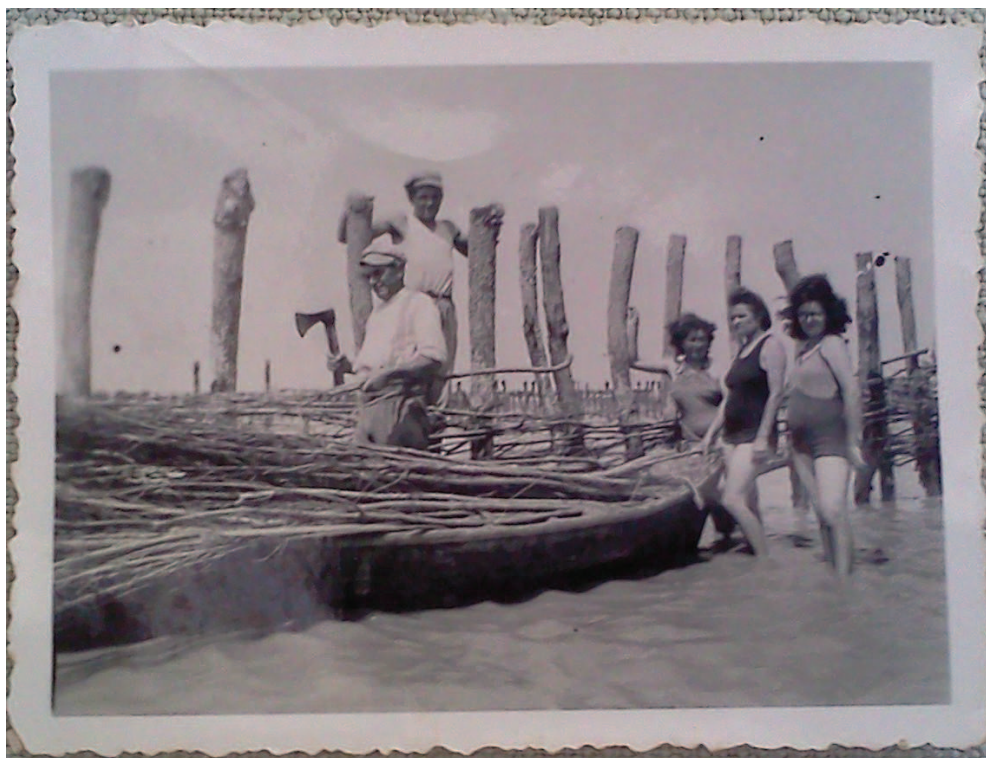
Figure 5. La préparation du clayonnage
