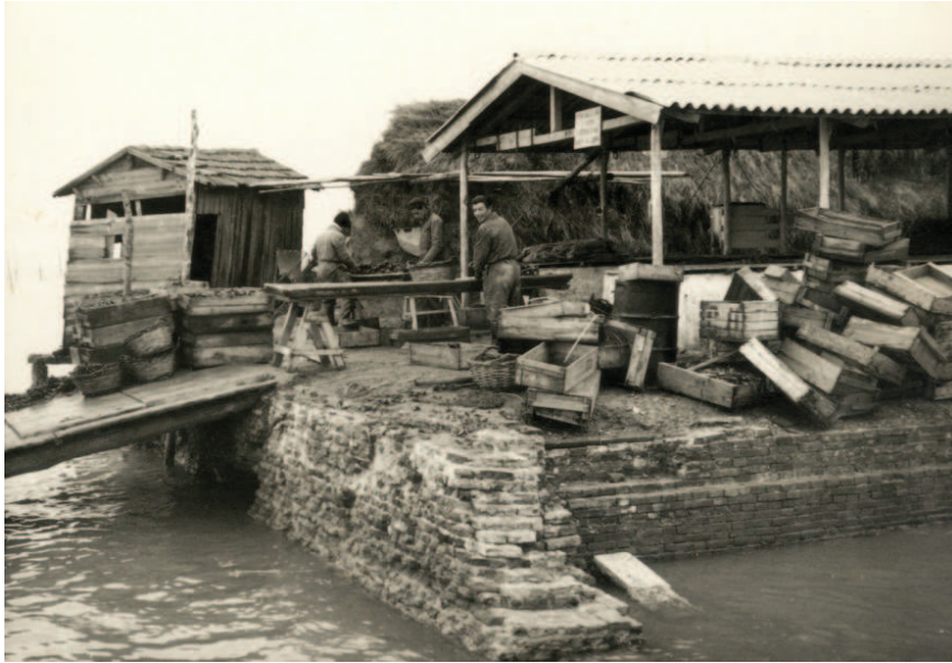
Figure 7. Les hangars de la société Mitilpesca sur l'Ottagono
