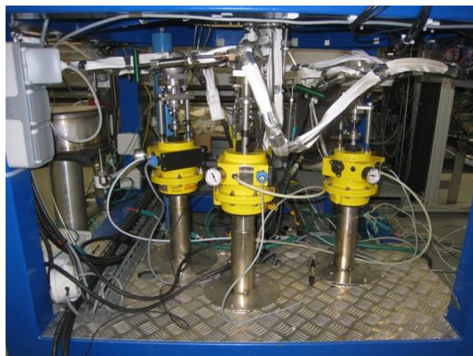
Figure II.9: Photographie des vannes Kämmer utilisées pour détendre les gaz de sortie. Une vanne est présente sur chaque sortie de chambre du montage métallique pression. Les cordons blancs servent à les maintenir en température pour éviter toute condensation de vapeur.
