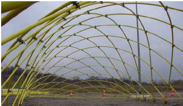
Fig. 1.2 Position des extrémités des poutres fixée au sol [16]
