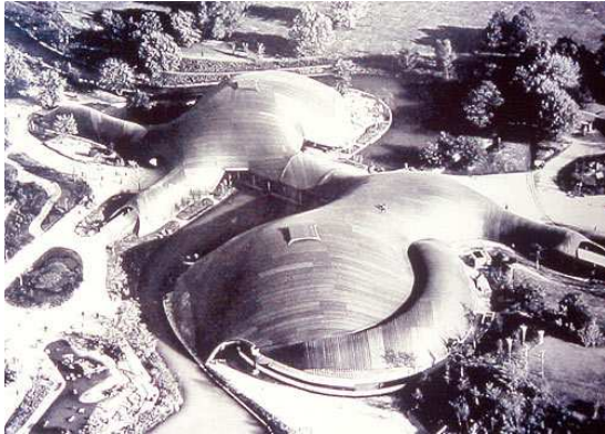
(a) Vue aérienne du gridshell
