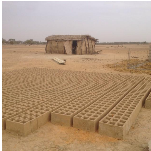
Photo 20 : Briques destinées à la construction d'une salle de classe.
