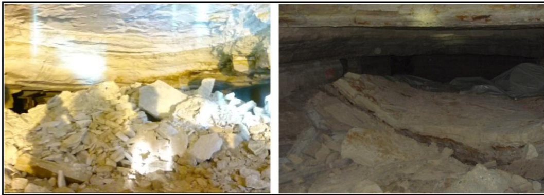
Figure 3-10 Débris rocheux des fontis elliptiques de la carrière de la Brasserie (photo de gauche : Zone II, photo de droite : Zone III)
