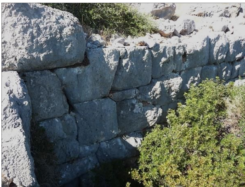
Fig. 6 - Parement externe de la courtine 7, vue vers le nord-ouest, cliché Guintrand 2012
