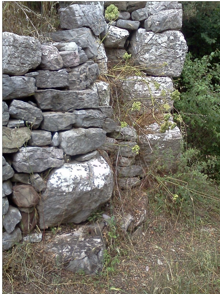
Fig. 5 - Courtine 5 en coupe à l'ouest de l'église Agia Paraskevi, vue vers le nord, cliché Guintrand 2015
