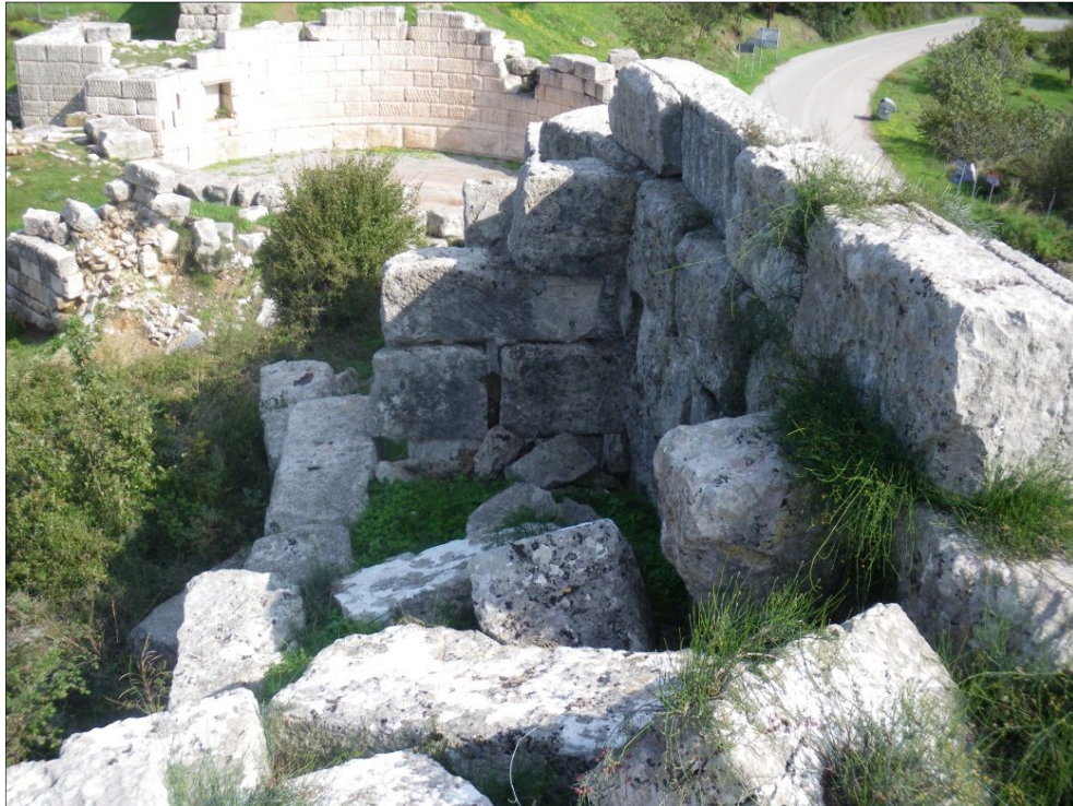
Fig. 4 - Courtine 4 vue vers l'est, cliché Guintrand 2008
