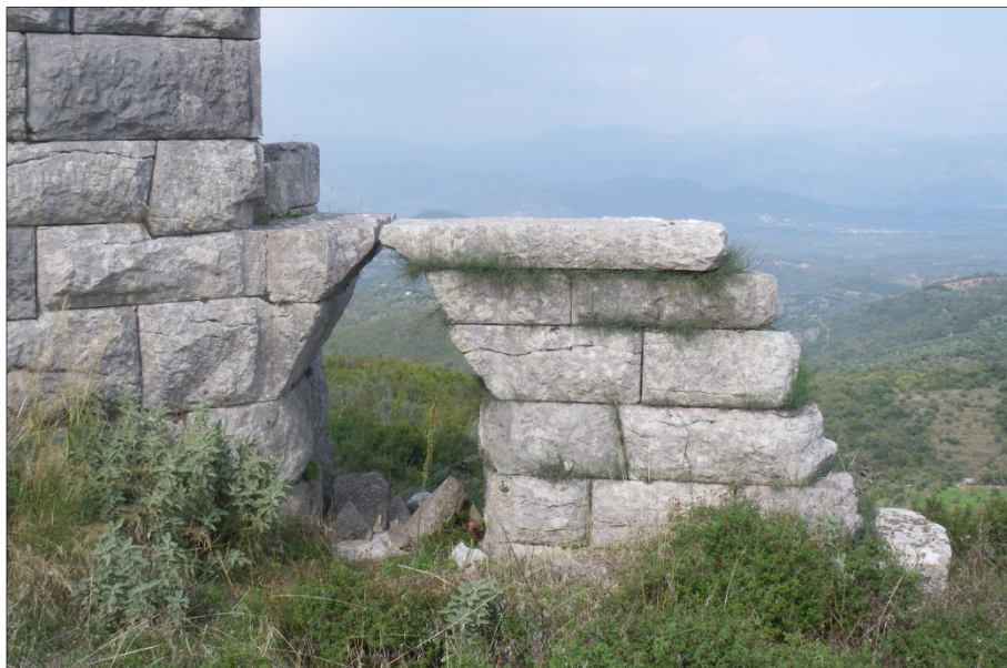
Fig. 10 - Poterne à l'est de la tour 6 vue vers le nord, cliché Guintrand 2008
