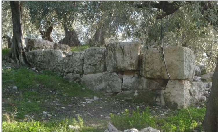
Fig. 4 - Mur nord de la possible tour, vue vers le sud, cliché Guintrand 2014
