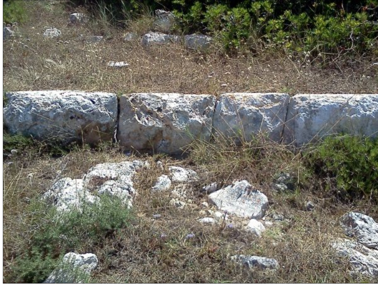
Fig. 4 - Face externe du tronçon 2 du rempart nord en appareil trapézoïdal, vue vers le sud, cliché Guintrand 2015
