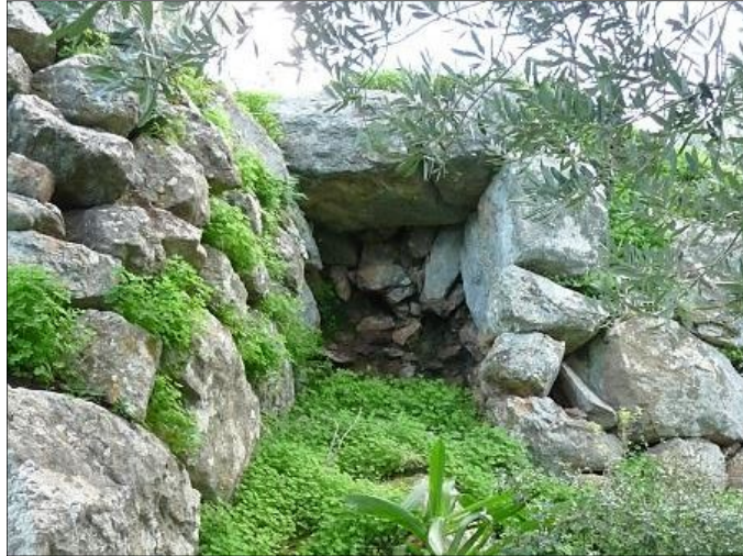
Fig. 8 - Poterne au bas du mur nord de la tour 3, vue vers l'ouest, cliché Guintrand 2014
