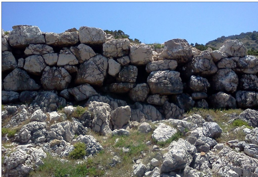
Fig. 5 - Face externe du tronçon 2 du rempart nord en appareil polygonal, vue vers le sud-ouest, cliché Guintrand 2015
