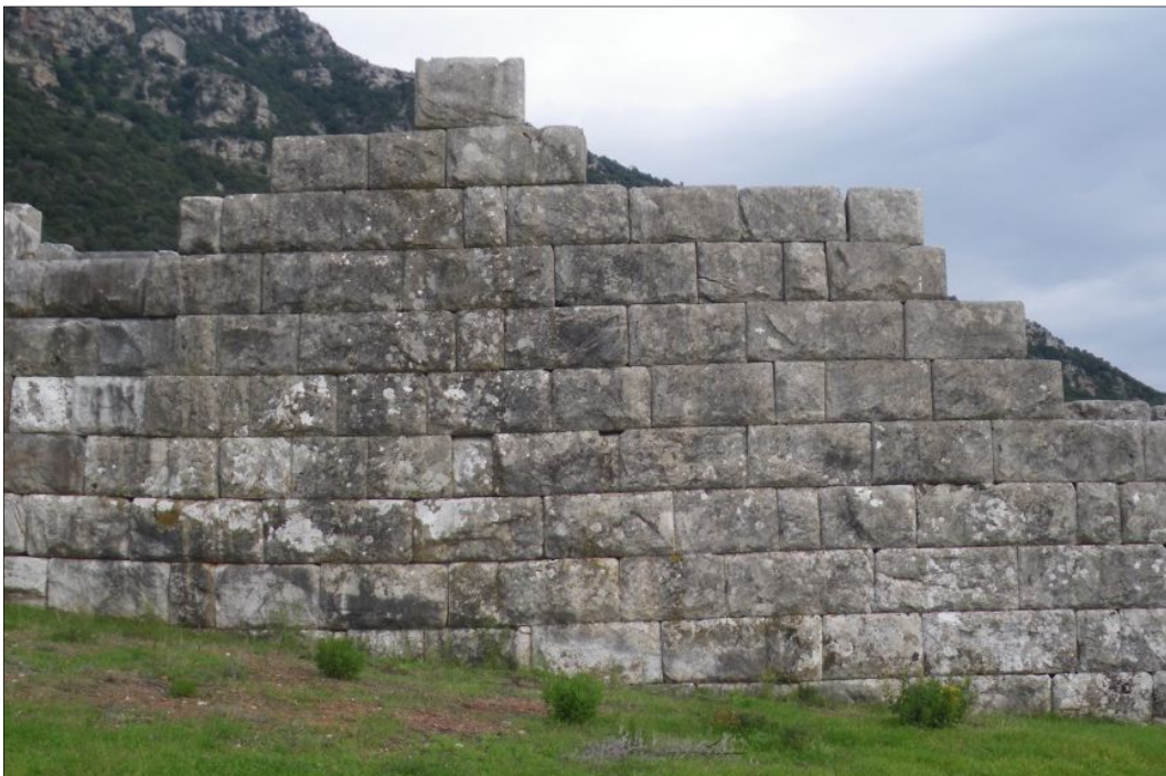
Fig. 3 - Parement externe de la courtine 3, vue vers le sud, cliché Guintrand 2008
