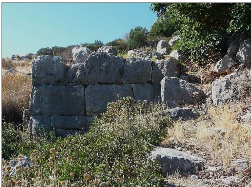
Fig. 13 - Mur est de la tour 11, vue vers l'ouest, cliché Guintrand 2012
