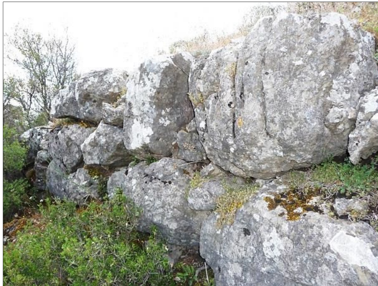
Fig. 2 - Tronçon 2, au sud-ouest de la tour médiévale, vue vers l'est, cliché Guintrand 2015
