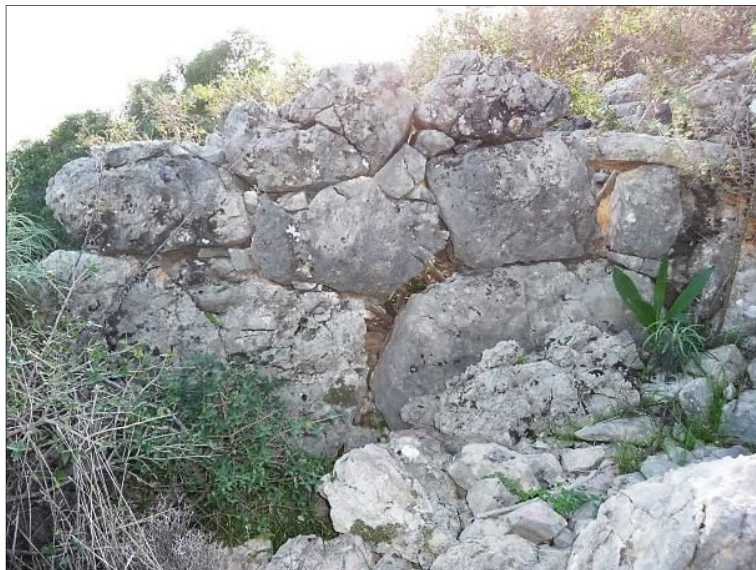
Fig. 3 - Mur nord-ouest du grand bâtiment, vue vers le sud-ouest, cliché Guintrand 2014
