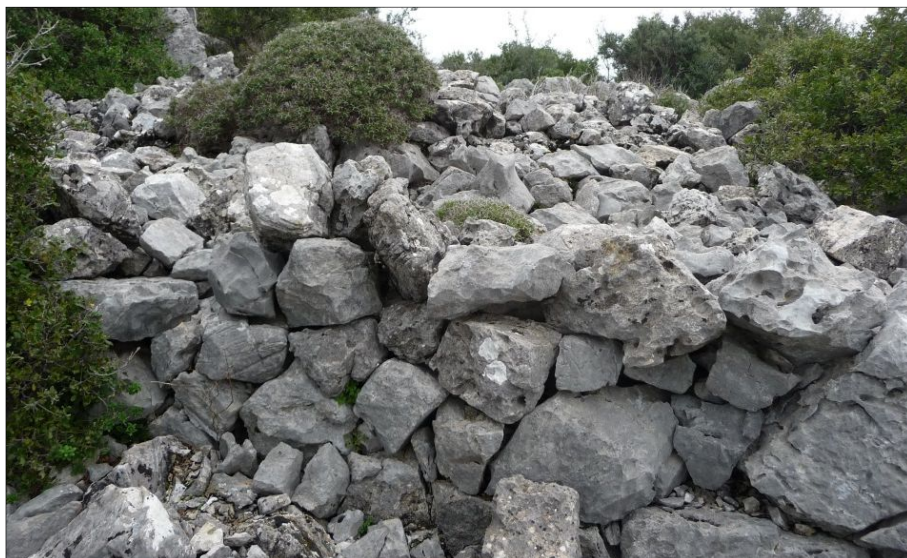
Fig. 2 - Face externe du mur du rempart sud-ouest, cliché Guintrand 2014
