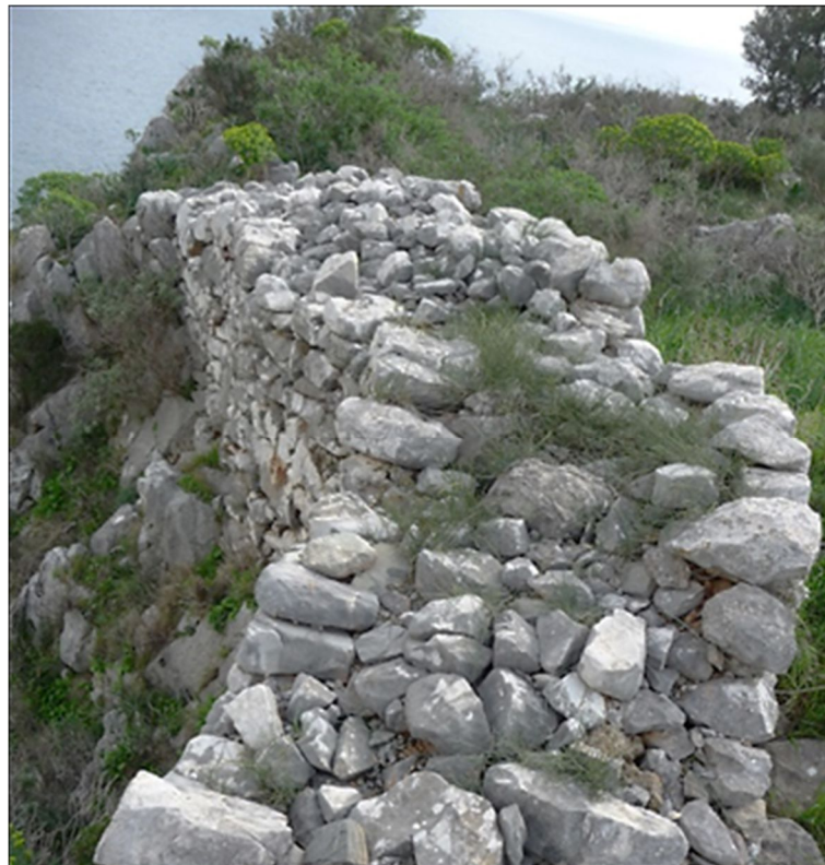
Fig. 2 - Rempart vue vers le sud, cliché Guintrand 2014
