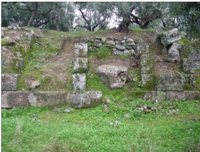
Fig. 3 - Courtine du rempart nord avec murs transversaux, vue vers le sud, cliché Guintrand 2008
