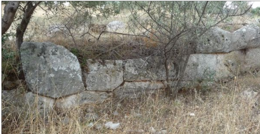
Fig. 13 - Parement externe de la courtine 19, vue vers le sud-est, cliché Guinrand 2012
