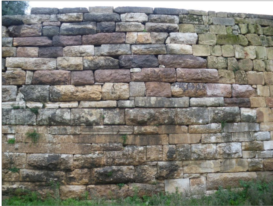
Fig. 24 - Parement externe de la courtine 26, vue vers l'est, cliché Guintrand 2008
