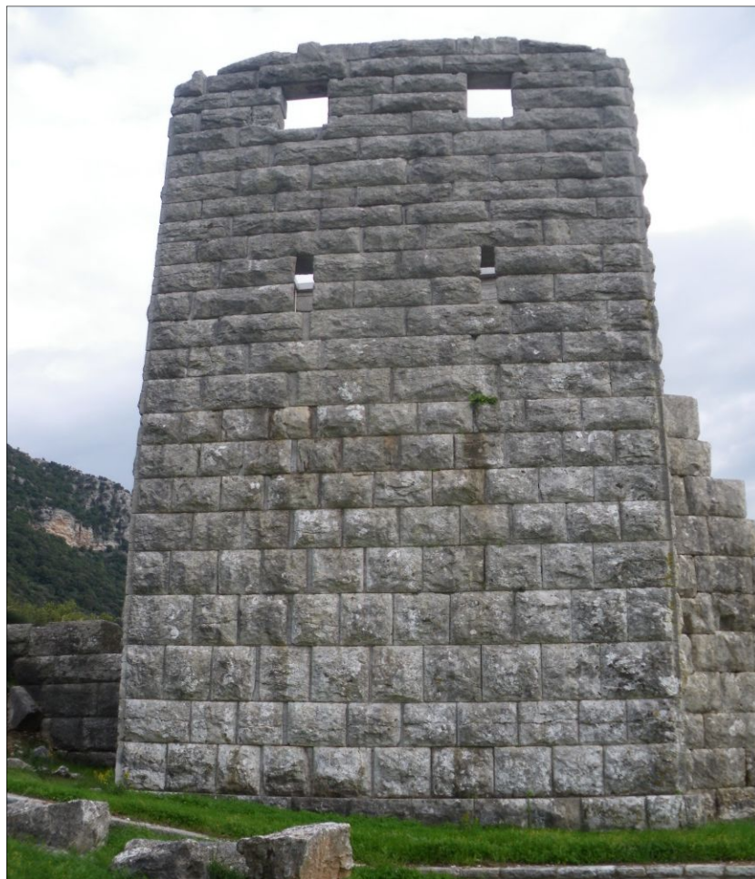
Fig. 6 - Tour 41 vue vers le sud, cliché Guintrand 2008
