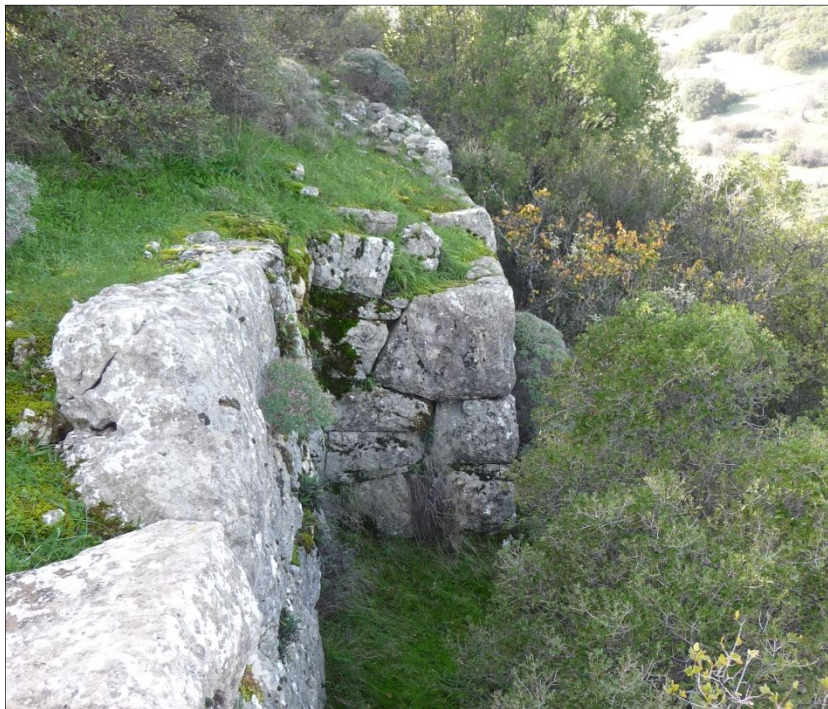
Fig. 2 - Rempart nord, crémaillère, vue vers l'ouest, cliché Guintrand 2014
