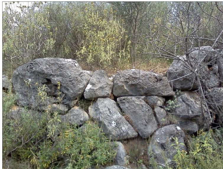
Fig. 2 - Face externe du mur du rempart ouest, vue vers le nord, cliché Guintrand 2015
