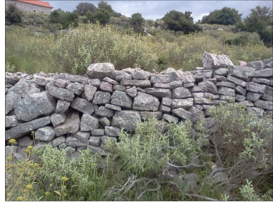
Fig. 3 - Face externe du rempart sud-ouest, vue vers le nord-est, cliché Guintrand 2015
