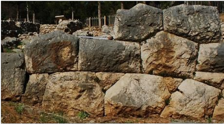
Fig. 5 - Appareil polygonal d'une courtine hellénistique de l'Aspis d'Argos (TOUCHAIS, PHILIPPA-TOUCHAIS et FACHARD Aspis , 2010, p. 558 Fig. 9)
