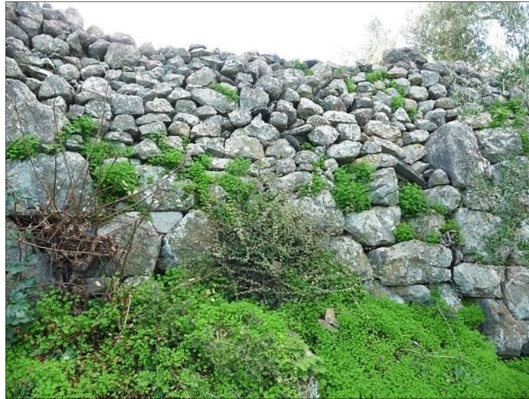
Fig. 4 - Réparation dans courtine 4, vue vers le sud, cliché Guintrand 2014
