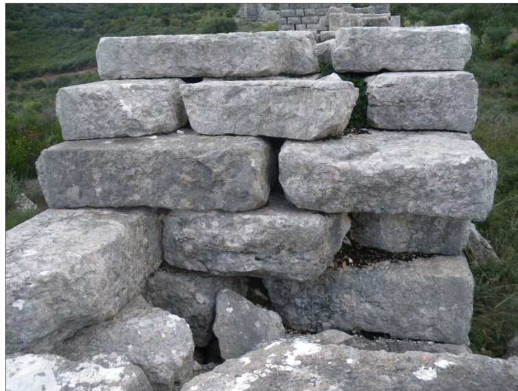
Fig. 20 - Courtine 15 vue en coupe, vue vers le nord, cliché Guintrand 2008
