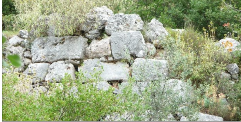
Fig. 4 – Angle sud-est de la tour, vue vers le nord, cliché Guintrand 2015
