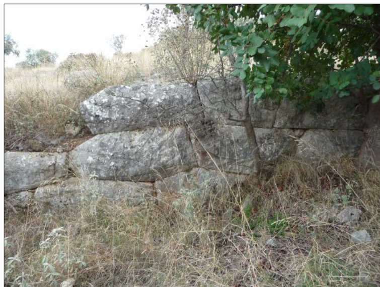
Fig. 14 - Parement externe de la courtine 21, vue vers le sud-est, cliché Guinrand 2012
