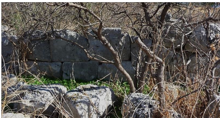
Fig. 14 - Parement externe de la courtine 19, vue vers l'est, cliché Guintrand 2012
