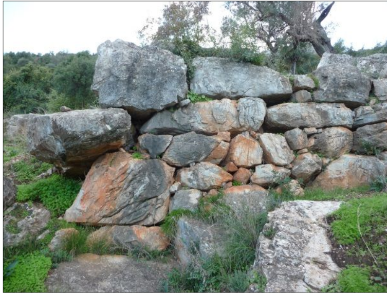
Fig. 2 - Mur nord de la tour 1, vue vers le sud, cliché Guintrand
