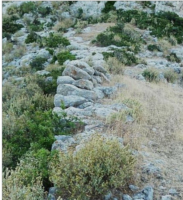
Fig. 1 - Mur nord, vue vers l'est, cliché Guintrand 2015
