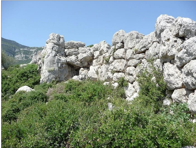
Fig. 6 - Mur (tronçon 3) avec changement de direction pour que la face externe s'appuie sur un pic rocheux, vue vers le sud, cliché Guintrand 2015
