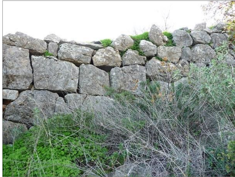
Fig. 3 - Face externe de la courtine 1, vue vers l'est, cliché Guintrand 2014
