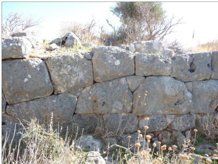
Fig. 18 - Parement externe du mur intérieur (tronçon 1), vue vers le sud-est, cliché Guintrand 2012
