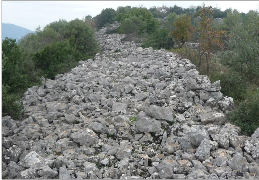
Fig. 3 - Rempart sud-ouest, vue vers le nord, cliché Guintrand 2014
