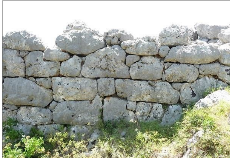
Fig. 4 - Face interne du mur (tronçon 2), vue vers l'est, cliché Guintrand 2015
