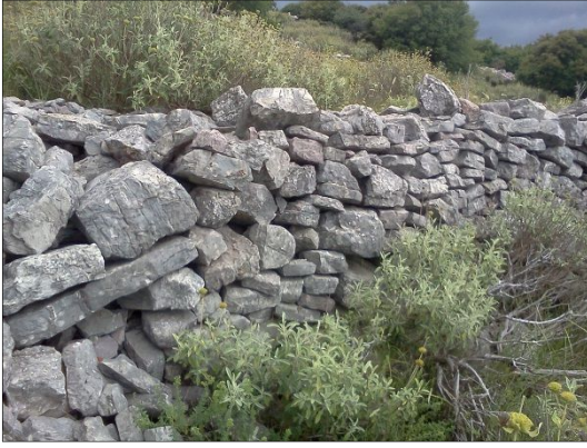
Fig. 2 - Face externe du rempart sud-ouest, vue vers le sud-est, cliché Guintrand 2015
