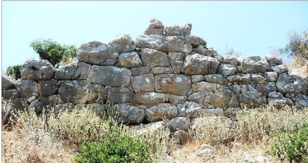
Fig. 3 - Face externe du mur du tronçon 1, vue vers l'est, cliché Guintrand 2015
