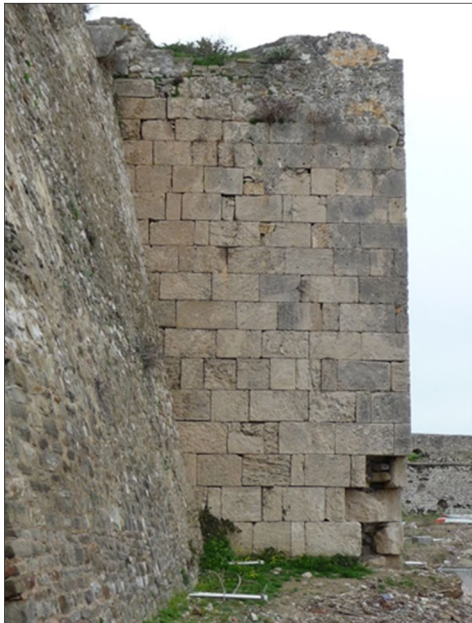
Fig. 2 - Mur sud de la tour en appareil isodome au rempart est, cliché Guintrand 2015
