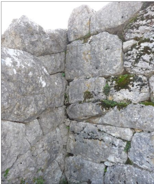
Fig. 3 - Liaison entre la courtine 2 et la tour 2, vue vers le sud-est, cliché Guintrand 2014
