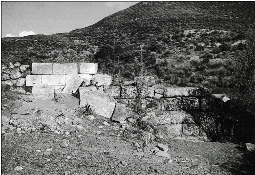
Fig. 25 - Mur est de la porte, vue vers l'est (SCHWERTHEIM Monumentale , 2014, p. 101 Fig. 6)
