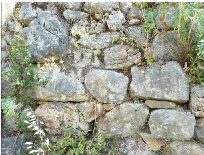
Fig. 3 - Face externe du mur du tronçon 2, vue vers le nord, cliché Guintrand 2015
