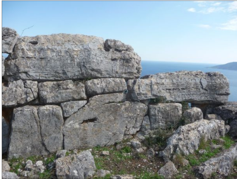
Fig. 11 - Mur ouest du bastion, vue vers l'est, cliché Guintrand 2012
