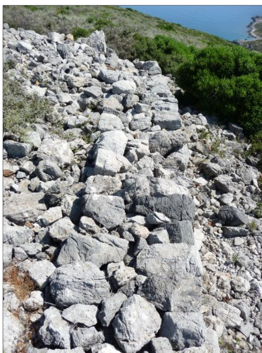
Fig. 4 - Rempart sud-est, vue vers l'est, cliché Guintrand 2015
