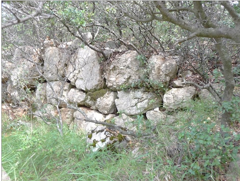
Fig. 12 - Parement externe du mur intérieur, vue vers l'est, cliché Guintrand 2015
