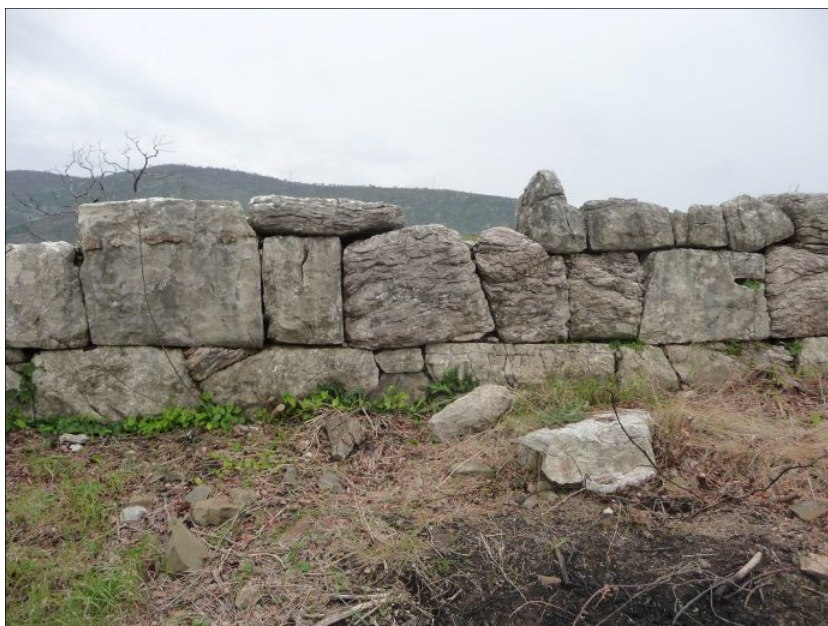
Fig. 2 - Parement extérieur de la courtine 2, vue vers l'ouest, cliché Guintrand 2014
