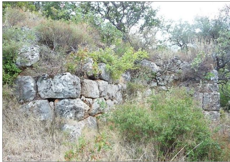
Fig. 8 - Décrochement et mur nord-est de la projection, vue vers le sud, cliché Guintrand 2012
