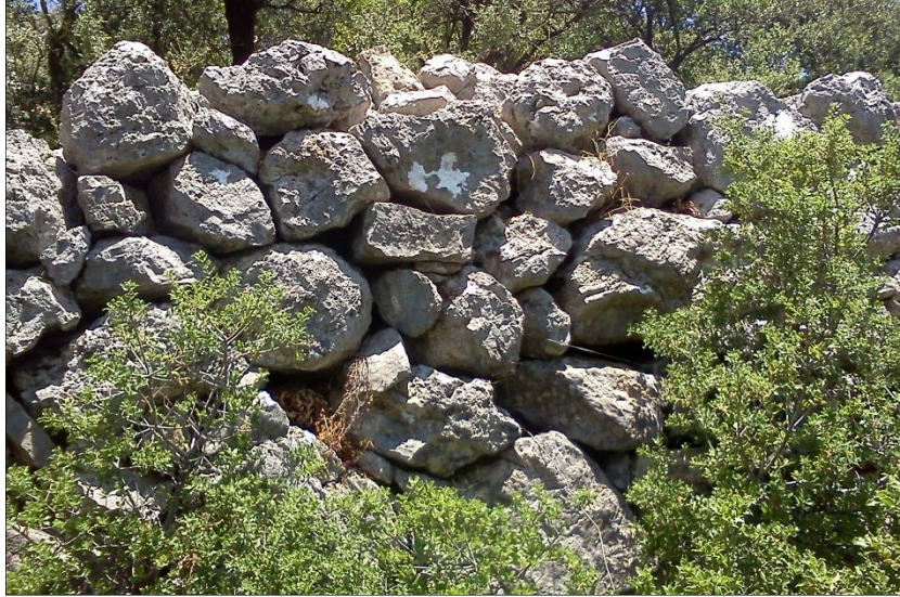
Fig. 3 - Face externe de la courtine, vue vers le nord, cliché Guintrand 2015
