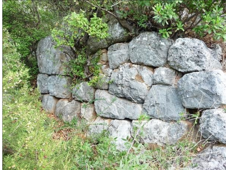
Fig. 10 - Mur nord-ouest de la tour 4, vue vers le sud-est, cliché Guinrand 2012
