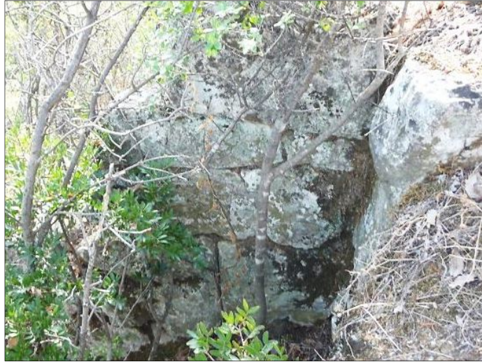
Fig. 5 - Mur nord de la tour 2, vue vers le sud, cliché Guintrand 2012
