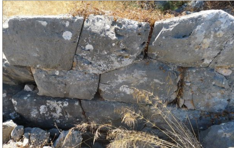
Fig. 2 - Mur oriental de la tour de Tserpho, vue vers l'ouest, cliché Cl. Balandier 2015
