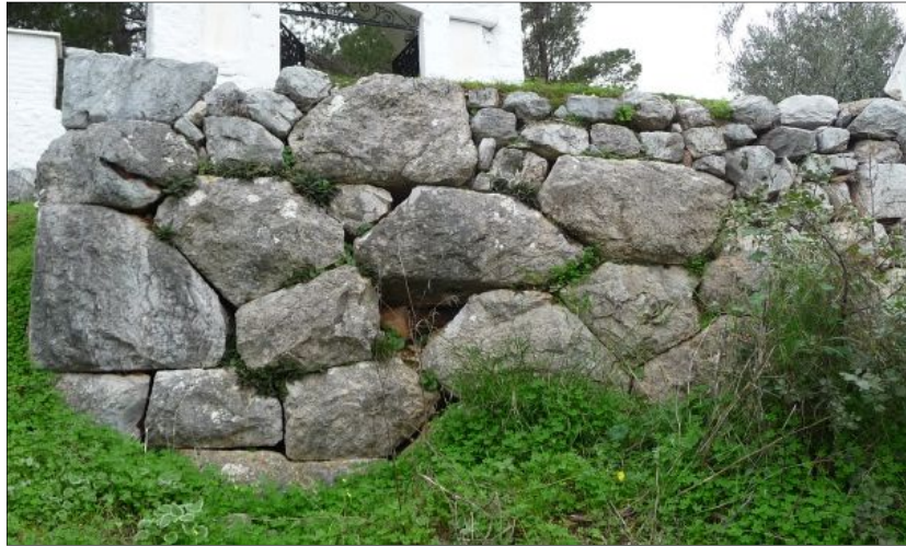
Fig. 18 - Mur nord de la tour 22, vue vers le sud, cliché Guintrand 2015
