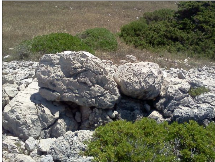
Fig. 7 - Face externe du tronçon 2 du rempart ouest, vue vers l'est, cliché Guintrand 2015
