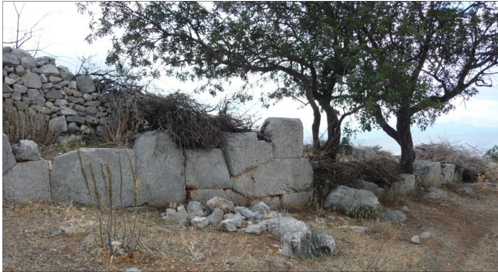
Fig. 5 - Face externe de la courtine 12, vue vers le nord-est, cliché Guintrand 2012
