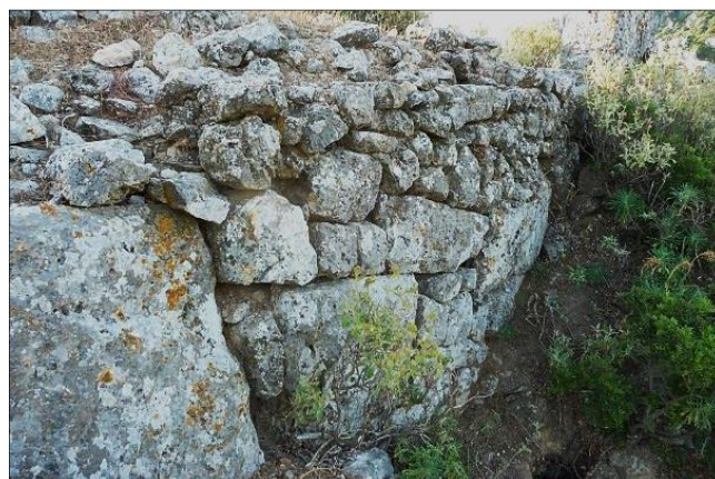
Fig. 2 – Face externe du mur ouest, vue vers le sud-est, cliché Guintrand 2015
