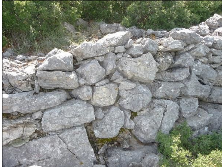
Fig. 2 - Parement externe d'une courtine au rempart est, vue vers le sud-est, cliché Guintrand 2015
