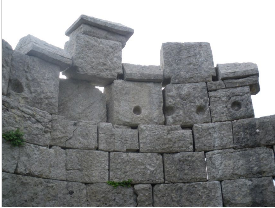
Fig. 9 - Tour 6, trous d'encastrement pour les traverses qui soutiennent la plate-forme et crénelage, vue vers le nord, cliché Guintrand 2008
