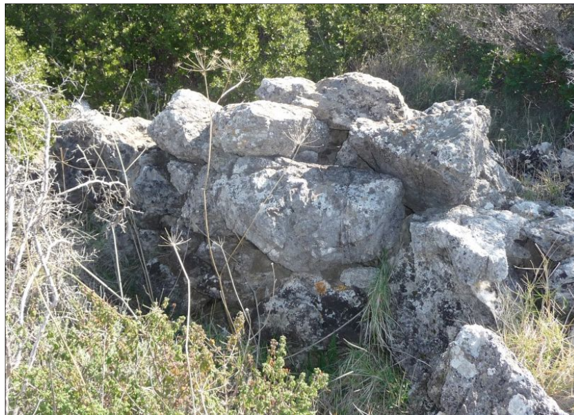
Fig. 3 - Face externe du mur, rempart nord, vue vers le sud-est, cliché Guintrand 2012
