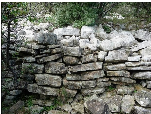
Fig. 1 - Face externe du mur nord/sud, vue vers l'ouest, cliché Guintrand 2014
