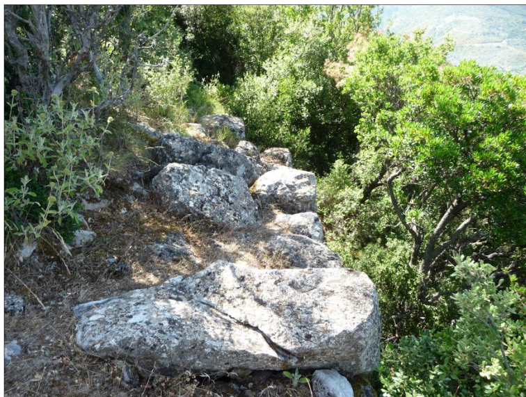
Fig. 3 - Mur du rempart nord avec bloc en boutisse, vue vers nord-ouest, cliché Guintrand 2015
