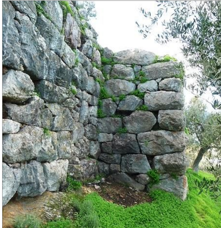
Fig. 7 - Mur est de la tour 3, vue vers l'ouest, cliché Guintrand 2014
