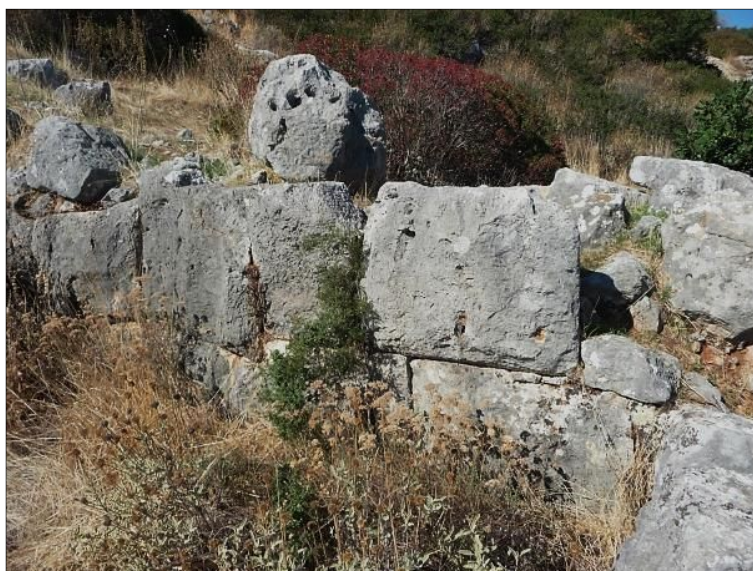
Fig. 11 - Parement externe de la courtine 11, vue vers le nord-ouest, cliché Guintrand 2012
