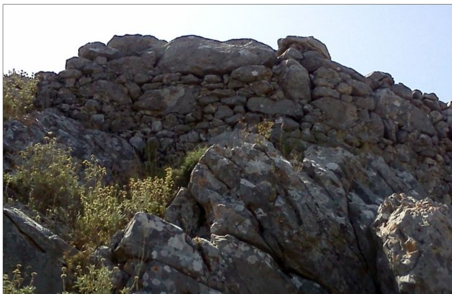
Fig. 2 - Rempart sud-ouest vue vers le nord-est, cliché Guintrand 2015
