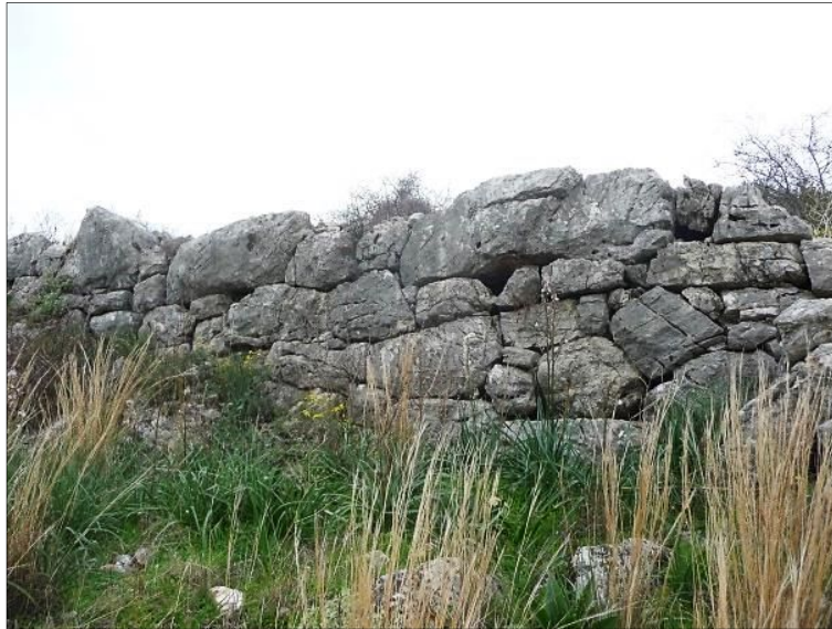
Fig. 3 - Face externe du rempart de Paralio Astros, vue vers l'est, cliché Guintrand 2012
