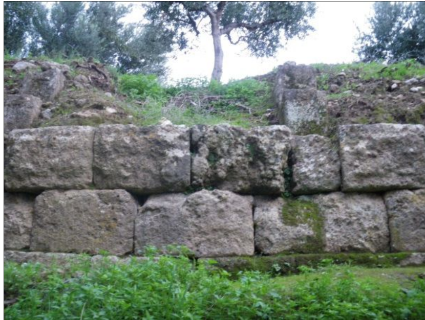
Fig. 5 - Parement externe du tronçon de courtine du rempart nord-ouest, vue vers le sud, cliché Guintrand 2008
