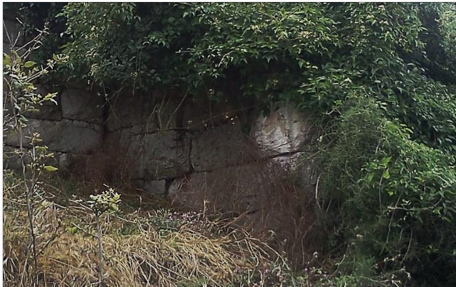
Fig. 3 - Mur est de la tour 1, vue vers l'ouest, cliché Guintrand 2015
