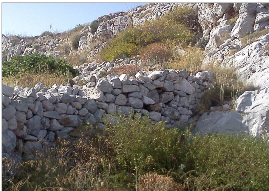
Fig. 2 - Face externe de la courtine 1 qui s'appuie contre la paroi de l'à-pic rocheux, vue vers le nord, cliché Guintrand 2015
