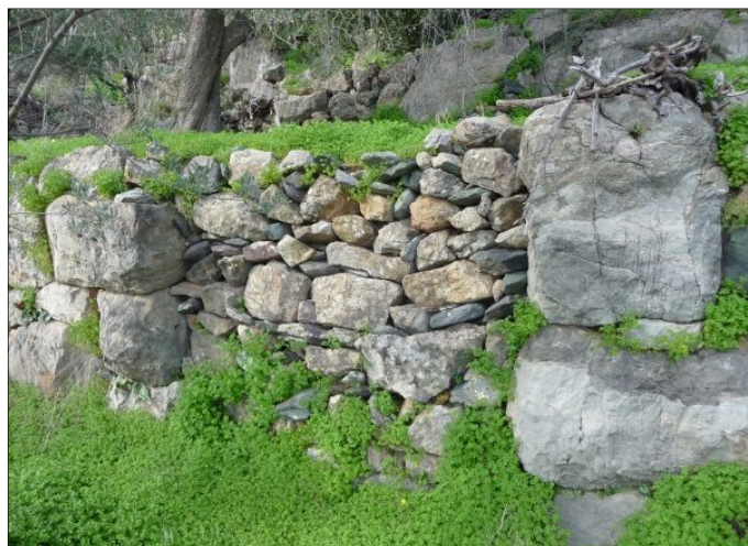
Fig. 9 - Porte bouchée au rempart sud, vue vers le nord, cliché Guintrand 2014
