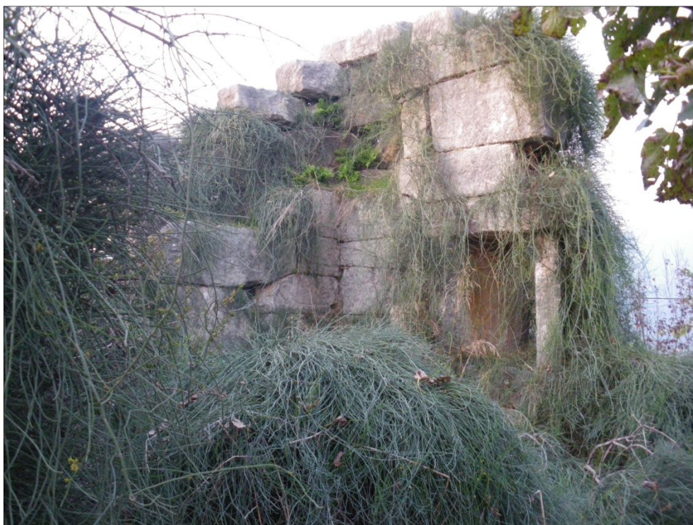
Fig. 4 - Intérieur de la tour, vue vers nord, cliché Guintrand 2009
