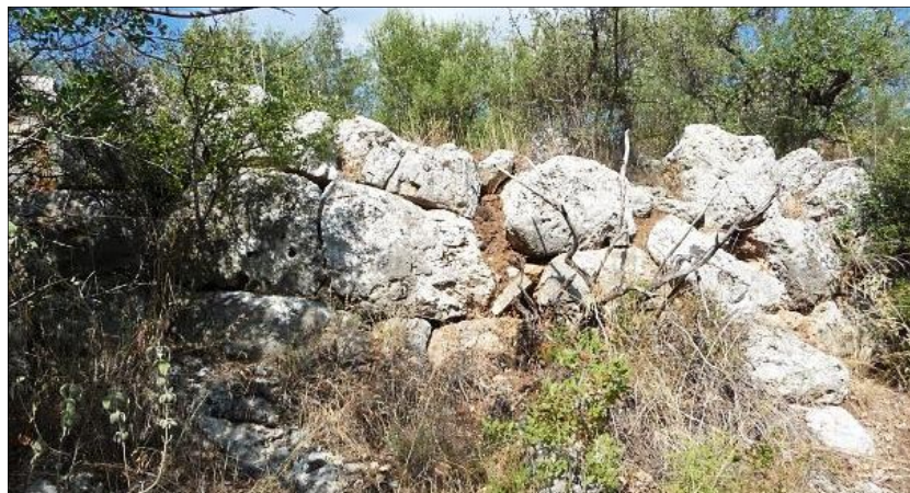
Fig. 2 - Face externe de la courtine 1, vue vers le nord, cliché Guintrand 2012
