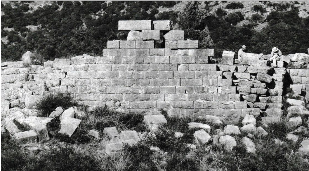
Fig. 21 - Tour 7 vue vers l'est (GIESE Bautechnische , 2010, p. 92 Fig. 4)
