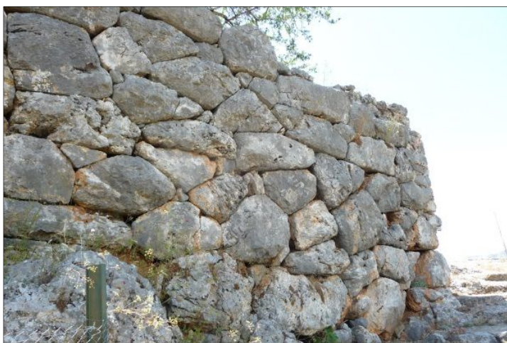
Fig. 4 - Face externe du mur du tronçon 3, vue vers le nord-est, cliché Guintrand 2015
