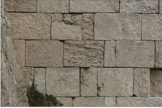
Fig. 4 - Détail mur sud tour en appareil isodome, cliché Guintrand 2014
