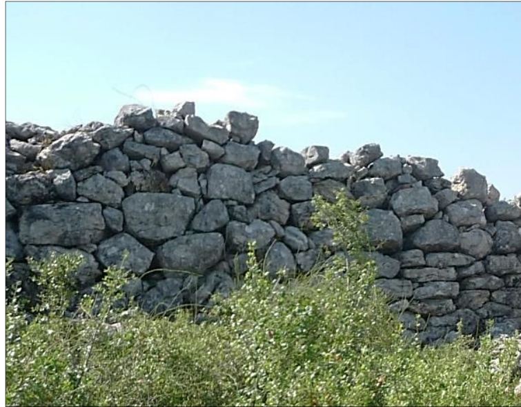
Fig. 4 - Parement externe de la courtine 6, vue vers le sud, cliché Guintrand 2015
