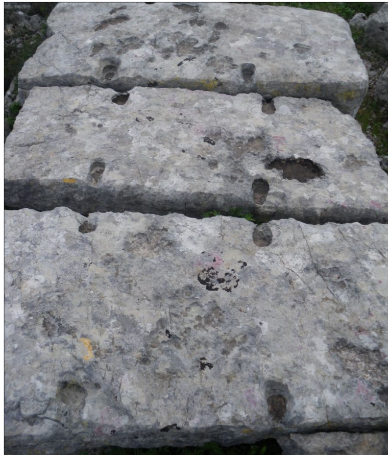
Fig. 15 - Mortaises pour scellement horizontal des dalles de circulation, vue vers le nord-est, cliché Guintrand 2008
