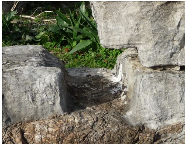
Fig. 8 - Cavité dans le jambage nord pour faire coulisser la poutrelle de fermeture du vantail, cliché Guintrand 2014
