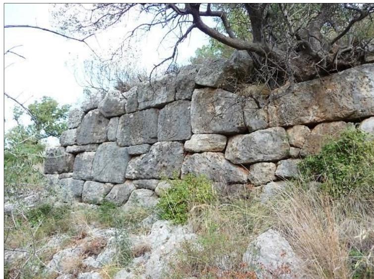
Fig. 9 - Face nord-ouest de la projection de la courtine 7, vue vers l'est, cliché Guintrand 2012
