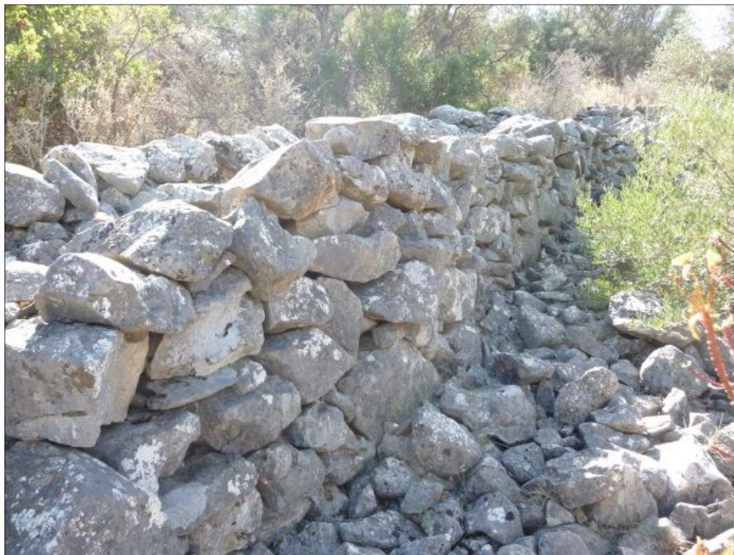
Fig. 2 - Parement externe du rempart ouest, vue vers le sud-est, cliché Guintrand 2012
