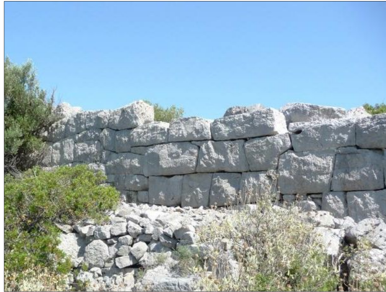
Fig. 4 - Parement externe de la courtine 10, vue vers le sud-est, cliché Guintrand 2015
