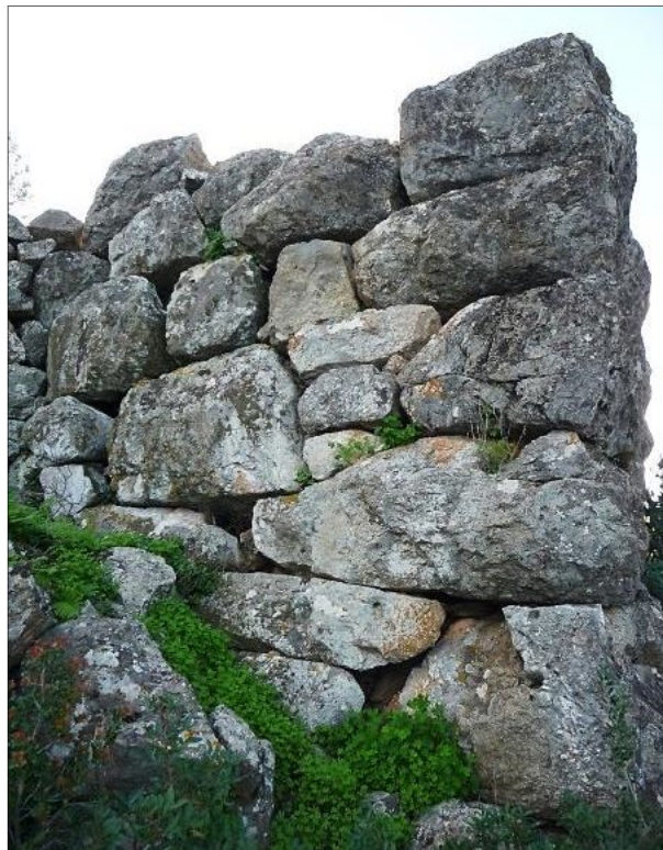
Fig. 6 - Mur nord-est de la tour 1, vue vers le sud-ouest, cliché Guintrand 2014
