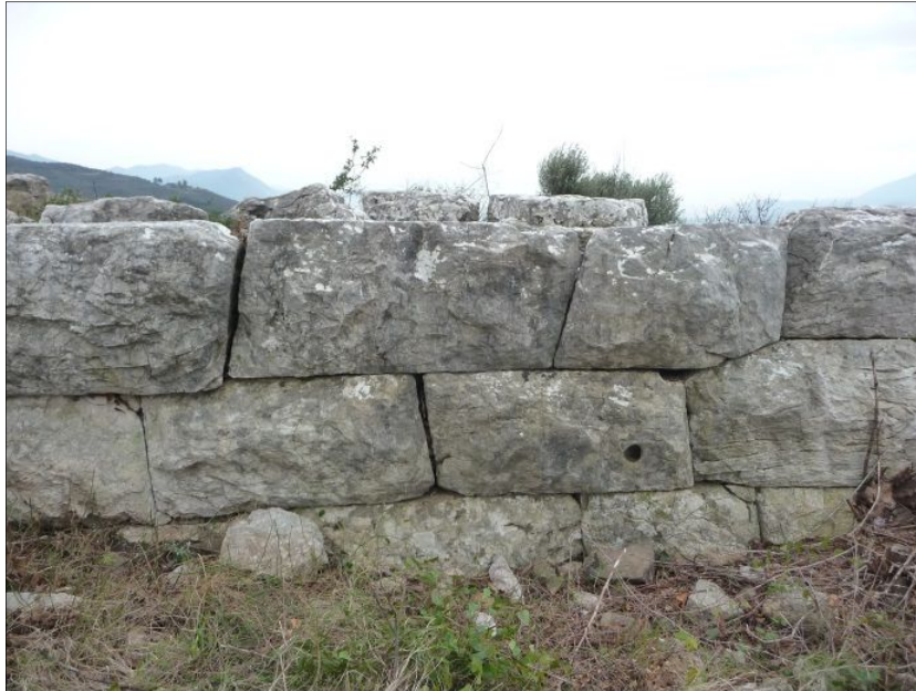
Fig. 6 - Parement interne de la courtine 8, vue vers le sud, cliché Guintrand 2014
