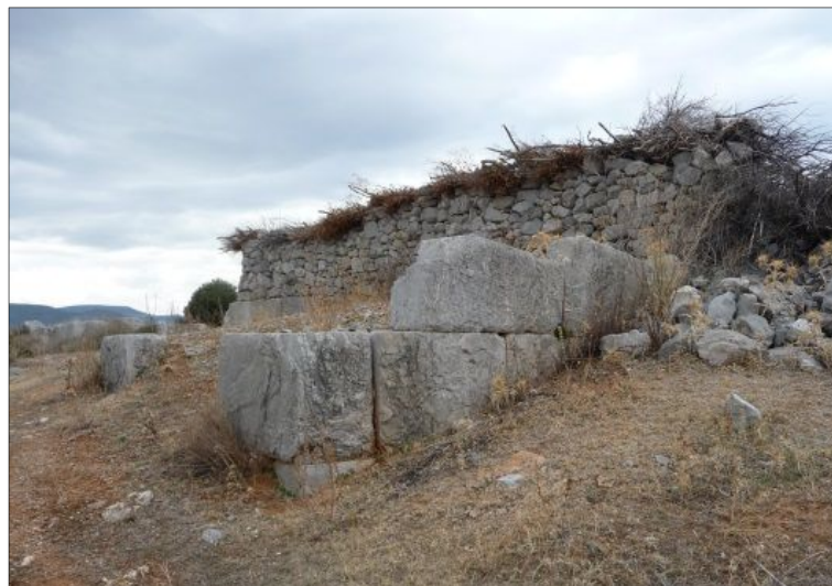
Fig. 11 - Angle sud-est de la tour 12, vue vers le nord-ouest, cliché Guintrand 2012
