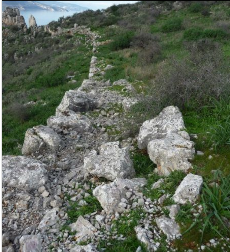
Fig. 5 - Parement interne du rempart de Paralio Astros, vue vers le nord, cliché Guintrand 2014
