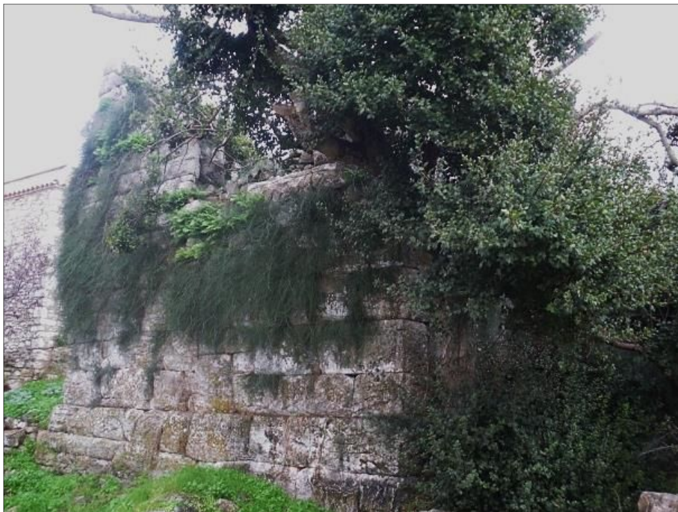
Fig. 3 - Angle ouest de la tour quadrangulaire, vue vers le nord-est, cliché Guintrand 2009
