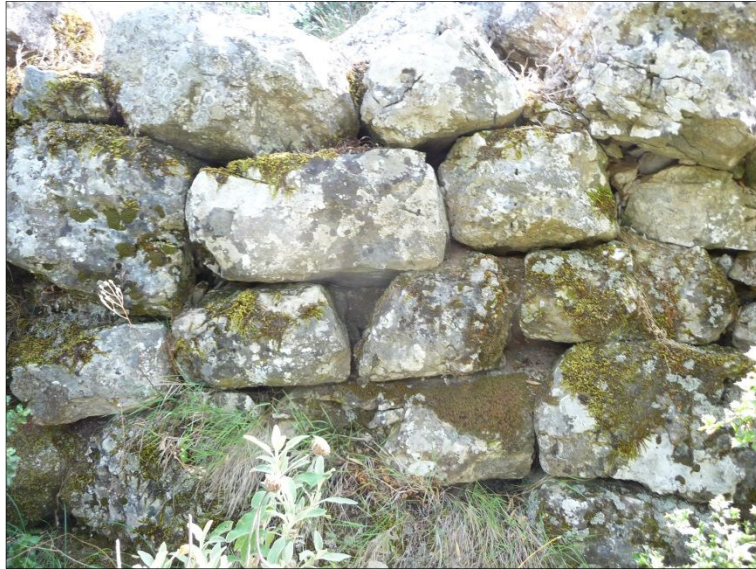
Fig. 2 - Parement externe du mur du rempart nord, vue vers le sud, cliché Guintrand 2015
