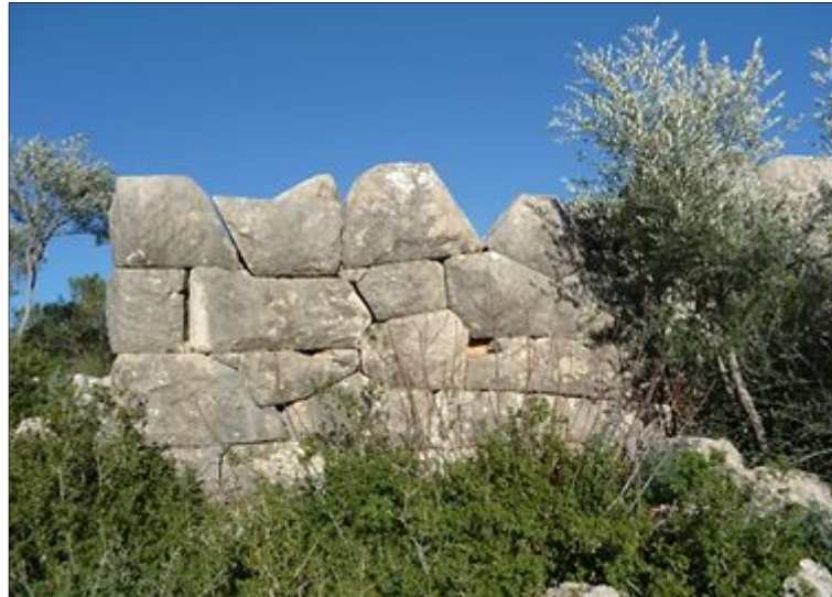
Fig. 3 - Parement externe du mur sud de la tour de Charadros, vue vers le nord-est, cliché Guintrand 2014
