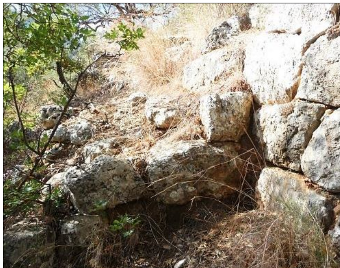
Fig. 4 - Mur est de la tour 1, vue vers l'ouest, cliché Guintrand 2012
