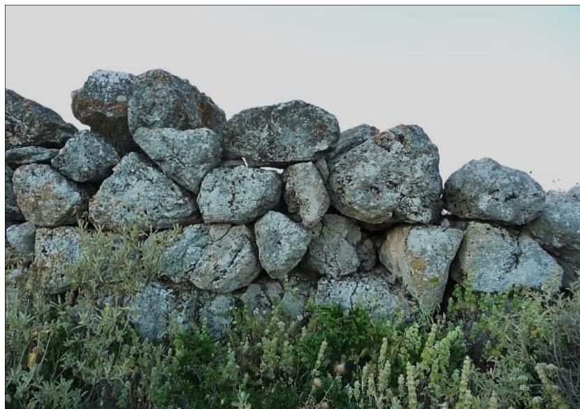
Fig. 2 - Face externe du mur nord, vue vers le sud, cliché Guintrand 2015
