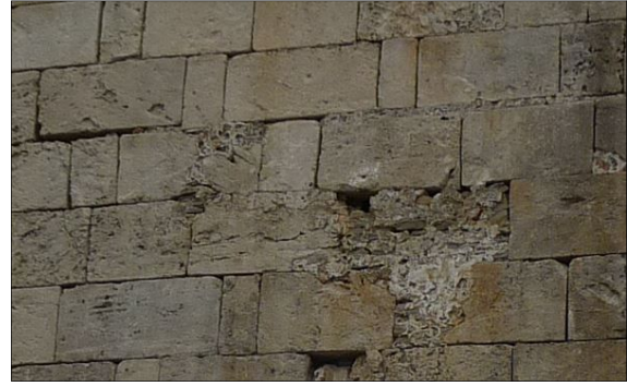
Fig. 5 - Détail de la face de la tour en appareil isodome, cliché Guintrand 2014
