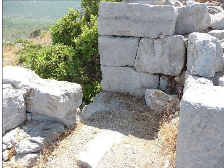
Fig. 6 - Porte d'accès à la tour, vue vers le sud-ouest, cliché Guintrand 2015
