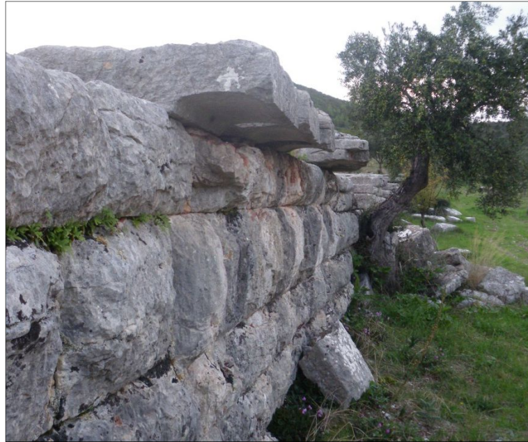
Fig. 18 - Dalles du chemin de ronde de la courtine 14, vue vers le nord, cliché Guintrand 2008
