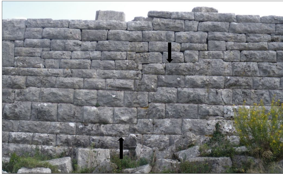
Fig. 14 - Parement externe de la courtine 10 avec jonction entre le travail de deux équipes différentes, vue vers le sud-est, cliché Guintrand 2008
