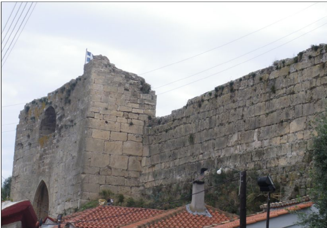
Fig. 2 - Rempart nord de la forteresse vénitienne avec remploi des blocs antiques, vue vers l'est, cliché Guintrand 2008
