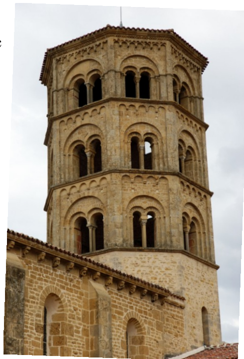
Face sud-ouest du clocher. Cliché de l'auteur.
