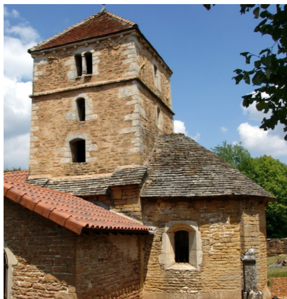
Face sud du clocher. Cliché de l'auteur.
