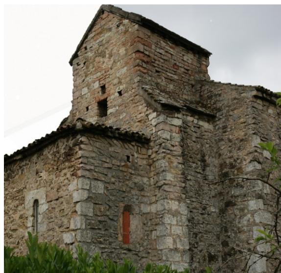
Face nord-est du clocher. Cliché de l'auteur.
