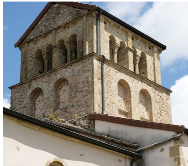
Face sud-ouest. Cliché de l'auteur.
