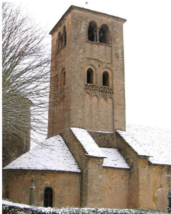
Face nord-est du clocher. Cliché de l'auteur.
