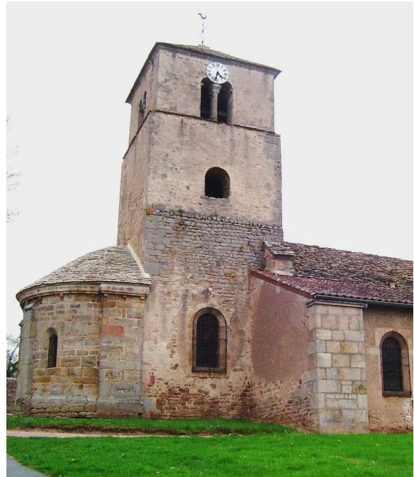
Face nord du clocher. Cliché de l'auteur.
