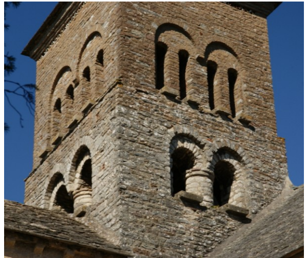
Face sud du clocher. Cliché de l'auteur.
