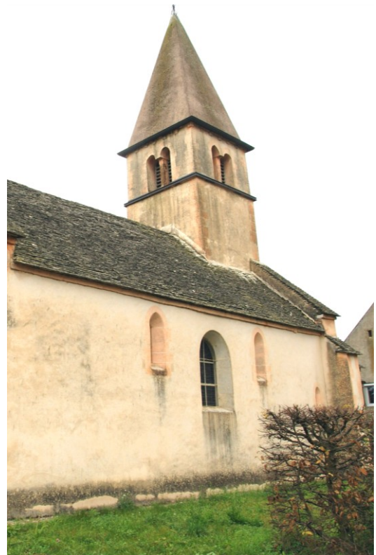
Face sud-ouest du clocher. Cliché de l'auteur.
