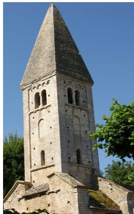
Face nord-est du clocher. Cliché de l'auteur.
