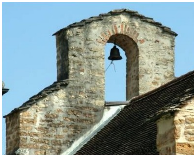
Face ouest. Cliché de l'auteur.
