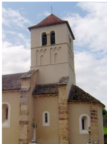
Face sud-ouest du clocher. Cliché de l'auteur.
