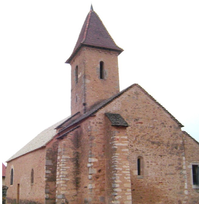
Chevet plat, face est. Cliché de l'auteur.
