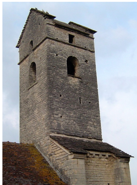
Face sud-ouest du clocher. Cliché de l'auteur.
