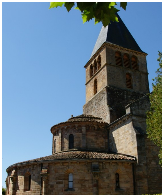
Face nord-est du clocher. Cliché de l'auteur.
