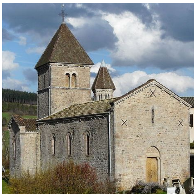
Face nord-ouest. Cliché de l'auteur.
