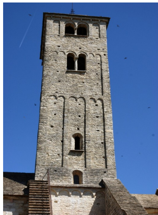
Face sud du clocher. Cliché de l'auteur.
