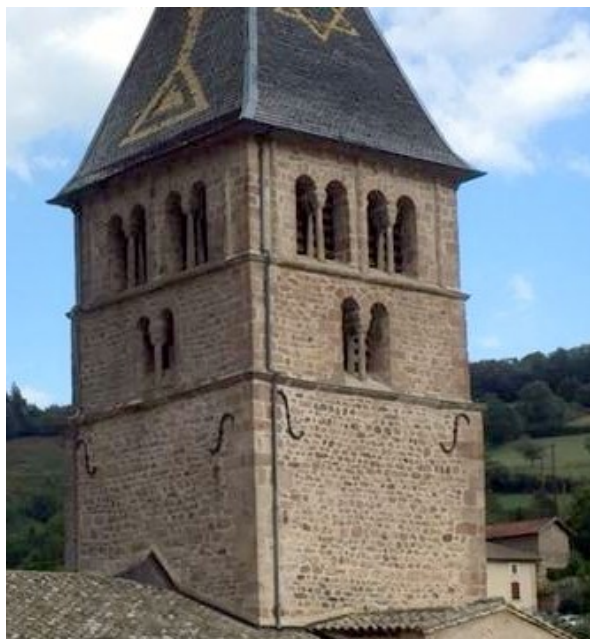
Face sud-ouest. Cliché de l'auteur.
