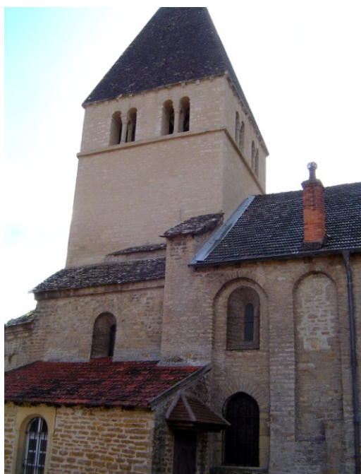
Face nord du clocher. Cliché de l'auteur.
