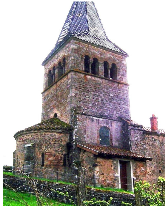
Face nord-est du clocher. Cliché de l'auteur.
