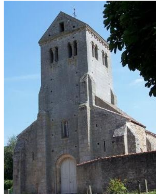
Face sud-ouest du clocher. Cliché de l'auteur.
