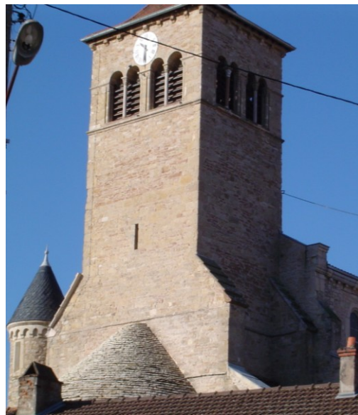
Face nord-est du clocher. Cliché de l'auteur.
