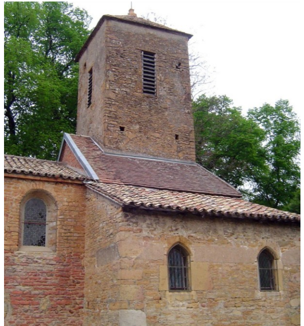
Face sud-ouest. Cliché de l'auteur.
