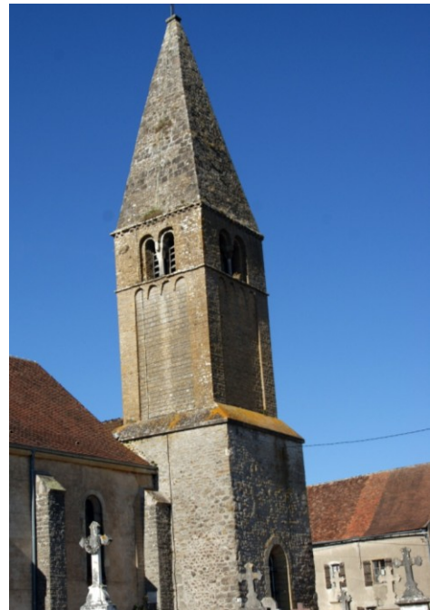
Face sud-ouest du clocher. Cliché de l'auteur.
