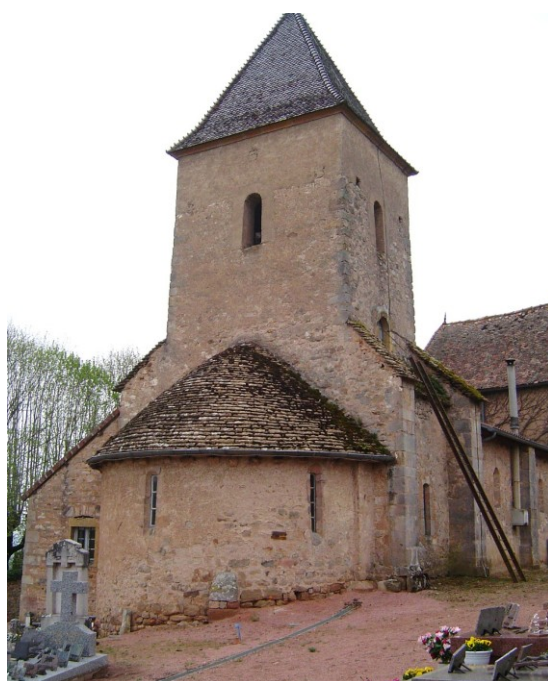
Face nord-est du clocher. Cliché de l'auteur.
