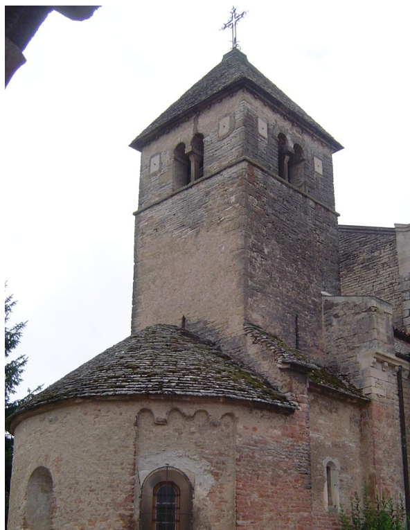
Face nord-est du clocher. Cliché de l'auteur.
