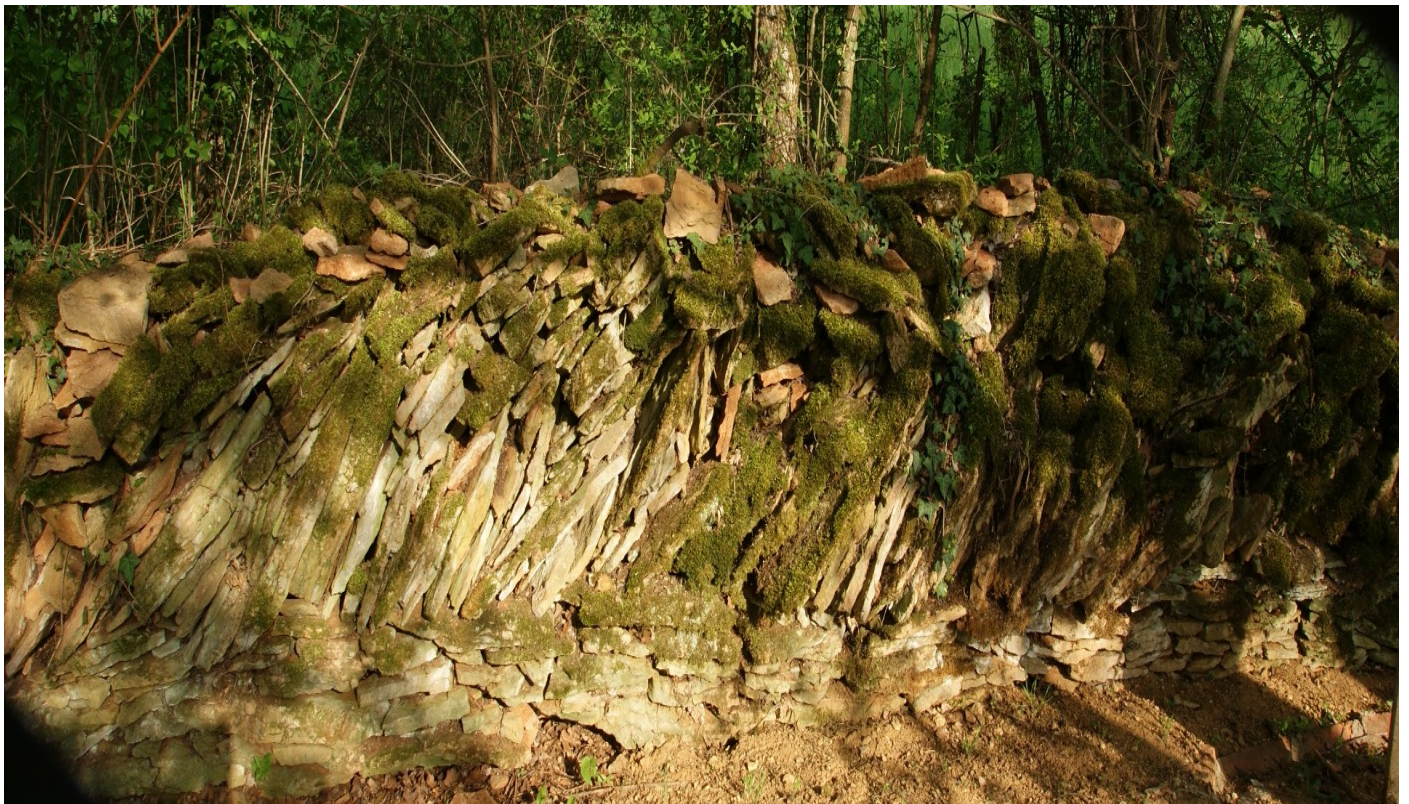
Fig. 8) Murget fait de plaques de calcaire mises de champ. Cliché de l'auteur.
