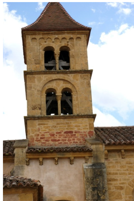
Face sud du clocher. Cliché de l'auteur.
