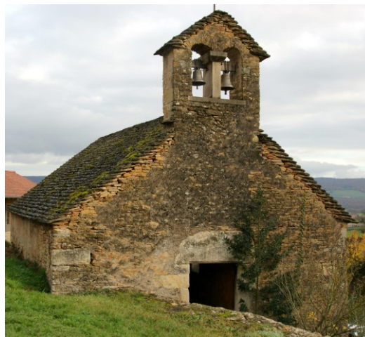
Face ouest. Cliché de l'auteur.
