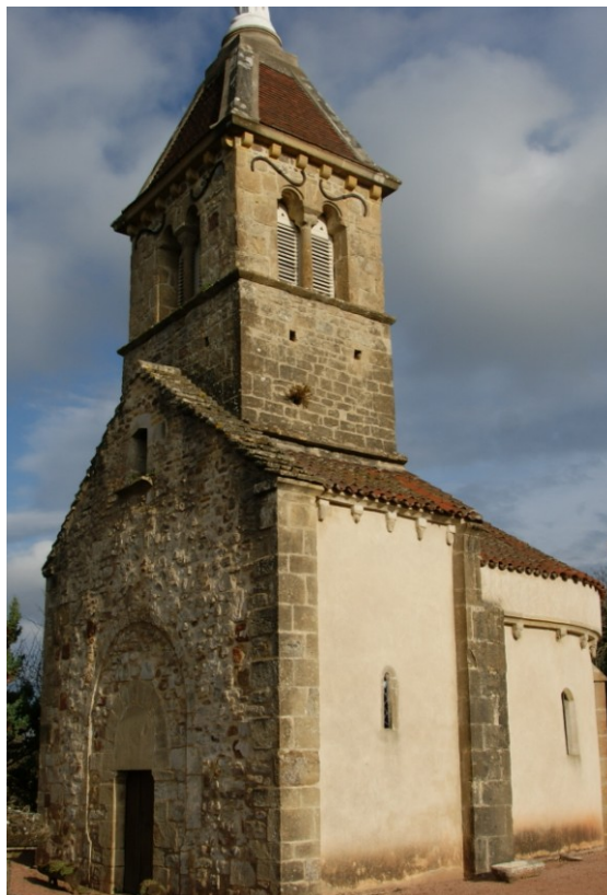
Face sud-ouest du clocher. Cliché de l'auteur.
