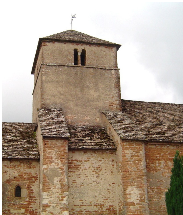
Face nord du clocher. Cliché de l'auteur.
