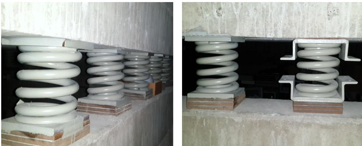
*Figure 4. 10 : Liaisons entre les chambres et leurs fondations - suspension élastique.*
