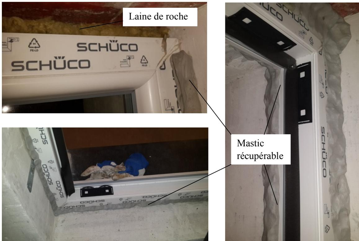
Figure 4. 15 : Etanchéité du pourtour : laine de roche et mastic acoustique.
