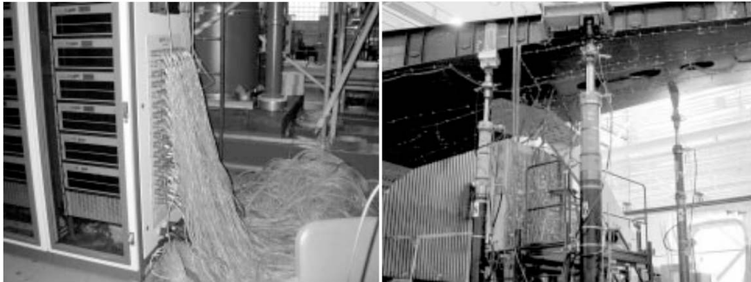
FIGURE 7 – Photos représentant le câblage nécessaire au suivi d'un essai sur une aile en composite. Le coût estimé pour les 182 jauges et leur installation représente un total de 10 000 $ [Childers et al. , 2001]
