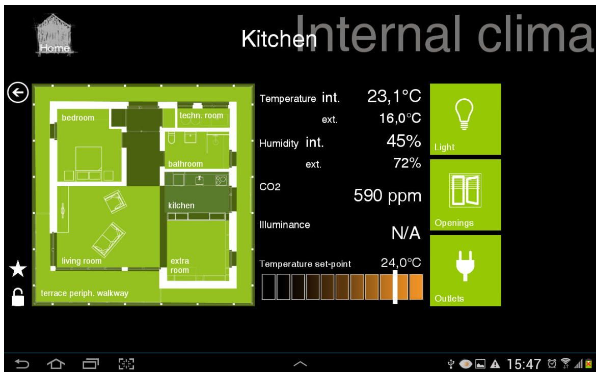
FIGURE III.39 – Tableau de commande de l'habitat
