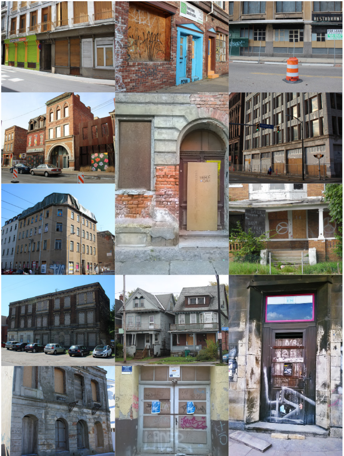
FIGURE 52 – Dispositifs de fermeture des bâtiments 1/2 (photographies et montage réalisés par Charline Sowa).
