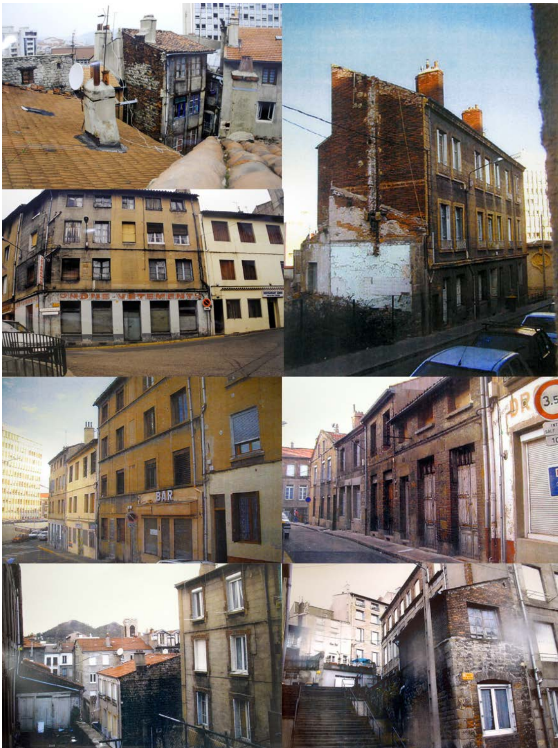
FIGURE A.7 – Saint-Étienne : état de l'îlot avant la mise en œuvre du projet Îlot-test Franche-Amitié. Auteur : Municipalité de Saint-Étienne.
