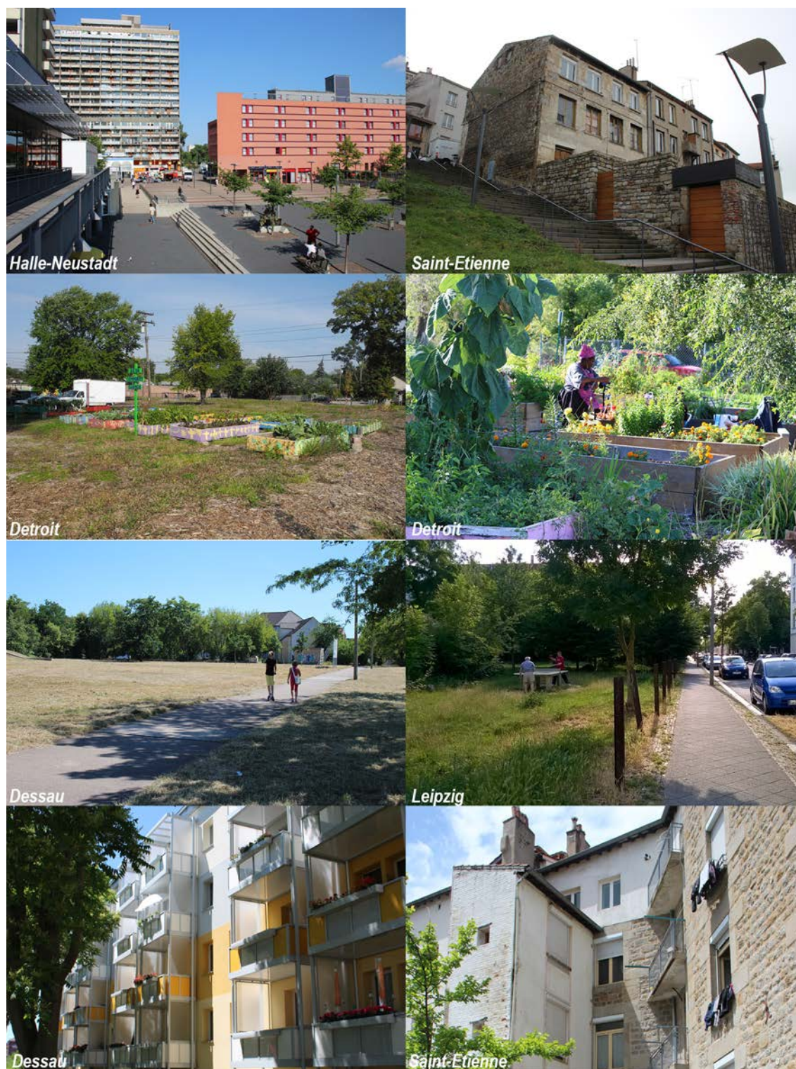
FIGURE 131 – Amélioration de la qualité des logements, du bâti et des espaces publics et collectifs de proximité (photographies réalisées par Charline Sowa).
