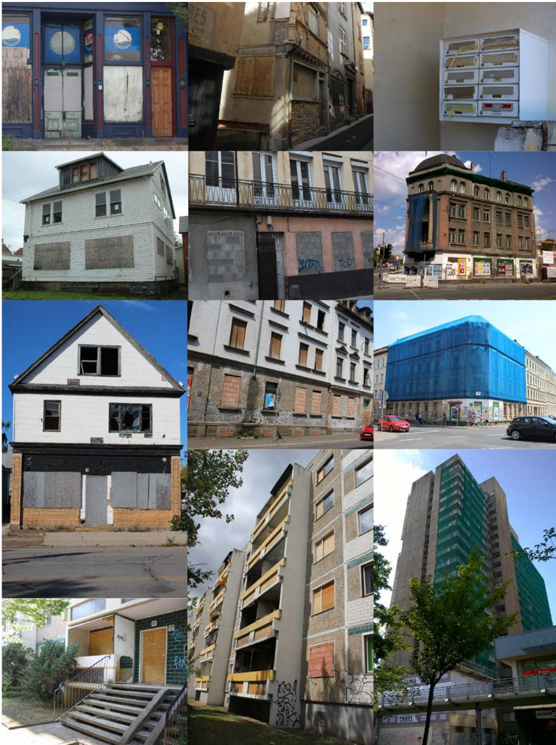
FIGURE 53 – Dispositifs de fermeture des bâtiments 2/2 (photographies et montage réalisés par Charline Sowa).
