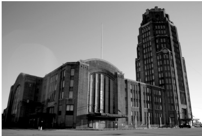
Buffalo Central Terminal, Buffalo (États-Unis), octobre 2014
