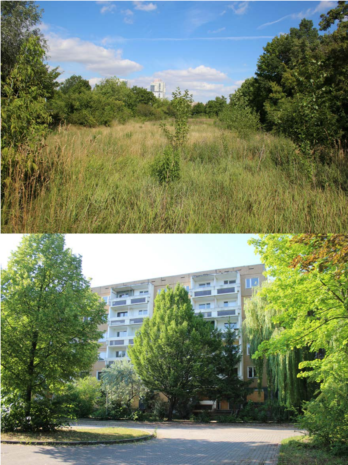
FIGURE 106 – En haut : Espace ouvert libéré à après démolition non entretenu à l'ouest du site. En bas : bâtiment en attente d'intervention au sud du site (photographies réalisées par Charline Sowa, Halle, juillet 2015).
