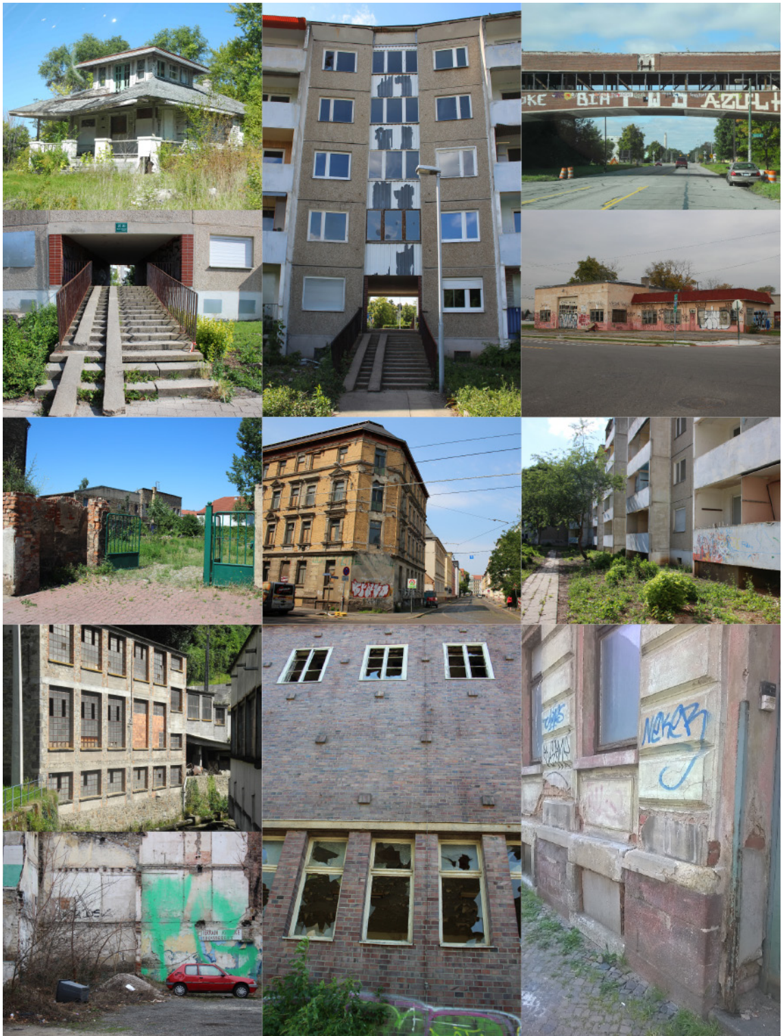
FIGURE 50 – Dégradation des bâtiments par l'homme 1/2 (photographies et montage réalisés par Charline Sowa).
