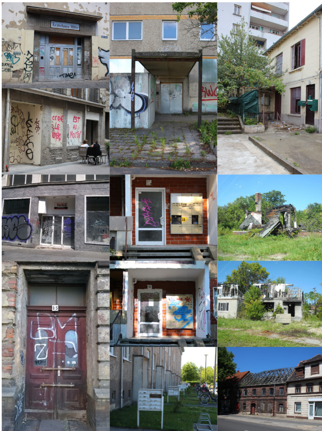
FIGURE 51 – Dégradation des bâtiments par l'homme 2/2 (photographies et montage réalisés par Charline Sowa).
