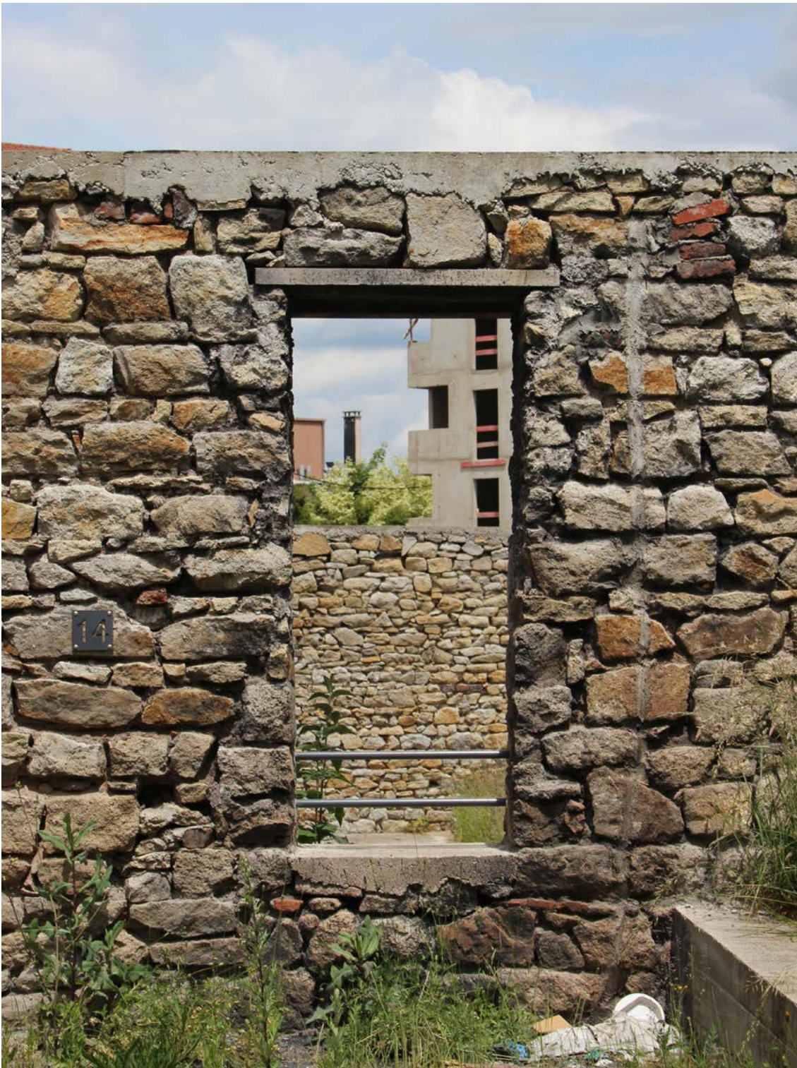
FIGURE 113 – Aménagements des murs de séparation des propriétés réalisés dans le cadre de l'Îlot-test Franche-Amitié (photographie réalisée par Charline Sowa, juin 2014).
