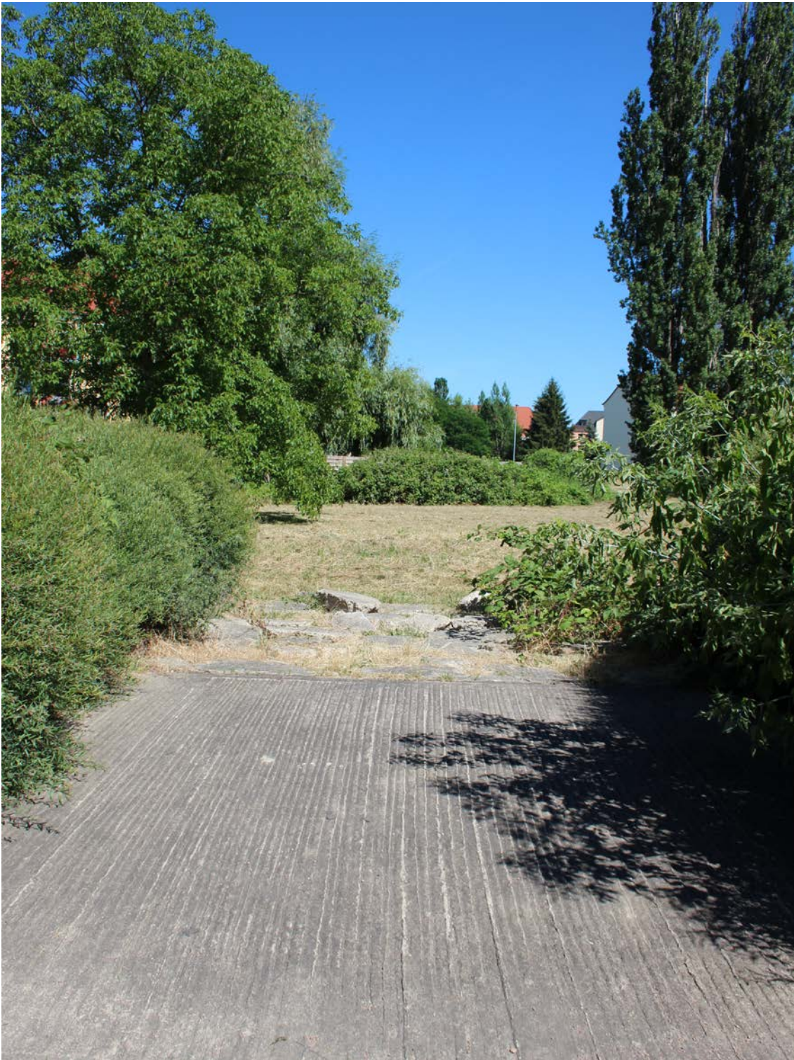
FIGURE 112 – Aménagements des abords de Gartenstraße, réalisés à Dessau, à partir de matériaux issus de la déconstruction (photographie réalisée par Charline Sowa, juillet 2015).
