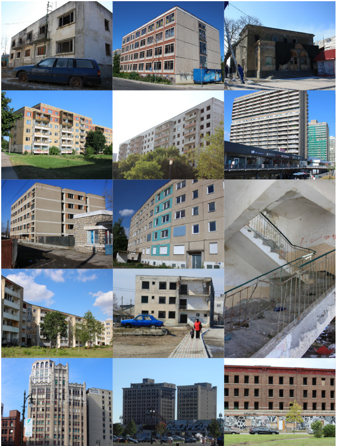
FIGURE 48 – Diversité du bâti. Des quartiers de logements collectifs aux immeubles de grandes hauteurs (photographies et montage réalisés par Charline Sowa).
