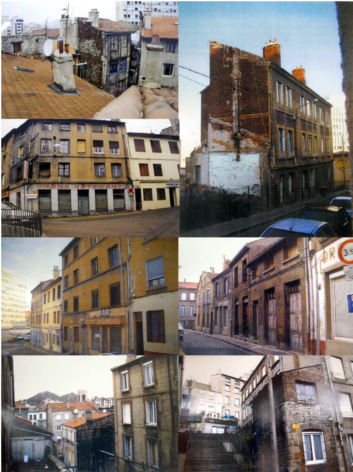
FIGURE A.7 – Saint-Étienne : état de l'îlot avant la mise en œuvre du projet Îlot-test Franche-Amitié. Auteur : Municipalité de Saint-Étienne.
