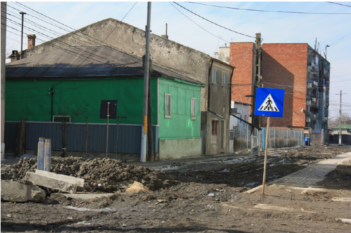
FIGURE 34 – Sulina, février 2011 (photographies réalisées par Charline Sowa).
