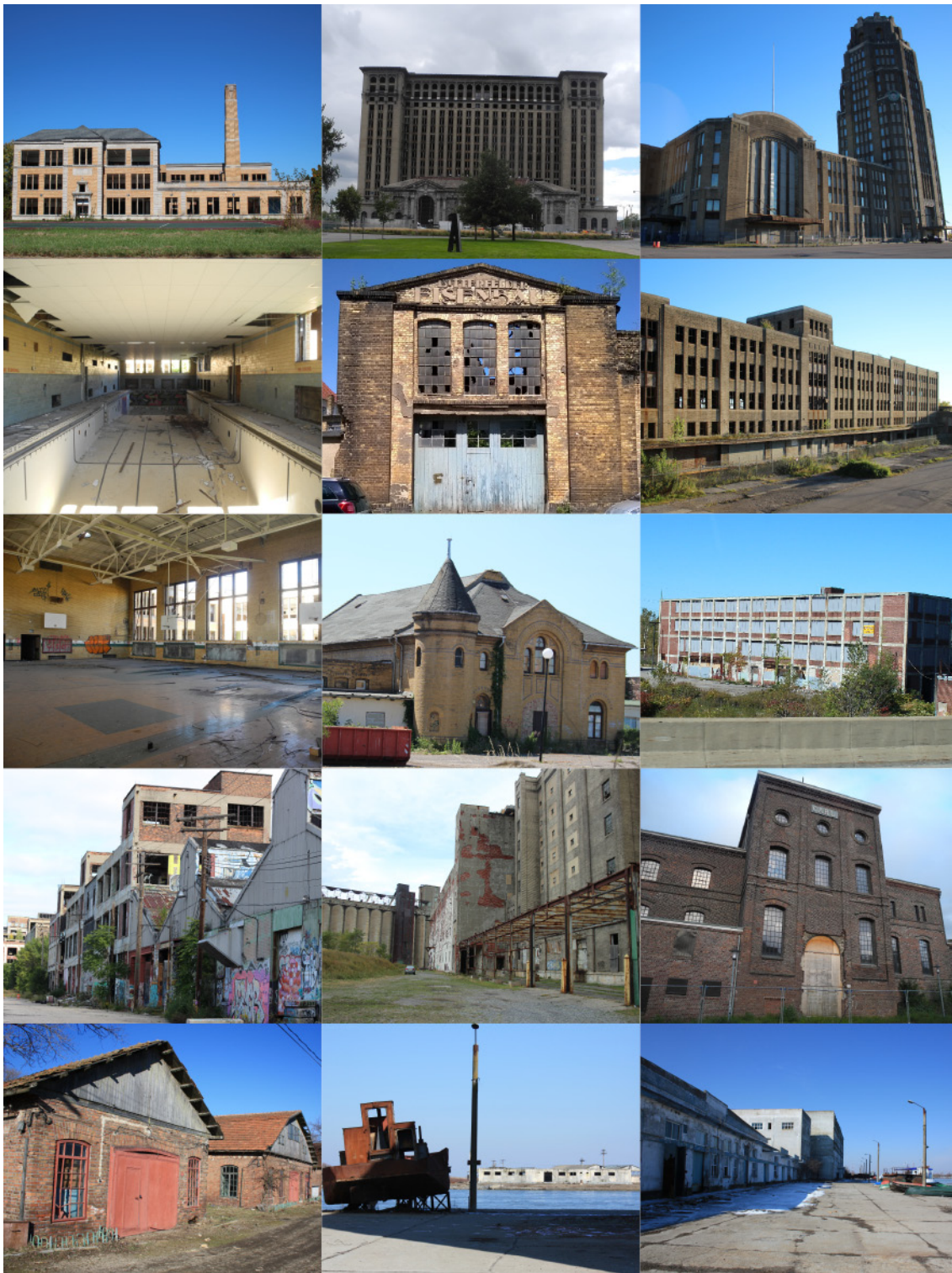
FIGURE 49 – Diversité du bâti. Des équipements aux différents usages : écoles, industries, entrepôt, gymnase, gares, etc. (photographies et montage réalisés par Charline Sowa).
