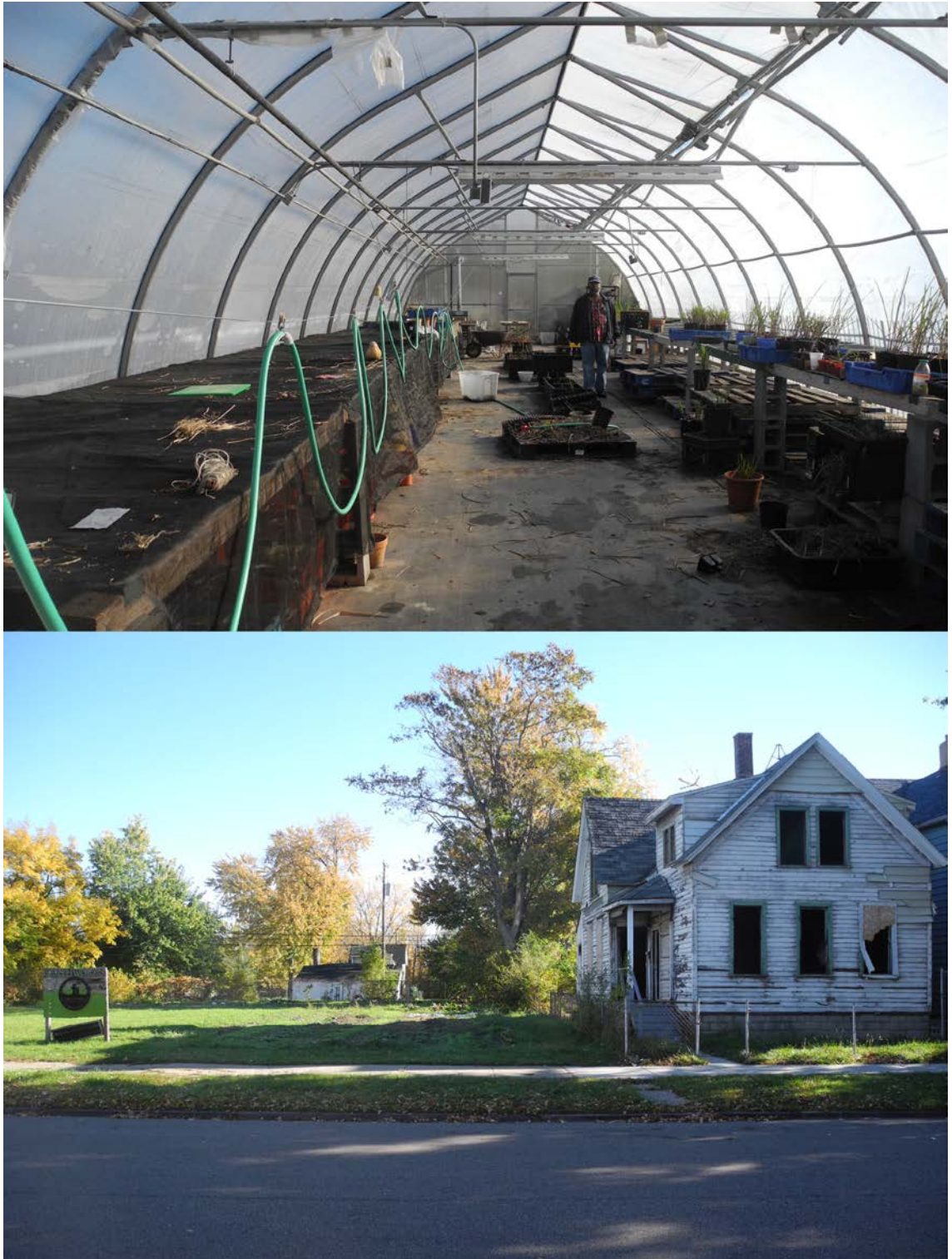
FIGURE C.6 – Detroit : Projet de ferme urbaine dans le quartier de Meldrum Street (photographies réalisées par Charline Sowa, septembre 2014).
