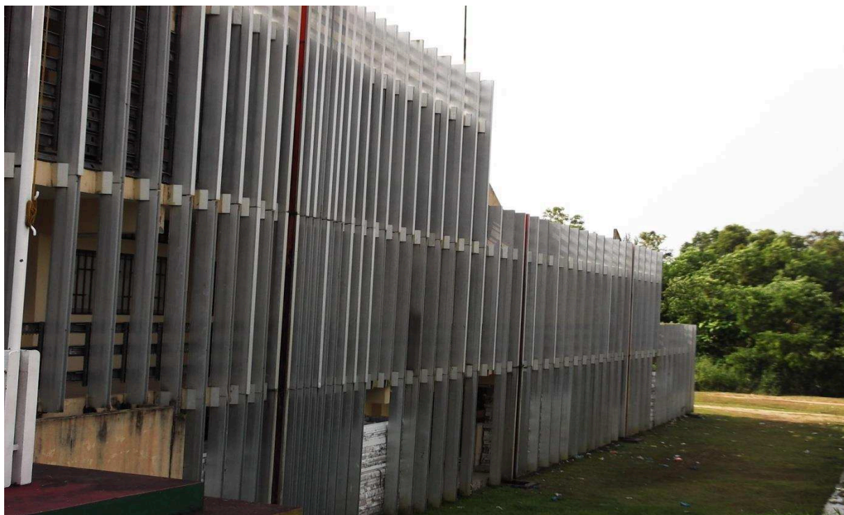
L'aile droite de l'établissement abritant au rez de chaussée le centre de médecine sportive, au premier étage les bureaux de l'administration et au-dessus un espace de jeu à l'air libre.
