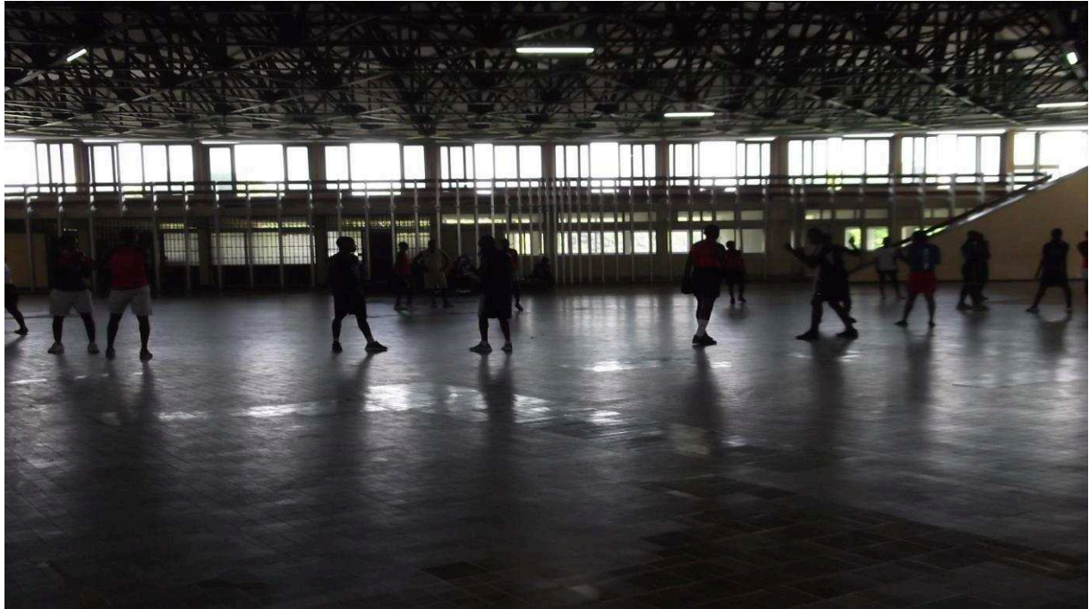
Un préau permettant la pratique d'activités sportive en plein air, avec au fond une vue d'autres salles de classe.
