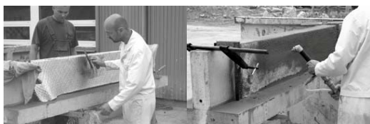
(a) Mise en place direct sur la poutre (Blanksvärd et al [94])
