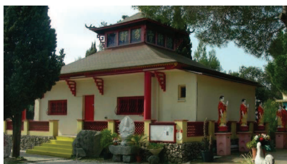
Fig. 25 – Bâtiment de culte et d'accueil, pagode Hong Hien, Fréjus
