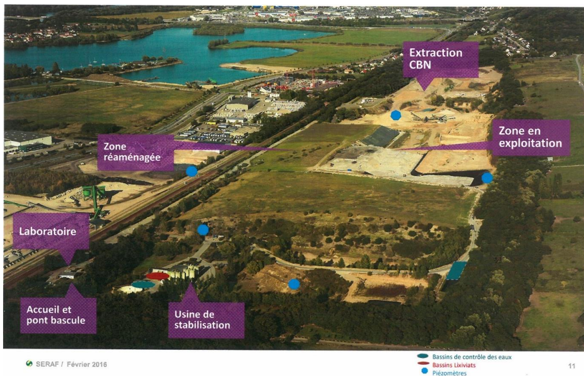
Figure 11 - Vue aérienne de SERAF (document interne transmis le 08/04/2016)
