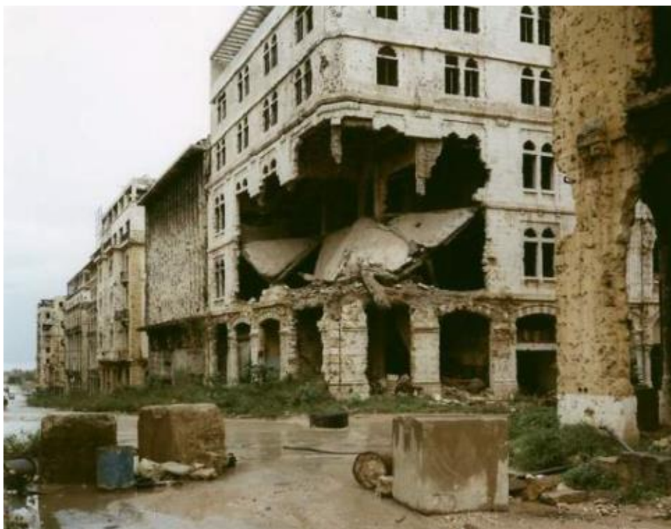
Figure 4 : Le centre-ville en ruines à la fin de la guerre civile Photographie G. Basilio, 1991
