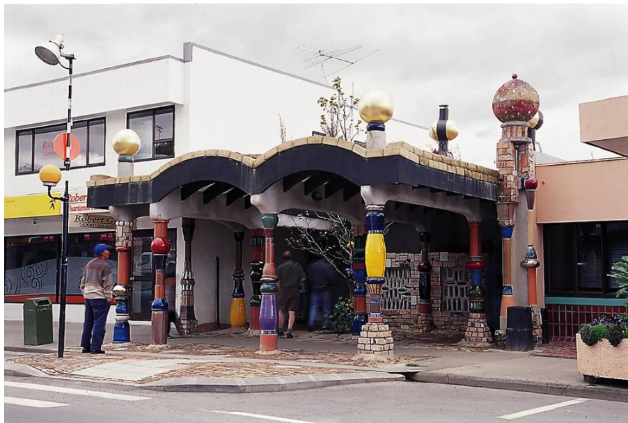
Figure 65 : Toilettes publiques de Kawakawa Friedensreich Hundertwasser, 1999 960
