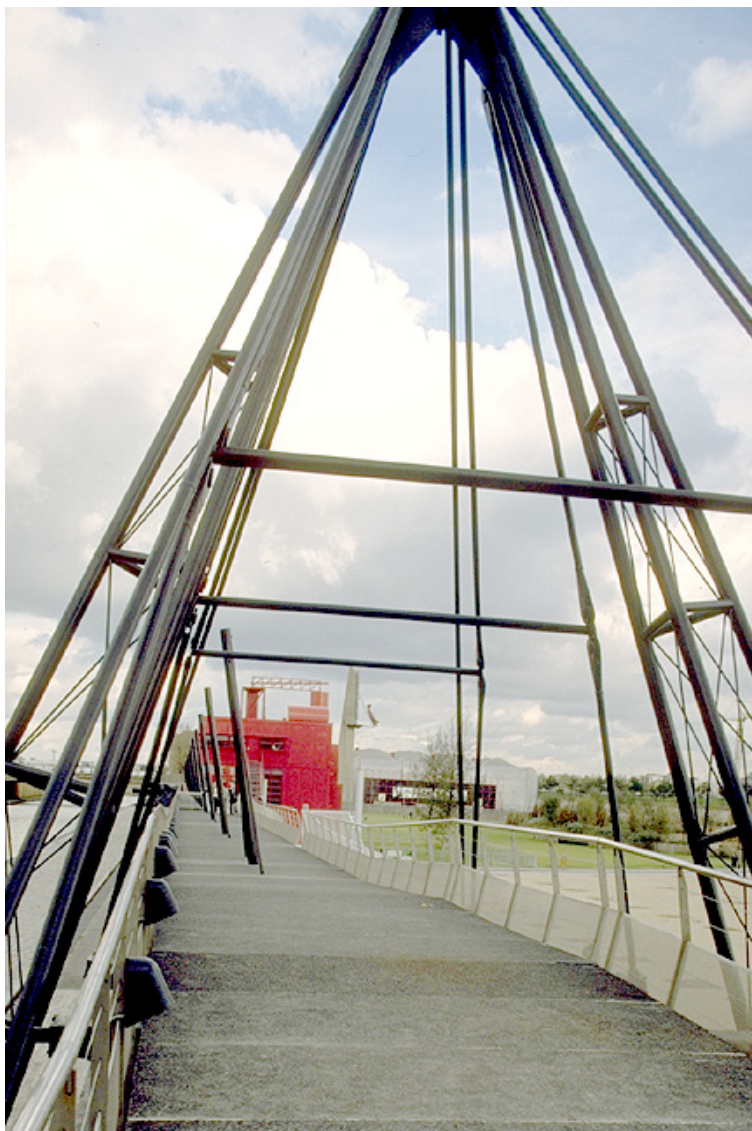
Fig. 4.20 a - La Villette. Passerelle. (PH nov. 1987)
