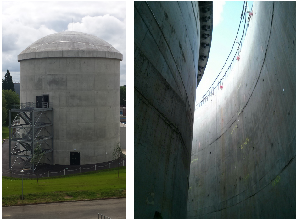
(a) Enceinte à l'échelle 1/3. (b) Espace entre enceintes avant la pose des dôme.
