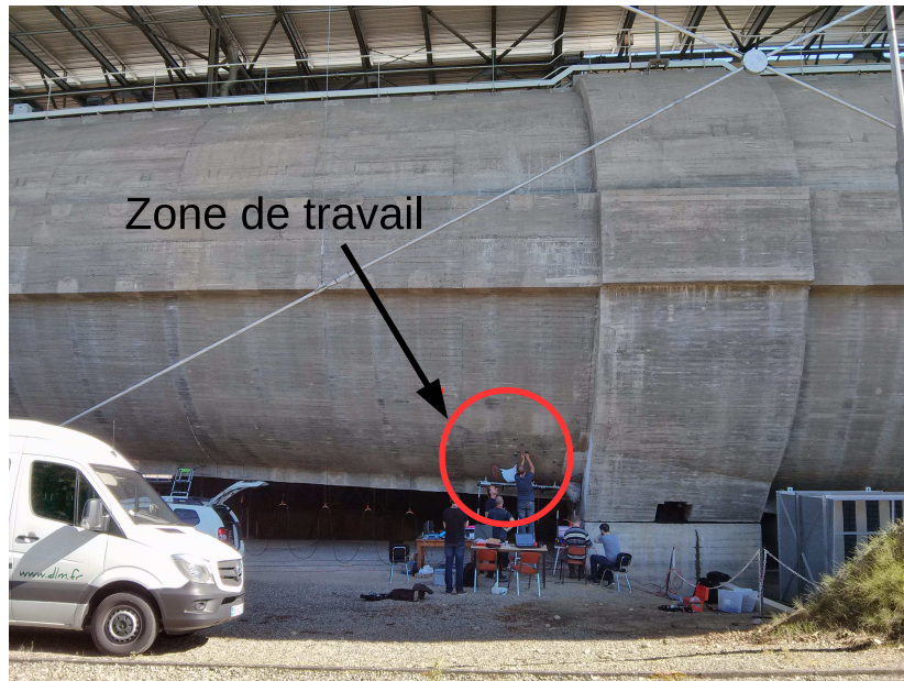
FIGURE 5.3 – Zone de travail sur la structure.
