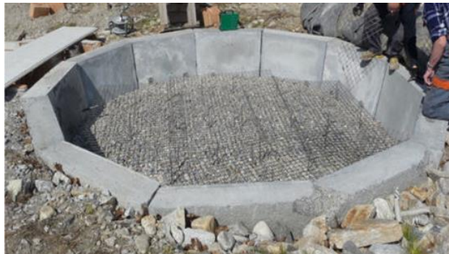
Figure 14 : Photographie de la cuve de stockage de l'ETH-Zurich
