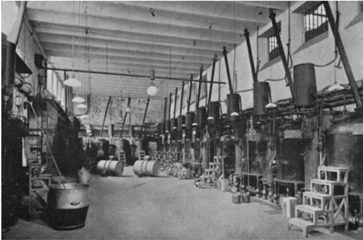
Usine Chiris, salle des distillations aux environs de 1900
