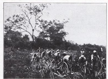
Défrichement de la concession Trantoul. Photo Trantoul.
