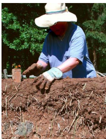
FIGURE 1.11 – Un mur en bauge en construction en France.
