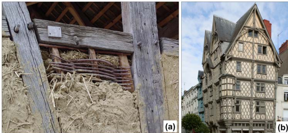
FIGURE 1.10 – (a) La technique du torchis illustrée ; (b) Une construction en torchis à Angers, France.
