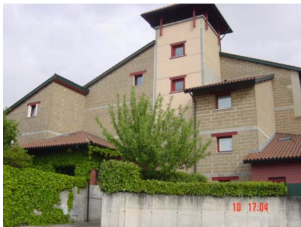
FIGURE 1.9 – Maison construite avec des BTC (dont la tour est en pisé) en Rhône-Alpes, France.
