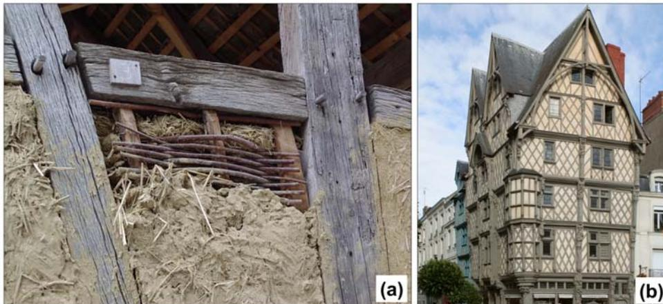
FIGURE 1.10 – (a) La technique du torchis illustrée ; (b) Une construction en torchis à Angers, France.
