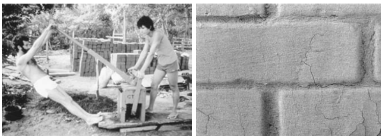
FIGURE 1.8 – Presse CINVA RAM, Paraguay ; un mur en BTC, d'après [38].
