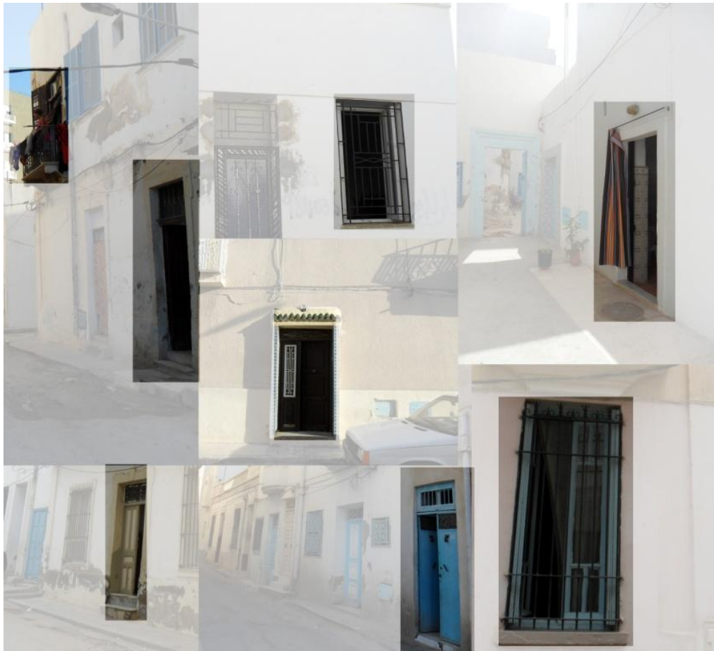
Figure 189_ Portes et fenêtres ouvertes_ Capaci Piccolo _Capaci Gtrandi _ 2012_ Crédit de l'auteur _
