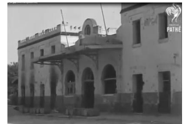
Figure 27 _ La Gare après les bombardements _ Vidéo Pathé _
