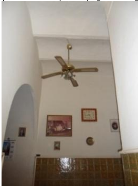
Figure 164_ Intérieur d'une habitation sicilienne à Capaci Grandi _Propriétaire Ommi Hallouma _ détail du plancher_ Photo crédit de l'auteur_2012_
