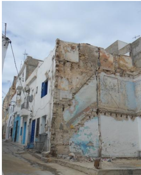
Figure 44 _ Capaci Grandi _ Itinéraire avec le maçon _ Ruine et traces 1 _ 2012
