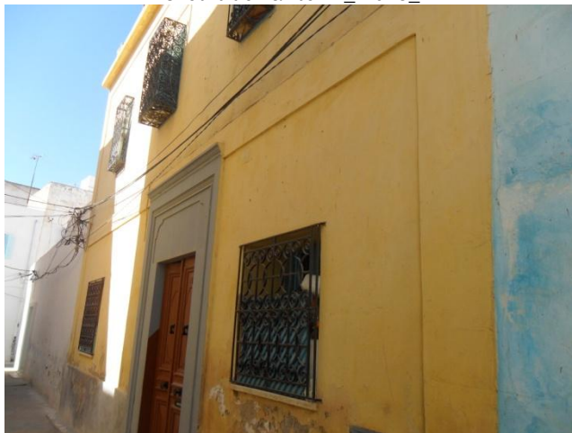
Figure 110 _ Façade rue de Moritanie_ Capaci Grandi _Crédit de l'auteur _ 2012_
