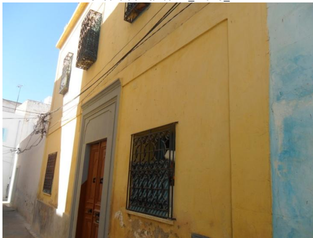
Figure 110 _ Façade rue de Moritanie_ Capaci Grandi _Crédit de l'auteur _ 2012_
