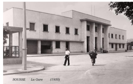
Figure 80 _ Bâtiment de la gare_ 1950_ Carte postale _ Collection privée _ Giuseppe Mancino
