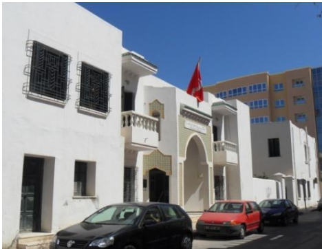
Figure 71 _ Façade latérale _ Bâtiment Recette des finances_ Crédit de l'auteur _ 2012 _
