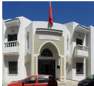
Figure 72 _ Façade latérale _ Bâtiment Recette des finances_ Crédit de l'auteur _ 2012 _
