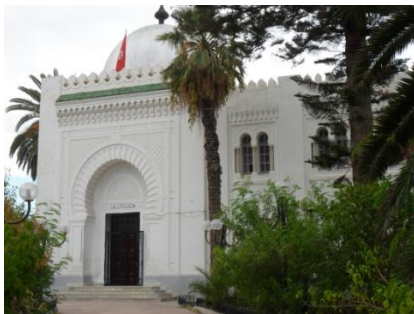
Figure 67 _ Palais de Justice_ Place de la Gare _ Crédit de l'auteur_
