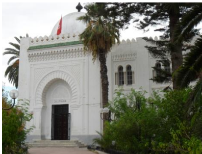
Figure 67 _ Palais de Justice_ Place de la Gare _ Crédit de l'auteur_
