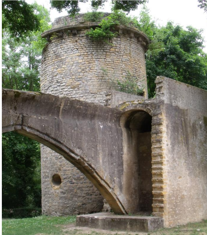
Figure 51 : L'accès au chemin de ronde sur le sommet du pont par la tour des Barbiers et des Chandeliers de cire
