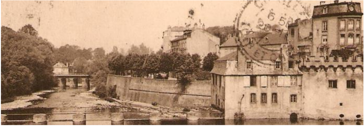
Figure 36 : La vanne des Pucelles et le Moyon-Pont à la fin du XIX e siècle
