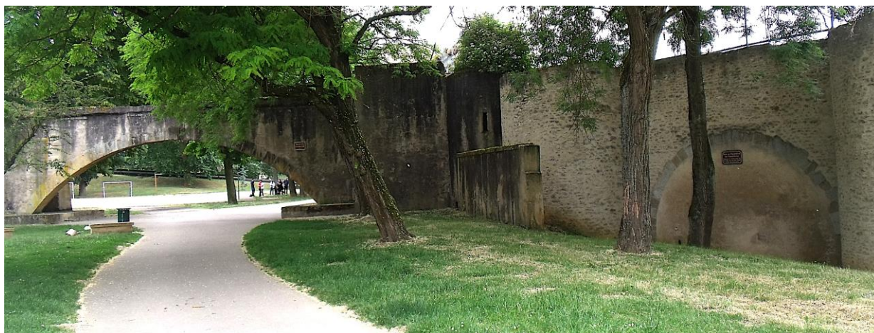
Figure 49 : Le pont se raccordant à la poterne en Chadeleirue
