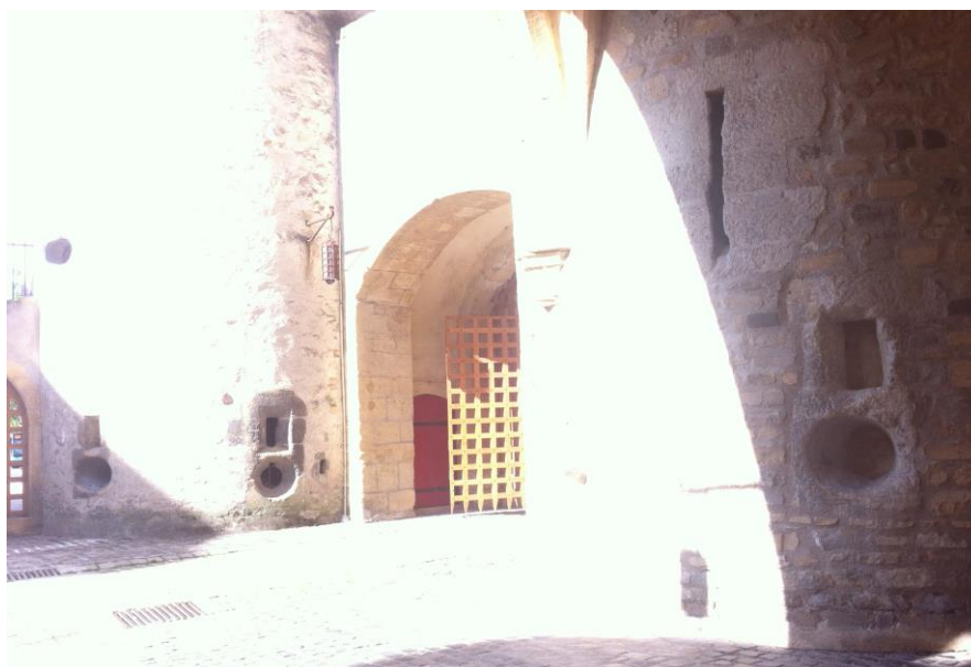
Figure 65 : Les canonnières percées dans les tours du XIII e siècle de la porte des Allemands lors de la campagne de travaux de 1445
