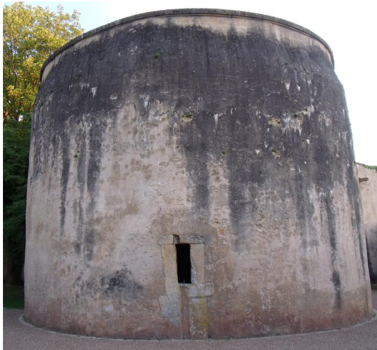
Figure 57 : Archère en partie rebouchée sur la tour du Diable qui faisait face à la confluence de la Seille et de la Moselle
