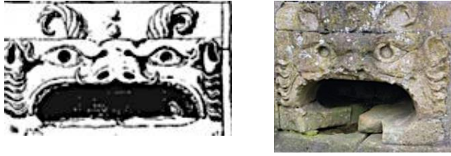
Figure 94 : Relevé de l'une des canonnières orientées au sud et photographie dans son état actuel.
