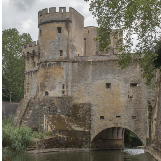
Figure 123 : Le boulevard, le « baile » de la porte des Allemands et les canonnières de la salle de tir du pont vus du nord
