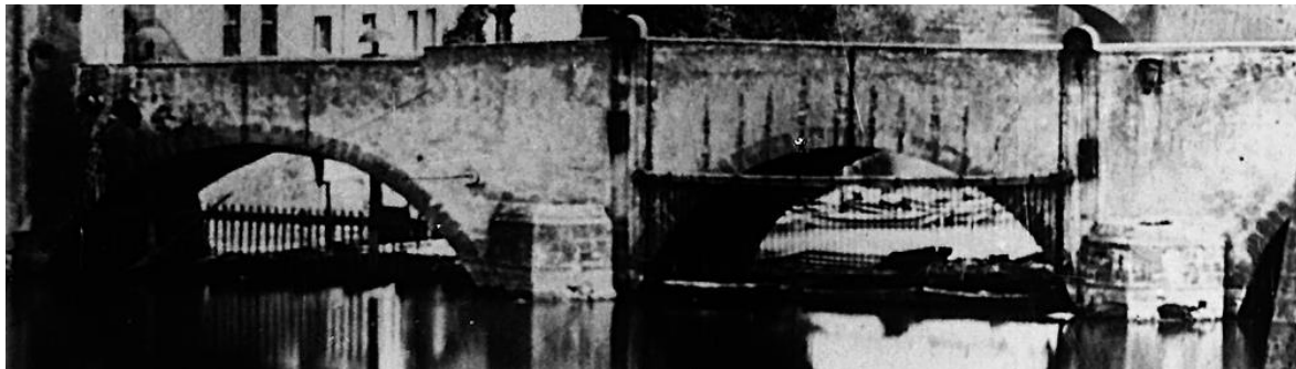
Figure 41 : Le Moyon-Pont à la fin du XIX<sup>e</sup> siècle : agrandissement sur les deux dernières arches du côté de la digue des Pucelles
