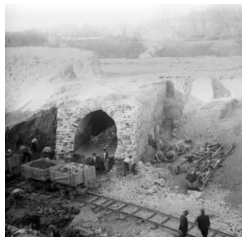
Figure 91 : Destruction du souterrain permettant d'accéder à la tour d'angle de la fausse braie en 1911
