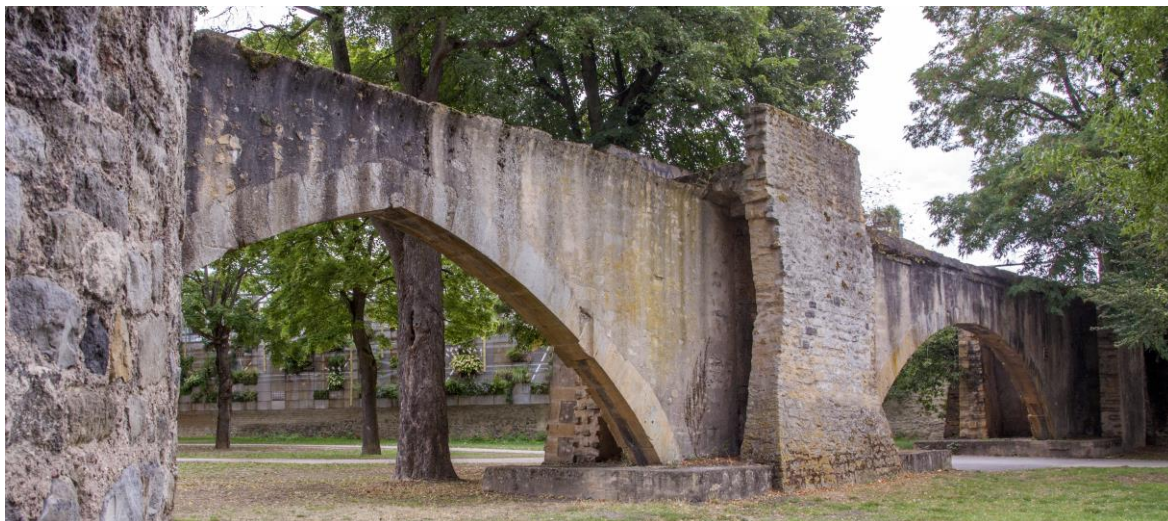
Figure 47 : Le pont des Grilles de la Basse-Seille vu du nord
