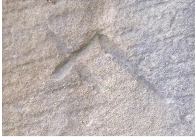
Figure 52 : Un des signes lapidaires sur la face nord du pont, sur l'arc brisé
