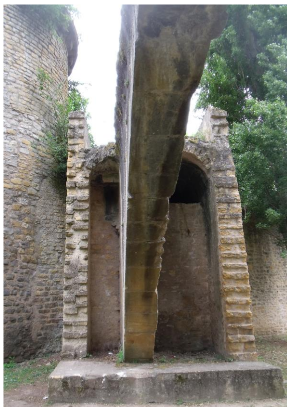
Figure 48 : L'intérieur du pont et les vestiges de la chambre de manœuvre des « baires » sous l'arc brisé, du côté de la tour des Esprits
