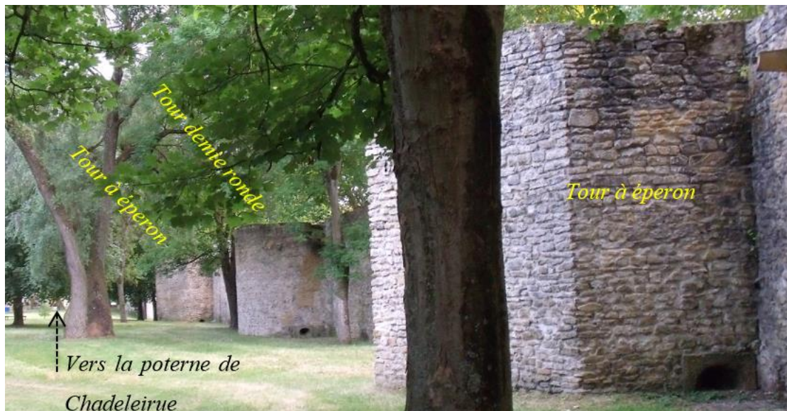
Figure 26 : Front de Seille de l'enceinte messine et les tours de différentes formes entre la poterne de Chadeleirue et la porte du Pont-Rengmont
