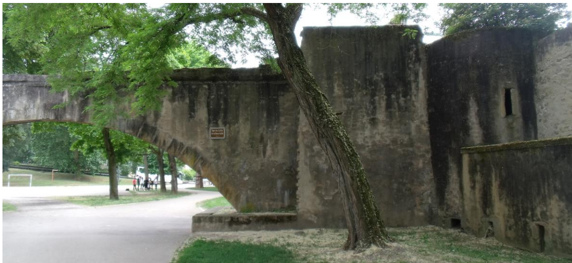
Figure 50 : Le pont des Grilles de la Basse-Seille vu du nord avec la tourelle d'accès au chemin de ronde contre une des tours flanquant la poterne en Chadeleirue
