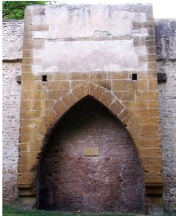
Figure 60 : La bretèche et les trous de boulins sur la Grève
