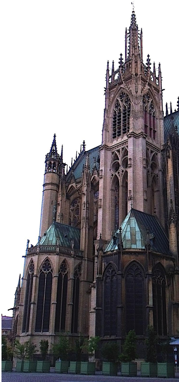
Figure 27 : La tour de Mutte construite contre la cathédrale Saint-Étienne
