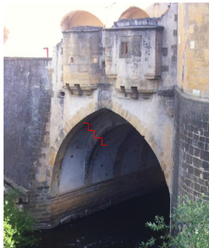
Figure 124 : Les deux bretèches du pont du « baile » de la porte des Allemands et l'accès vers l'ancienne salle de tir du pont
