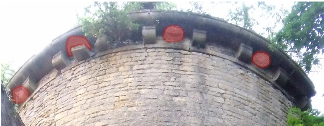
Figure 63 : Détail des mâchicoulis sur la tour des Barbiers et des Chandeliers de cire
