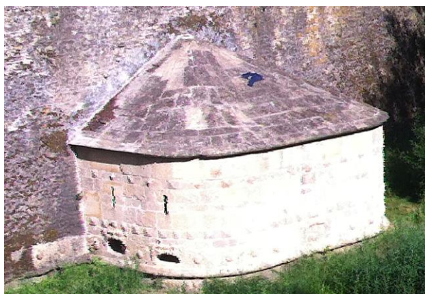
Figure 86 : Le moineau Desch vu depuis le belvédère sur la rive droite de la Seille
