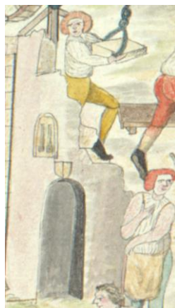
Figure 225 : Une autre représentation d'une porte (ou tour ?) en construction
