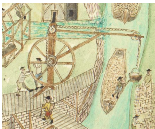
Figure 180 : La livraison et le déchargement des blocs de pierres sur le chantier de l'enceinte d'après les Chroniques messines
