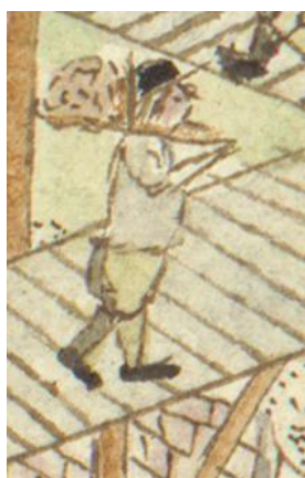
Figure 186 : Manœuvre qui transporte du mortier sur son dos d'après les Chroniques messines
