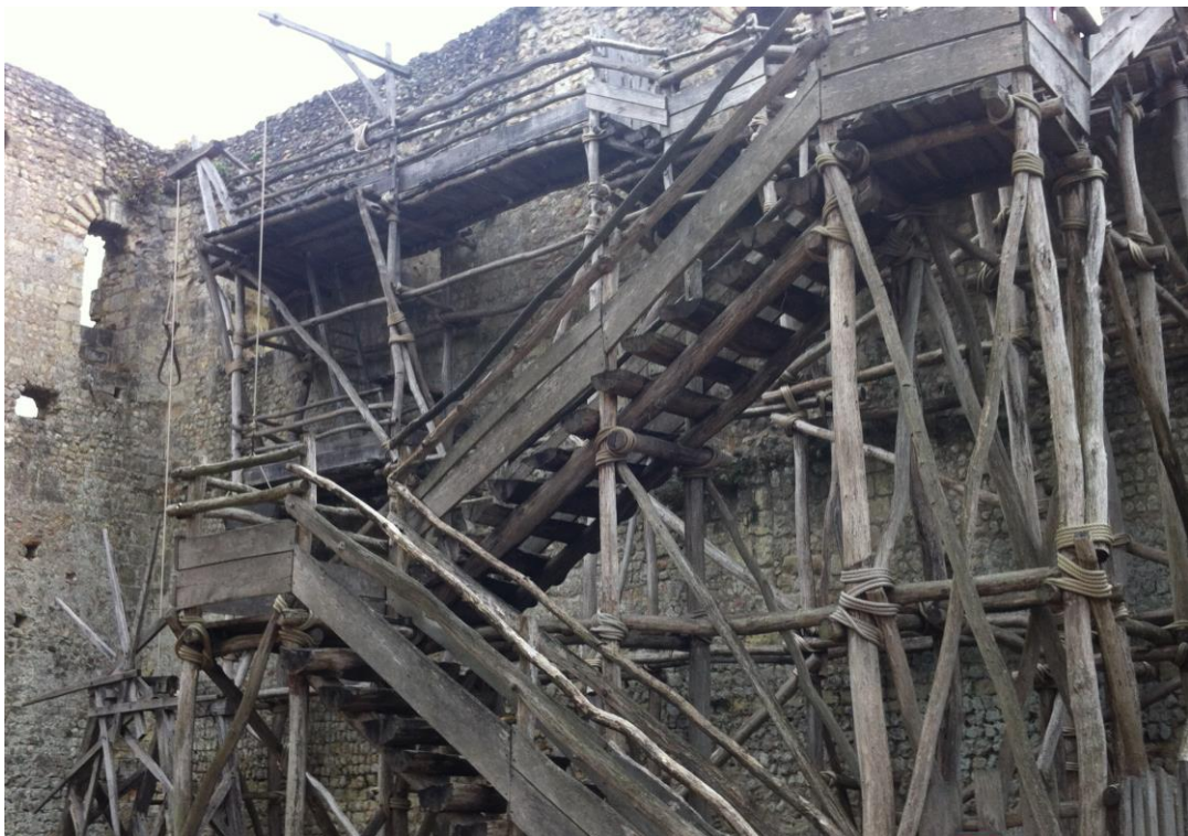
Figure 197: Reconstitution d'un échafaudage médiéval contre le donjon du château de Langeais
