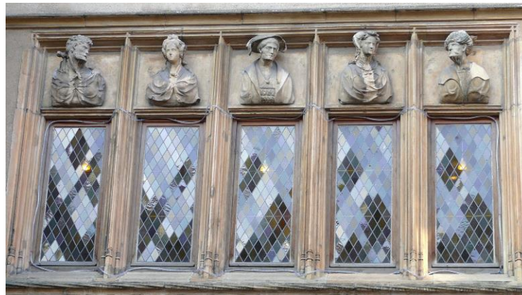
Figure 221 : Les fenêtres à meneaux de la Maison des Têtes (construite en 1529) située en Fournirue
