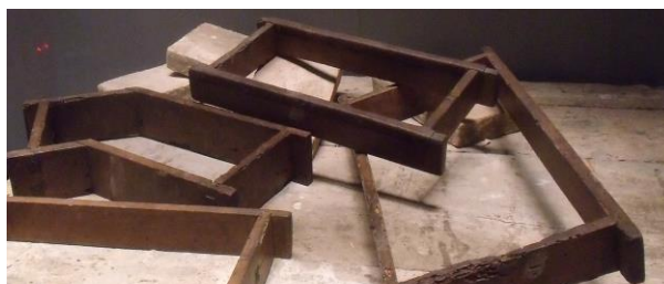
Figure 201 : Différents gabarits (« molles ») utilisés sur le chantier du Dôme de Brunelleschi.
