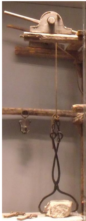
Figure 207 : Treuil sur un échafaudage
