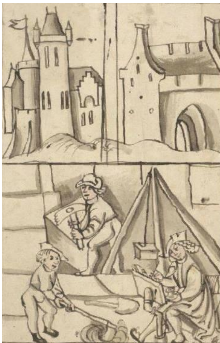
Figure 175 : Un tailleur de pierre, un « mortellier » et le clerc/greffier des Gouverneurs des Murs sur un chantier des fortifications
