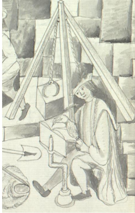
Figure 206 : Chèvre équipée d'une griffe pour soulever des pierres dans les Chroniques messines
